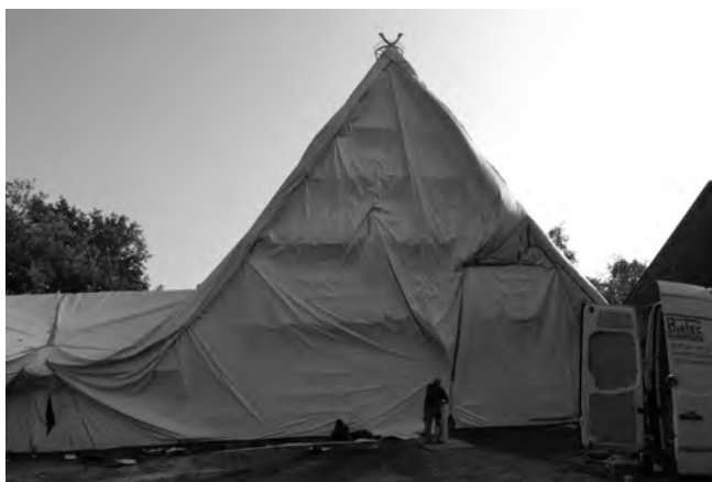
Potírání dřevokazných škůdců: plynování dvora Wehlburg v Muzeu vesnice v Cloppenburgu (foto Michael Schimek)
