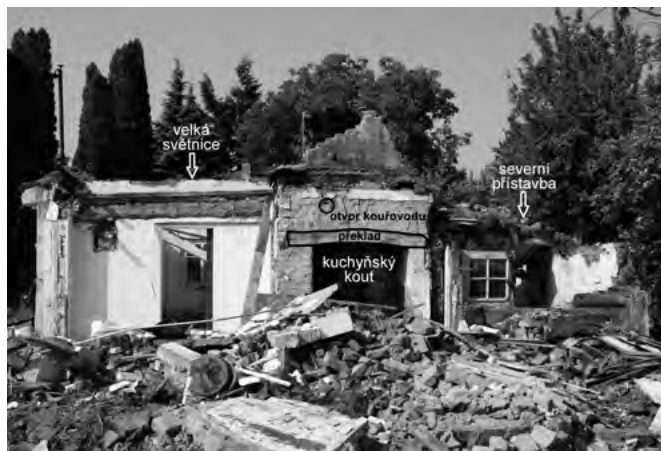
Řez domem čp. 991 na Benátkách při demolicí, s dodatečně vloženým označením prostor a konstrukcí: zazděného otvoru pro kouřovod a dubového překládu, 2018 (foto J. Koudelová)
