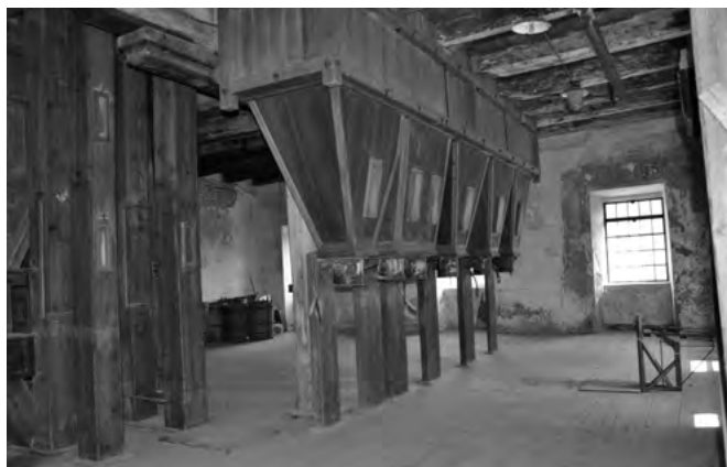
Pohled na válcovou podlahu mlýna, 2022 (foto Petra Hrbáčová)
