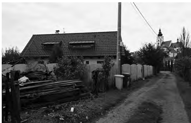
Pohled na novostavbu rodinného domu čp. 991 na Benátkách od jihovýchodu, 2020 (foto J. Koudelová)
