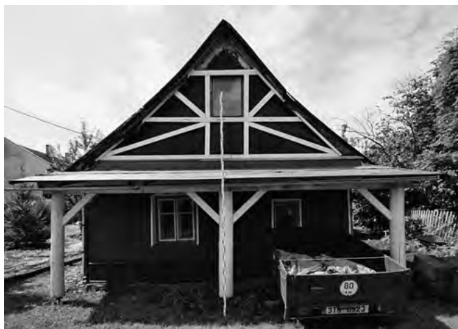
Pohled na východní štítovou fasádu domu čp. 991 na Benátkách před demolicí, 2018 (foto J. Koudelová)
