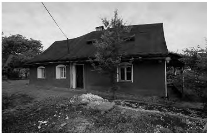
Pohled na jižní průčelí domu čp. 991 na Benátkách před demolicí, 2018 (foto J. Koudelová)
