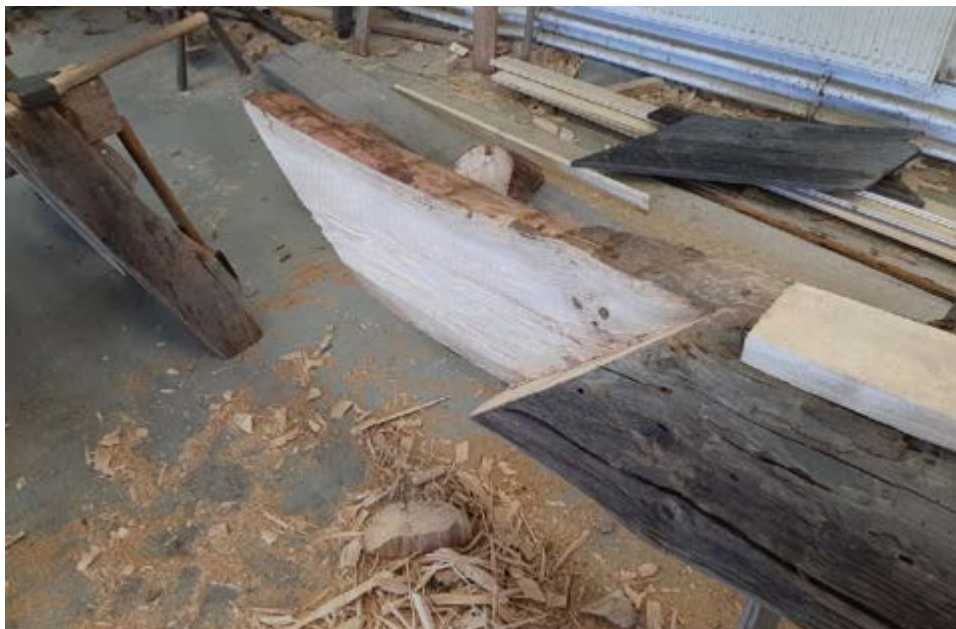
Oprava trámu roubení se svislým šikmočelým plátovým spojem a dubovými kolíky
