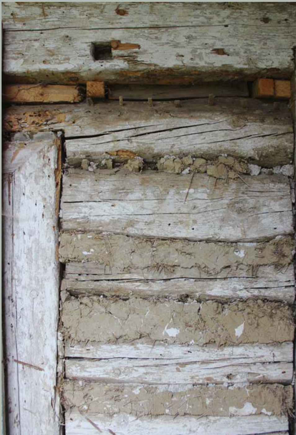
Babice u Kelče čp. 7, detail stěny síně s původním sloupkem dveří, hliněným výmazem spar a zbytky vápenných líček, později opatřená omítkou na šikmém lištování • 2017
