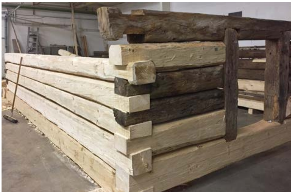
Postupné sestavování srubové konstrukce v kryté hale Valašského muzea v přírodě
