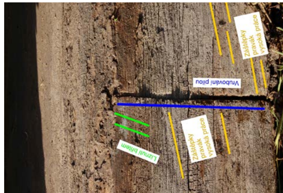
XXX Detail vrubování prahového dubového trámu pilou
