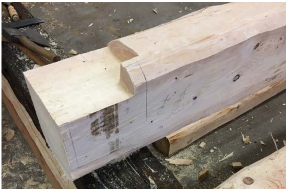
Sesazování originálních a nových prvků s vnitřním zámkem
