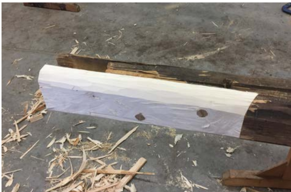
Oprava hřebenového spoje krokve
