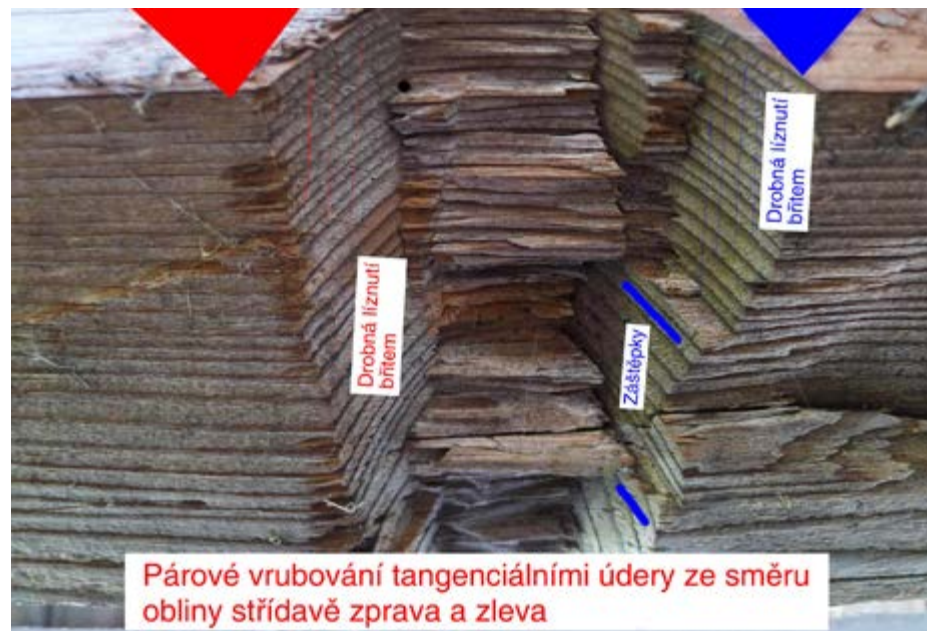
R Detail stop po vrubování dvěma tesaři – údery jsou vedené střídavě proti sobě
