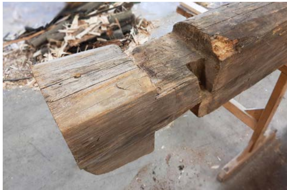
Originální horní nárožní spojení s vnitřním zámkem
