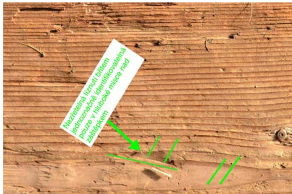
D Další, ještě méně zřetelné stopy po šířčině
