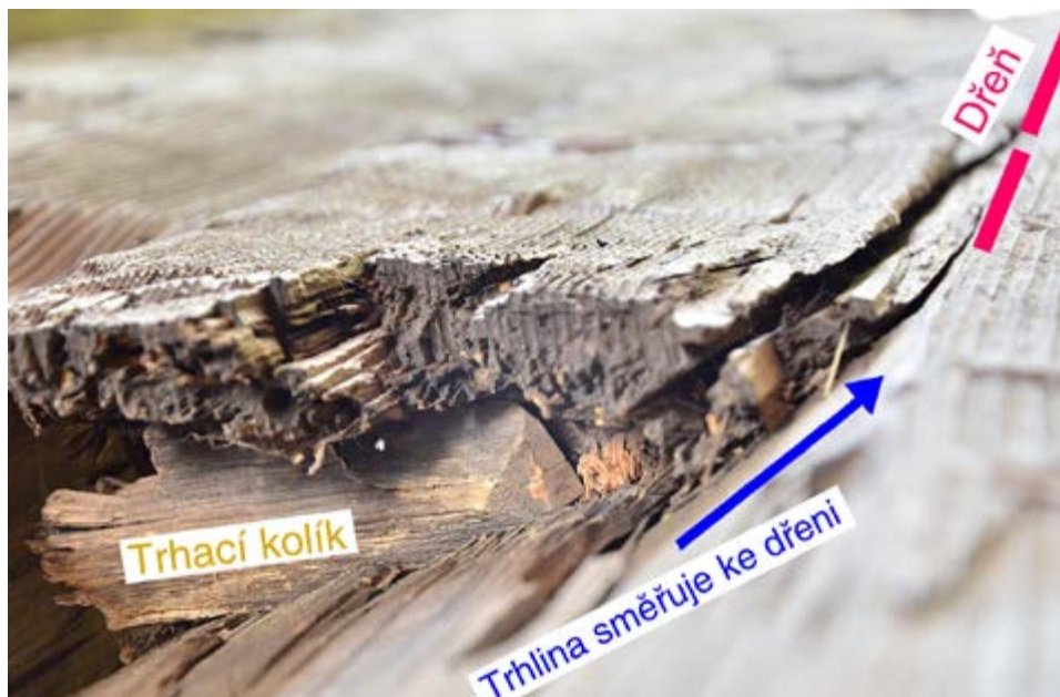
X Zbytek kolíku sloužícího patrně k regulaci směru štěpu při drani
