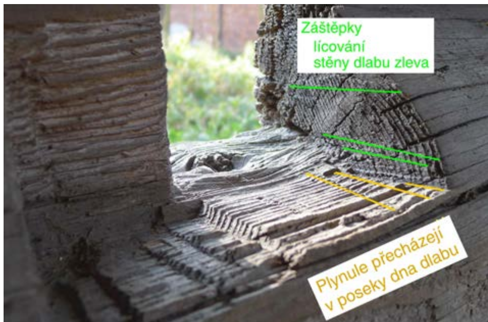
Z Přístupný spoj vyrobený podle zřetelně dochovaných stop pouze sekerou
