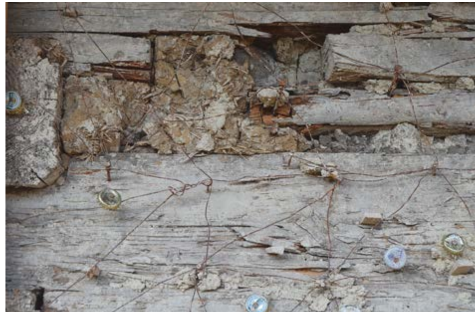
Rymice Hejnice čp. 65, detail štípaných sрубnic s mazaninou, zbytky původního kolíkování i novějších nosičů omítky • 2019
