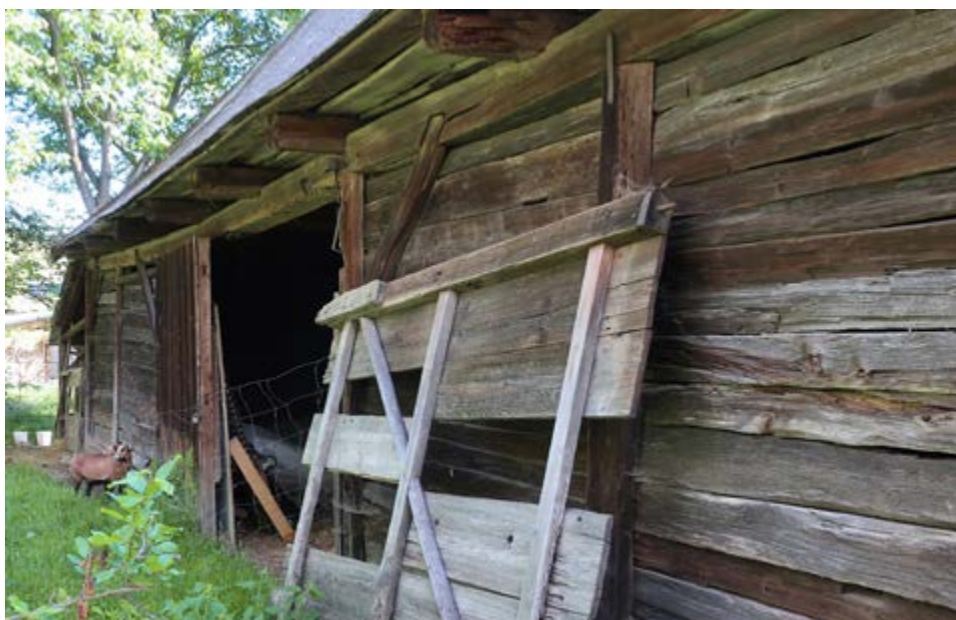
Pohled na západní část stodoly z jihozápadu • 2022
