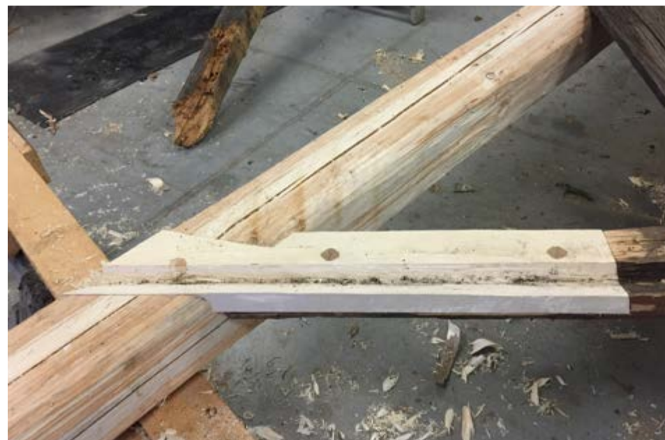
Oprava kleštiny s drážkou pro osazení šindelů částečné valby – „obháčky“
