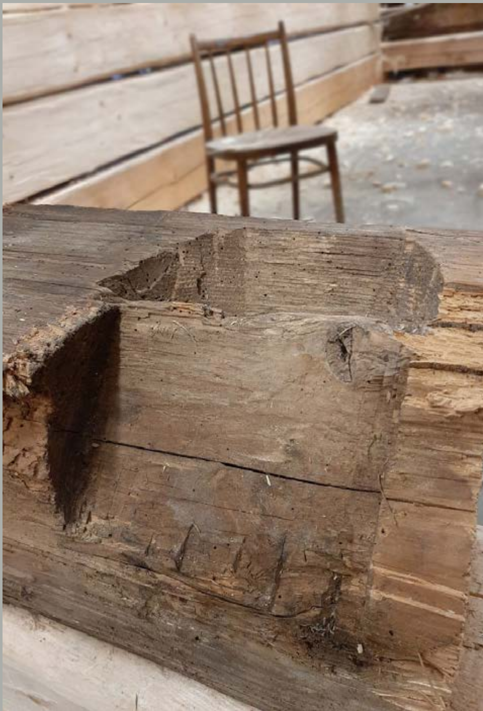
Na objektu zimiarky byly patrné různé příklady osedlání krokví na podkrokevnici
