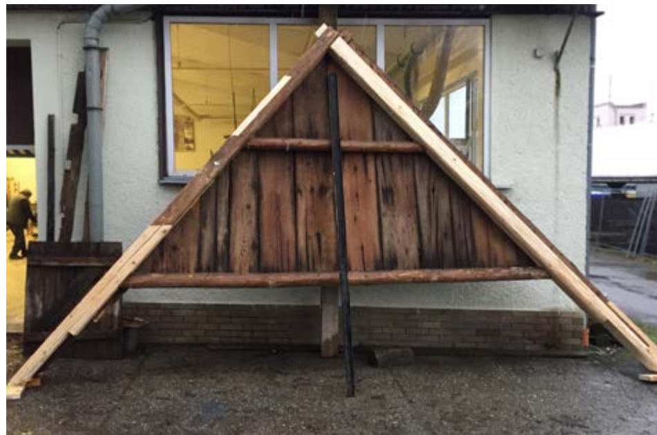
Oprava štítu se snahou o zachování maxima originálních konstrukcí
