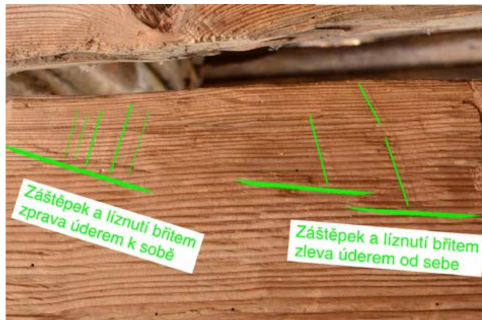
N Při hodnocení jednotlivých stop je třeba brát ohled na tloušťku odsekávané líce i míru stáčivosti (trhliny na líci, zatržení a odseky na hraně, výsušné trhliny na oblině)
