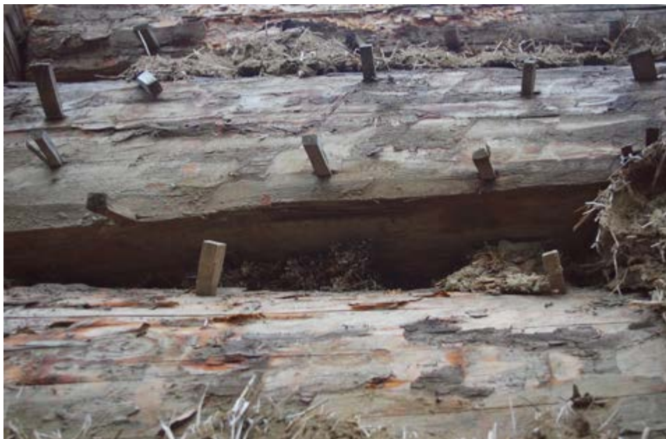
Přerov-Dluhonice čp. 10, fragment roubené stěny s patrnými zbytky hliněné omítky, mechem na vyplnění spár srubu, kolíky "ježky" jako oporou pro hliněnou omítku • 2017
