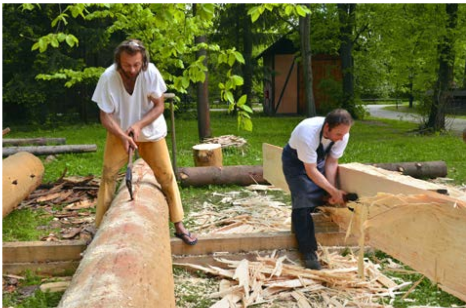
Lícování vnitřní štěpné plochy a příprava další kulatiny ke štípání • 2017
