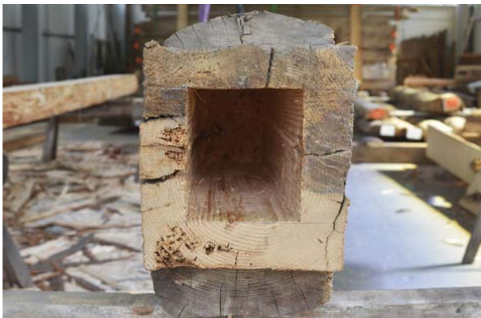
Originálně pojatá oprava nárožního spoje z původního materiálu se snaží spojit funkčnost a nenápadnost tesař David Stejskal, stodola ze Skaličky • 2021
