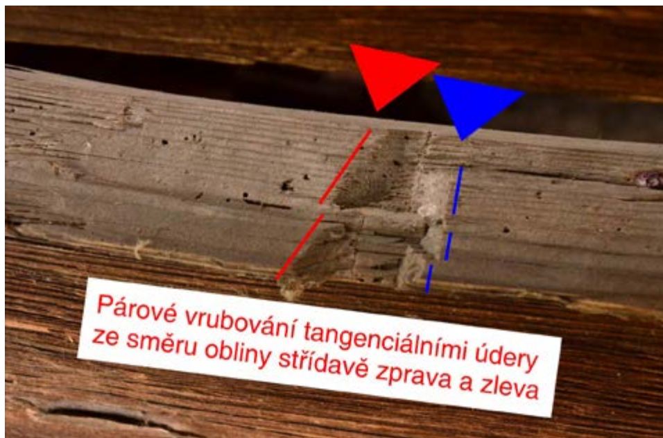
P Stopy po vrubování dvěma tesaři – údery jsou vedené střídavě proti sobě (párové vrubování)
