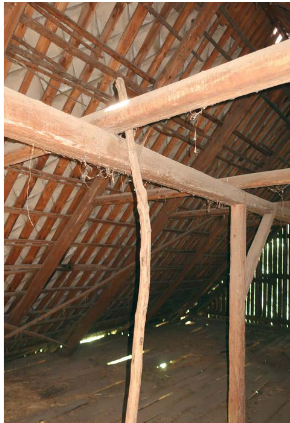
Detail konstrukce střechy • 2022
