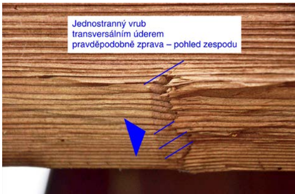
U Stopa po vrubování jedním tesařem – jednostranný vrub vytvořený dvěma záseky
