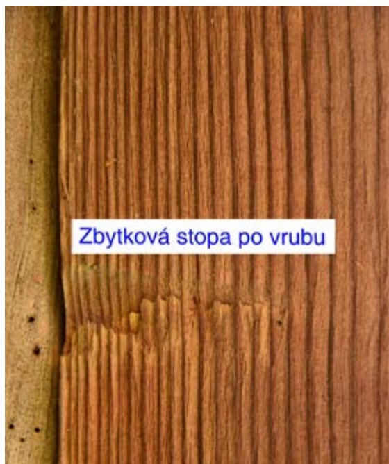
M Odseky odštípnutých hranových vláken provedené už pravděpodobně šířinou, jedním úderem
