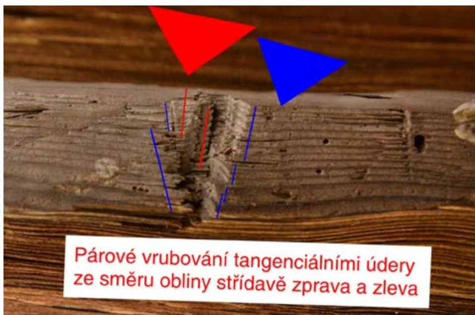
Q Stopy po vrubování dvěma tesaři – údery jsou vedené střídavě proti sobě (párové vrubování)
