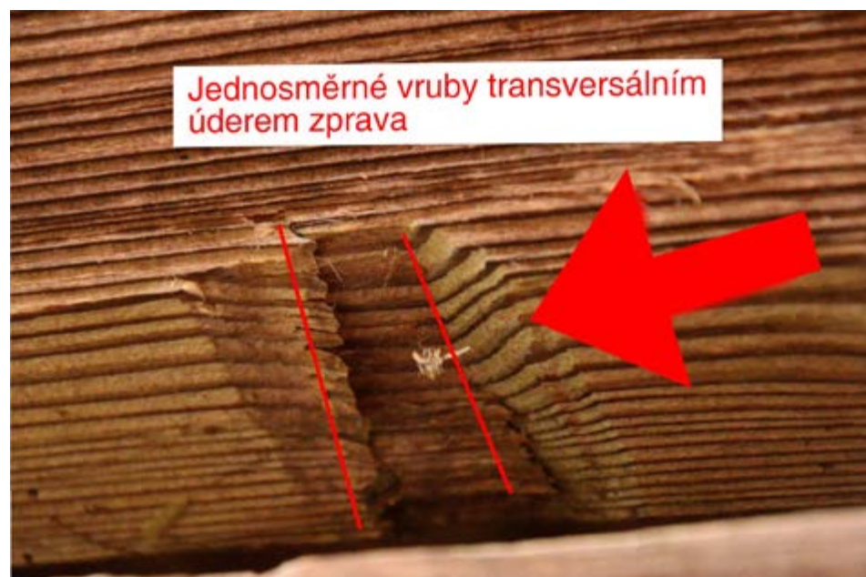
S Stopy po vrubování jedním tesařem – údery jsou vedené z boku šikmo do líce
