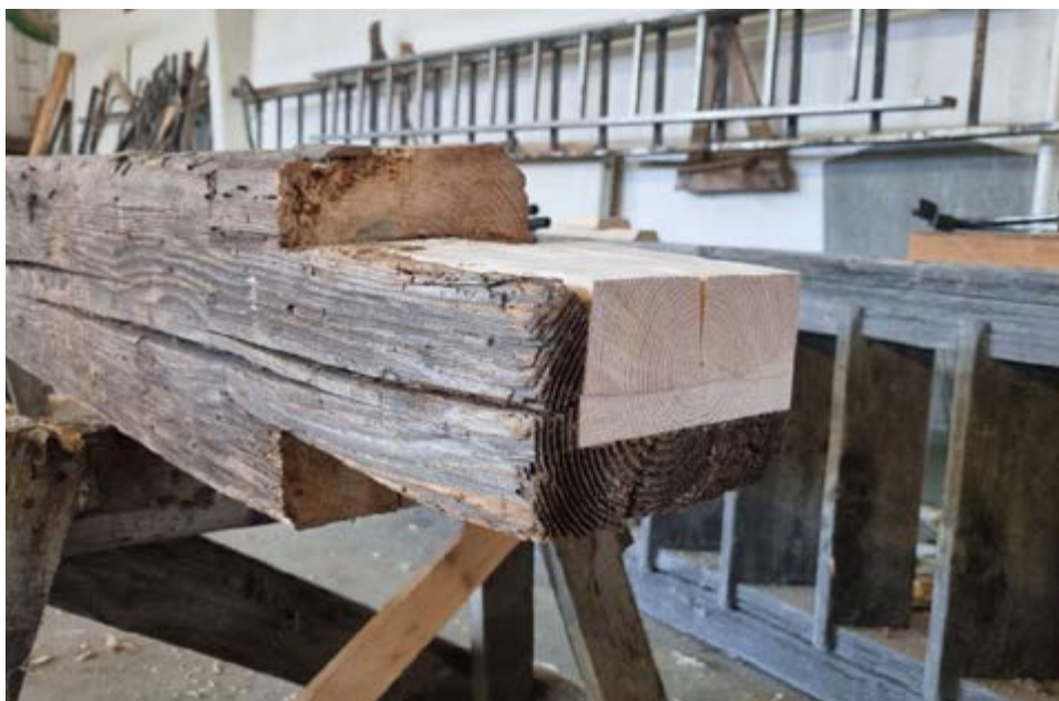
Vložka rohového plátu se snahou o zachování maxima originálního prvku
