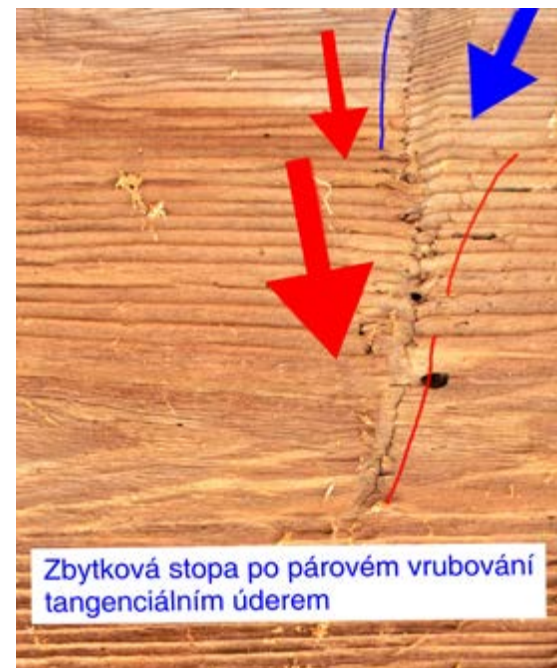
K Odstraňovaná vrstva s odtrženými vlákny byla natolik omezující, že ji tesař nemohl krátit
