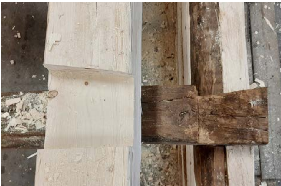
Jednostranné rybinové spojení stropního trámu a srubu
