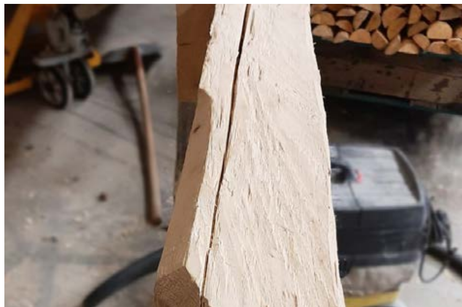
Nově vyrobená krokev s protikusem sedla
