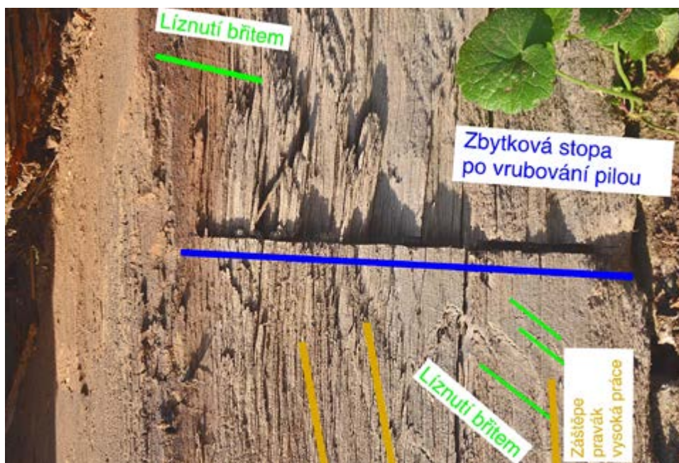
XX Příčný vrub na prahovém dubovém trámu vytvořený pilou
