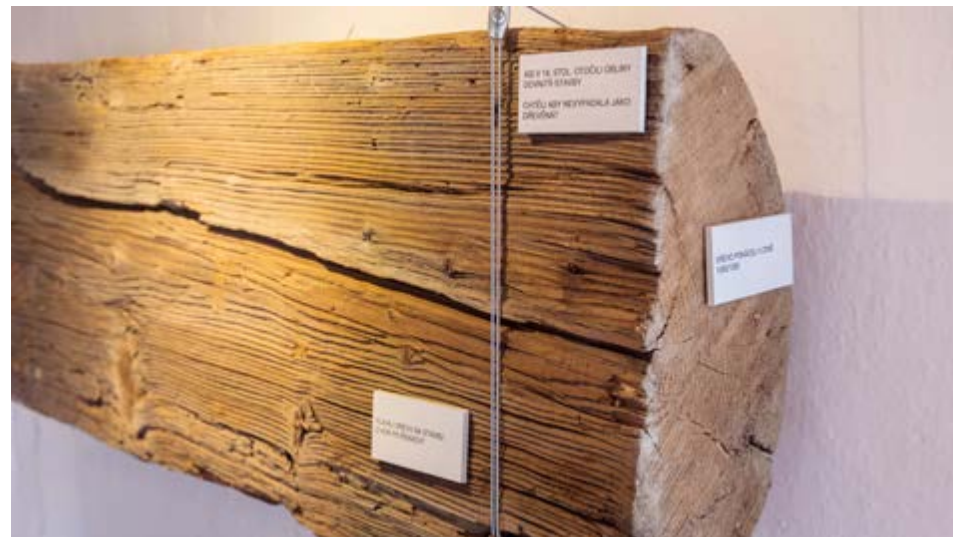
Každá stavební konstrukce nabízí četné otázky i odpovědi půlený trám stodoly ze Skaličky, výstava Zranitelné stavební dědictví, HMP Příkazy • 2023
