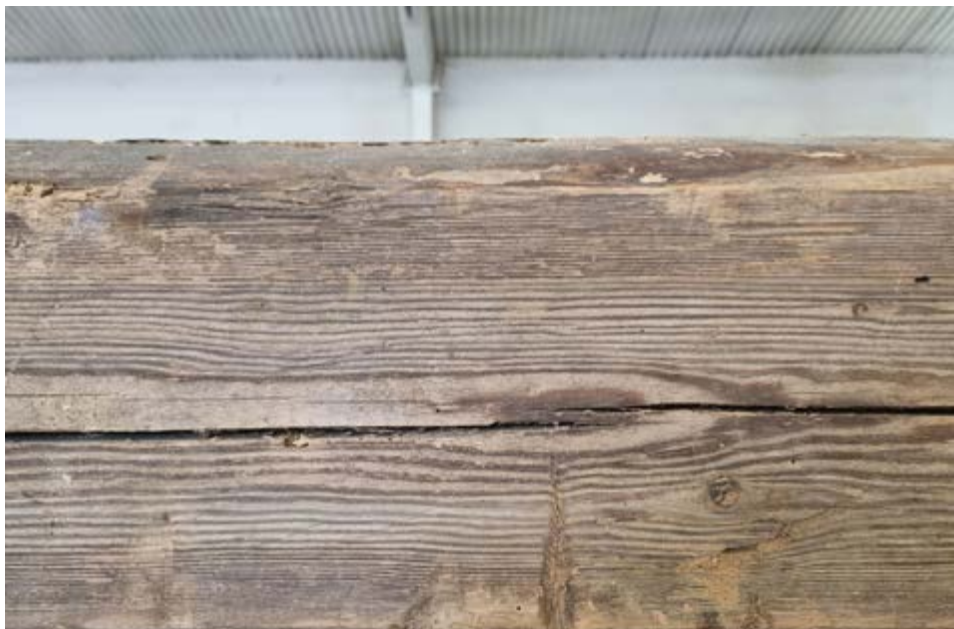
Stopy po vrubování na originálním prvku roubení zimiarky
