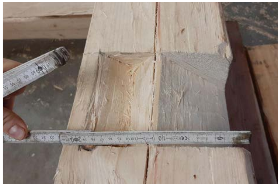
Kopírování osedlání krokve
