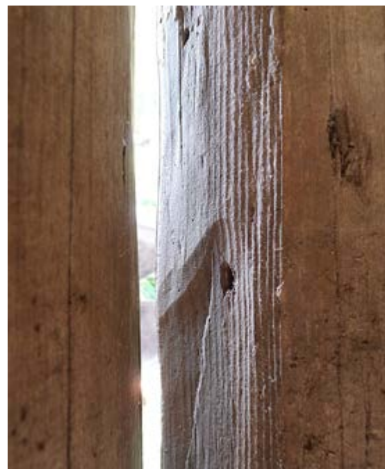
N Při hodnocení jednotlivých stop je třeba brát ohled na tloušťku odsekávané líce i míru stáčivosti (trhliny na líci, zatržení a odseky na hraně, výsušné trhliny na oblině)
