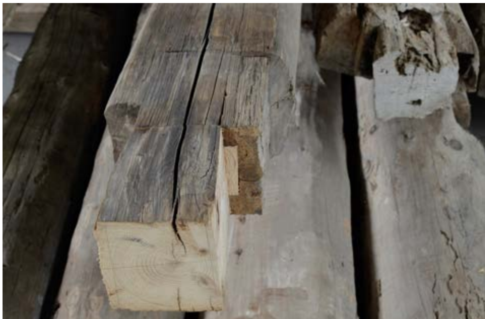
Originálně pojatá oprava nárožního spoje z původního materiálu se snaží spojit funkčnost a nenápadnost tesař David Stejskal, stodola ze Skaličky • 2021
