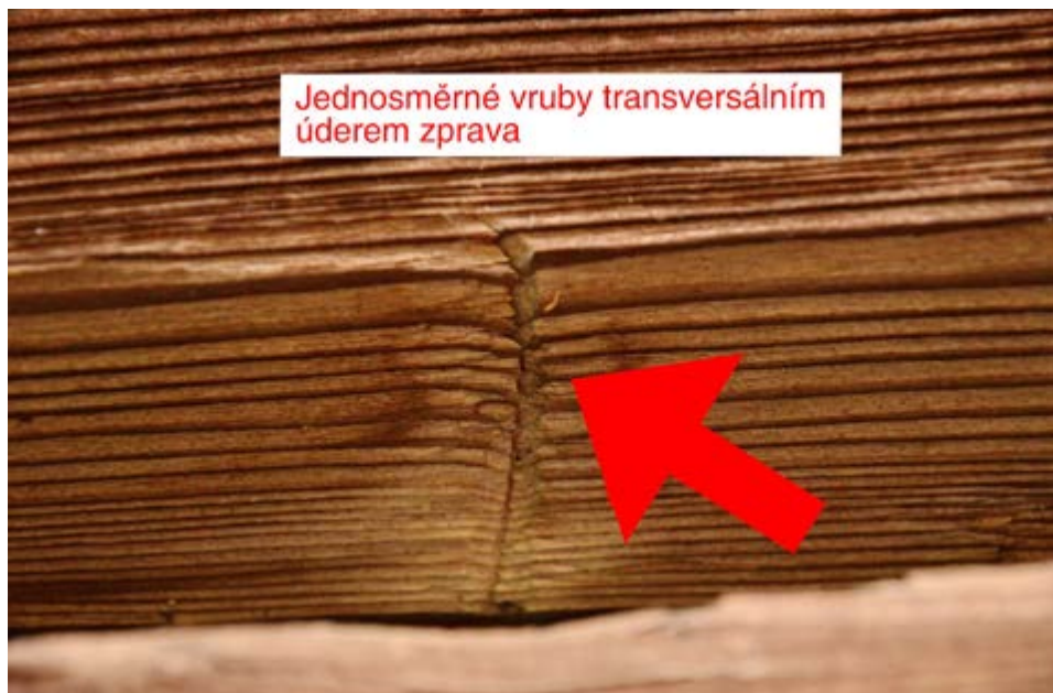
T Stopa po vrubování jedním tesařem – jednotlivý úder vedený z boku šikmo do líce
