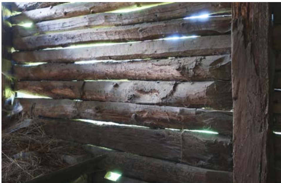
Detail rámové výplně. Pohled zevnitř • 2022
