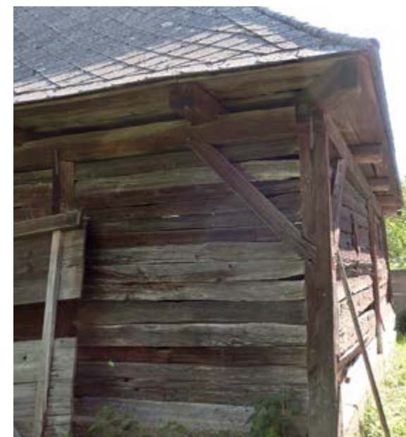
Pohled na jihozápadní roh stodoly • 2022
