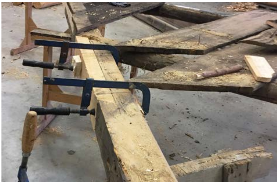
Hřebenový plát původní a nové krokve zajištěny dřevěným kolíkem
