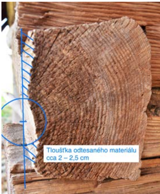
A Určení přibližné tloušťky vrstvy odtesané z radiálně půleného trámu
