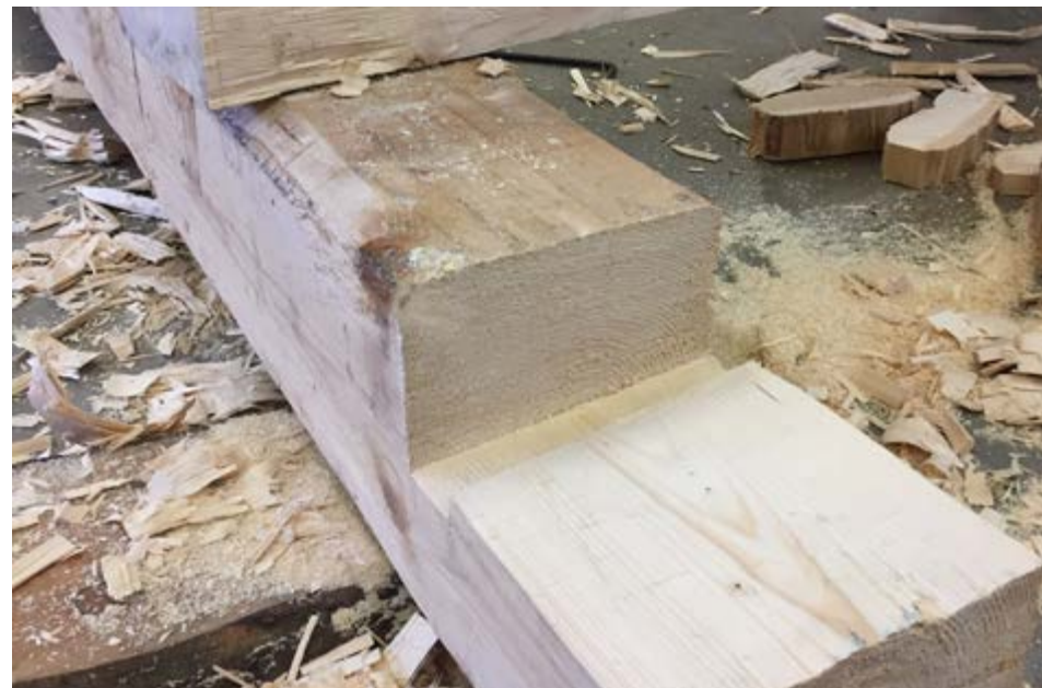
Spoj prahových trámů vyráběný podle originálu
