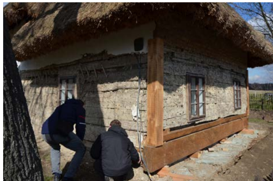
Rymice Hejnice čp. 65, památkově chráněná usedlost v rámci areálu muzea v přírodě s roubenou konstrukcí světnice z půlených kmenů s odhalenou omítkou během rekonstrukce • 2019
