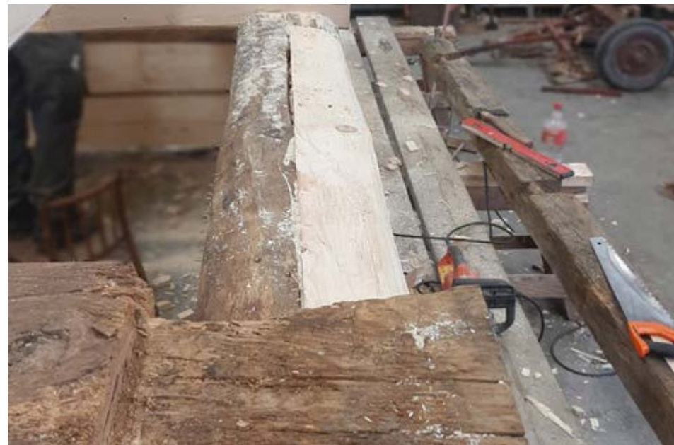
Spoj stropních trámů a srubu před osazením podkrokevnice
