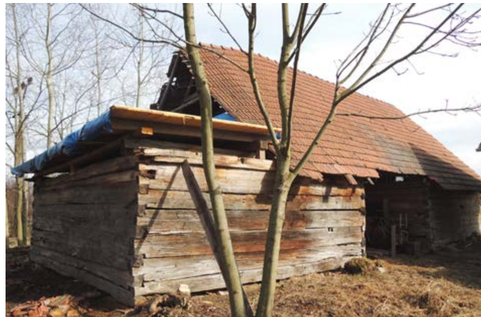
Stodola ve Skaličce po provizorním zakrytí a vykácení náletových dřevin • 2017
