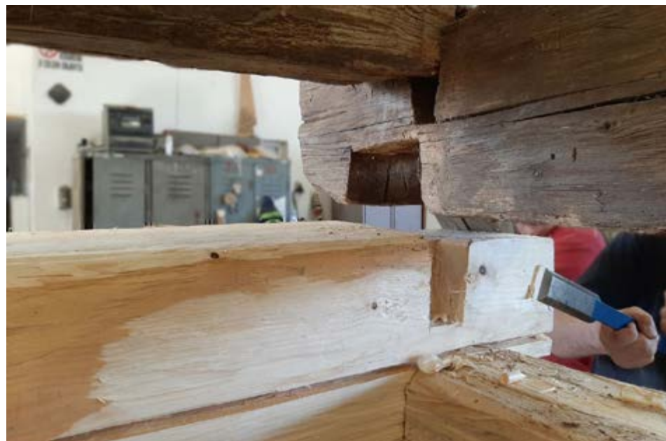
Snaha o přesné sesazení horní partie nároží srubu
