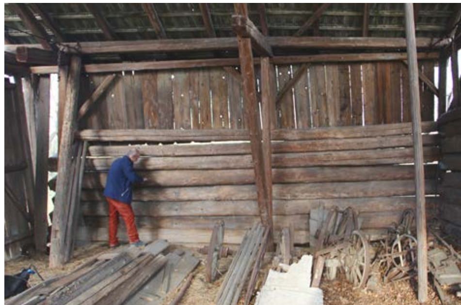
Pozoruhodné stáří některých konstrukcí bylo zjištěno díky dendrochronologickému datování Tomáše Kyncl • Oprostovice 2015
