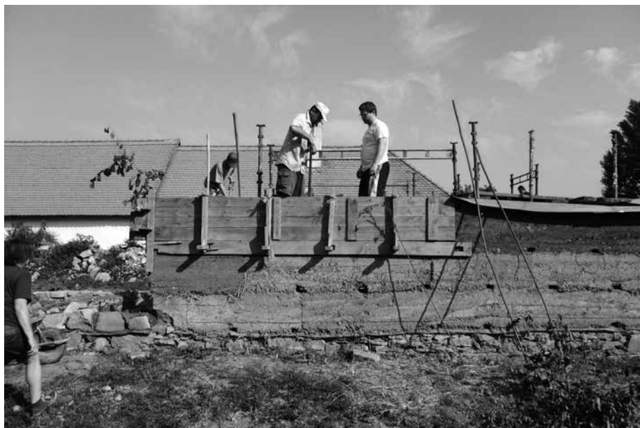
Stavba nabíjených hliněných stěn během workshopu Použití hlíny ve venkovském stavitelství v Muzeu vesnice jihovýchodní Moravy, 2013, foto R. Bryol
