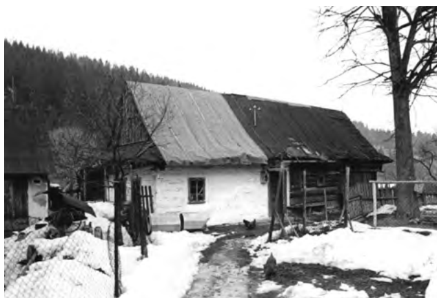
Objekt č. 217 v Turzovke (Zámer obnovy pamiatky, c.d.)
