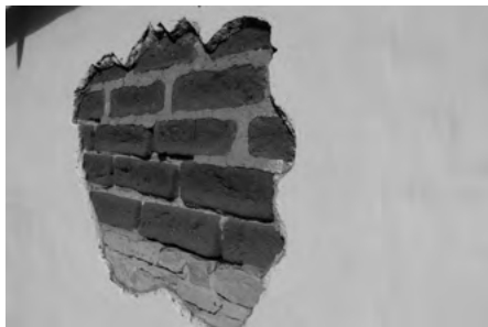
Ukázka nepálených cihel na chalupě z Chvalovic, 2022 (foto Vít Smrčka)
