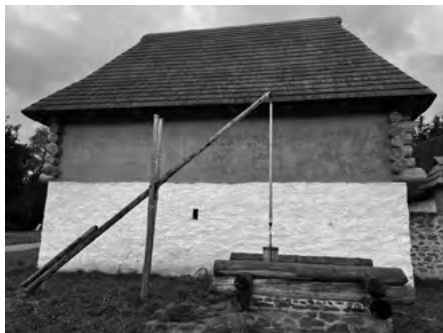
Pohled z „návisi“ na sýpku ve dvorci, v popředí s pumpou nad studní, 2022 (foto Ivan Náprstek)
