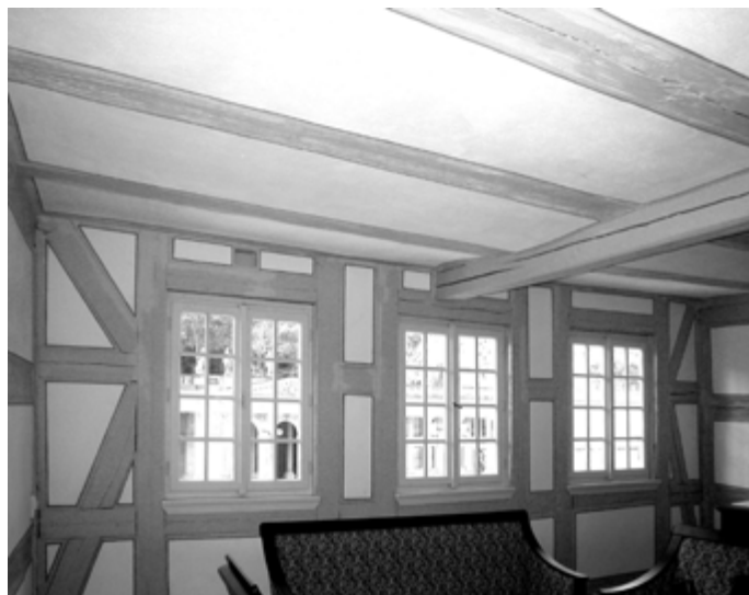
Karlovy Vary, dům Petr čp. 85, barevnost hrázděné konstrukce v interiéru, 2004 (foto L. Zeman)
