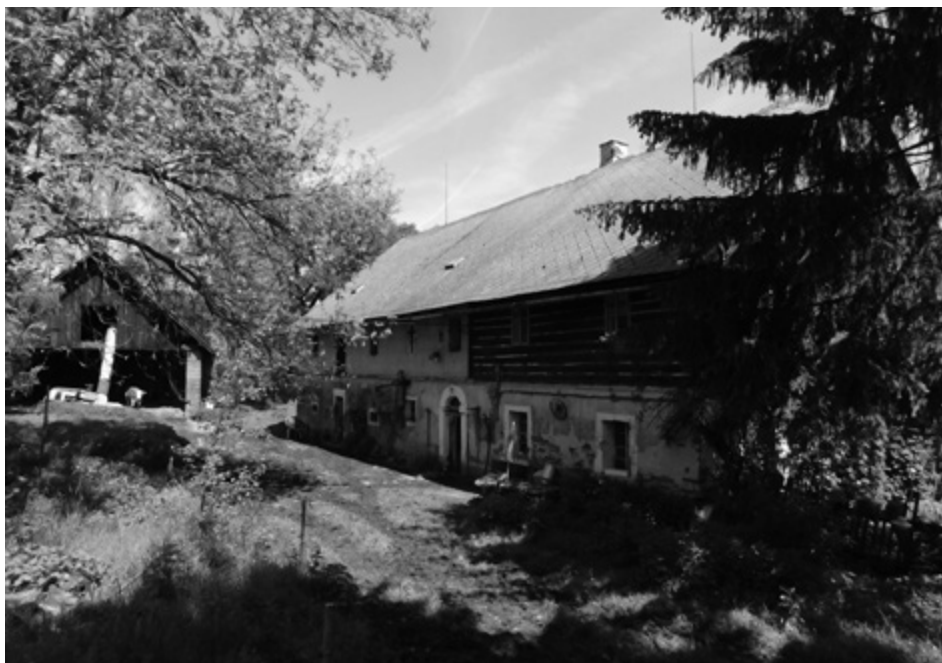
Celkový pohled na hlavní budovu hospodářství Radelbauer čp. 27 v Dolní Polici, v pozadí pilířová stodola (všechny fotografie K. Konopka, 2018–2020)
