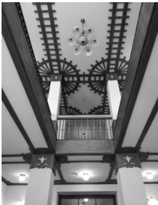
Vstupní hala Jurkovičova domu v Luhačovicích z roku 1902 po rekonstrukci (foto D. Novotný 2018, archiv KGVU ve Zlíně)
