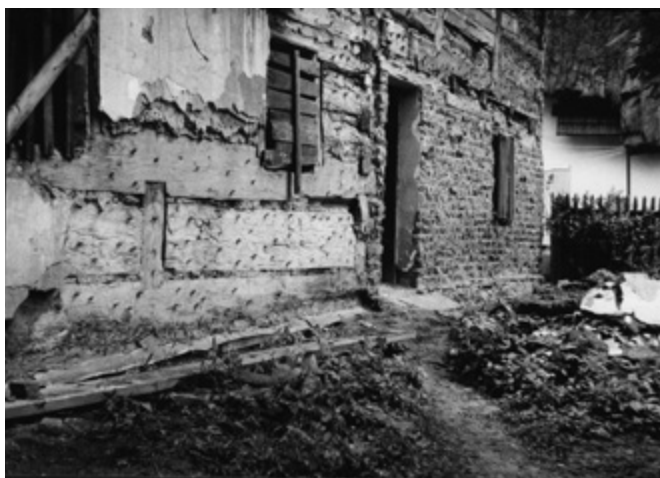
Dům čp. 64 na Hejnici. Stav během rekonstrukce v roce 1989, kdy došlo k odkrytí roubených stěn jizby a horní komory (Muzeum Kroměřížska, podsbírka Dokumentace regionu)
