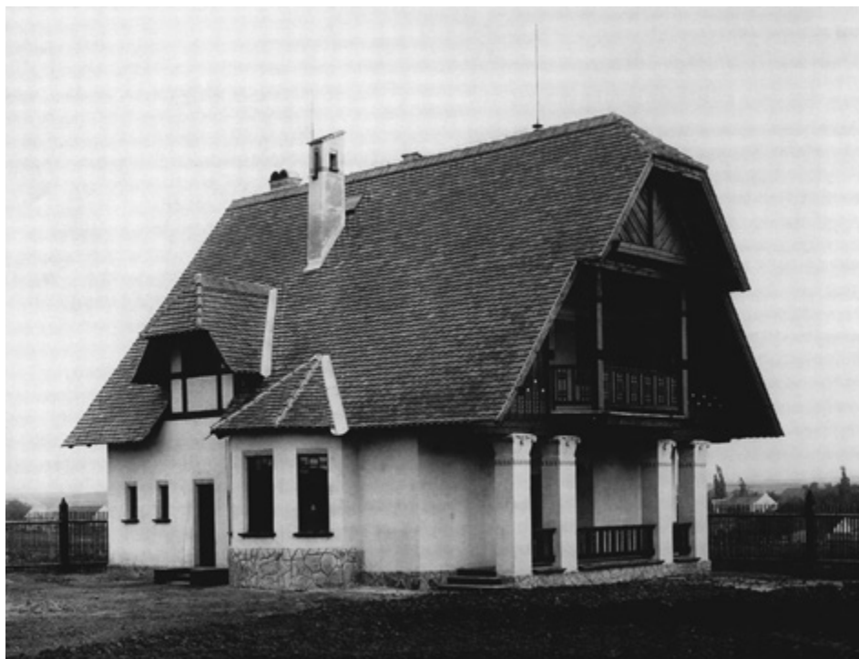
Jan Kotěra: Trmalova vila v Praze-Strašnicích, 1902–1903 (archív Foibos)
