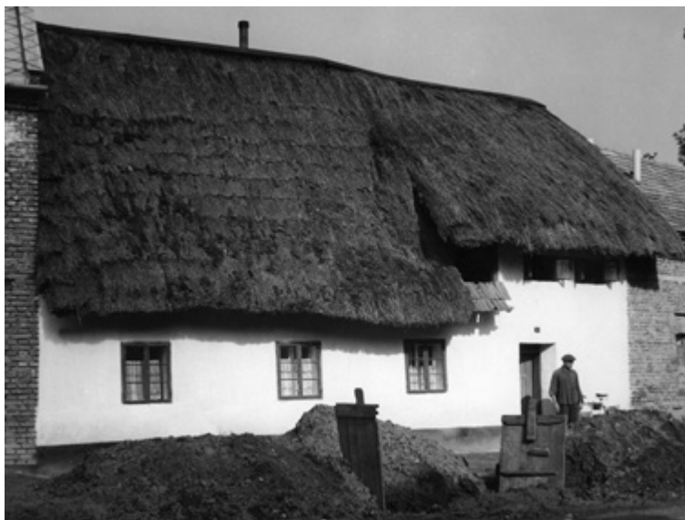
Dům čp. 6 (Klimečkov) před rekonstrukcí. 60. léta 20. století (Fotoarchiv NPÚ, ÚOP v Brně)
