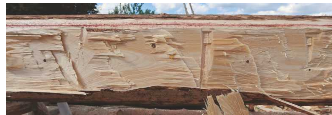
27 | Povrch líce po hrubování při postoji na kulatině
