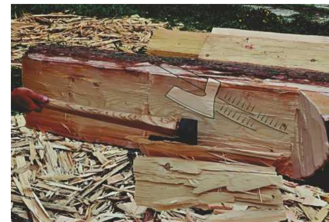
39] Povrch líce po hrubování pomocí bradatice
