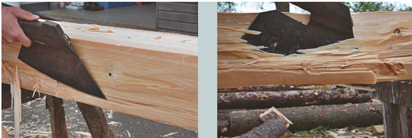
18 ] Při nepříznivé točitosti má tesař nakloněnou sekeru na špičce, prosekává hranu a couvá
