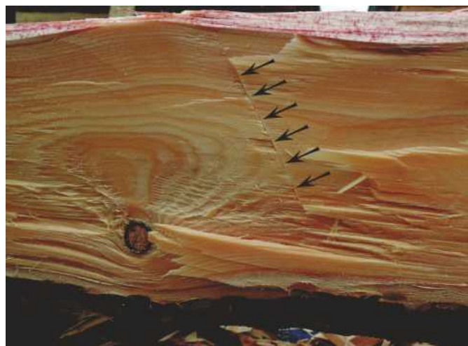
14 ] Šikmé proseknutí plochy líce tesaného prvku při vrubování šířčinou
