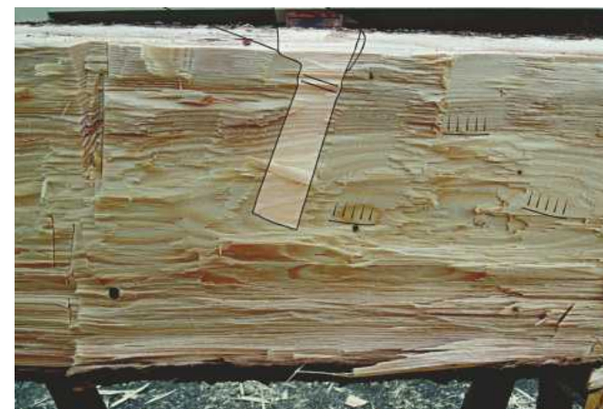
37] Povrch líce po hrubování pomocí hlavatky
