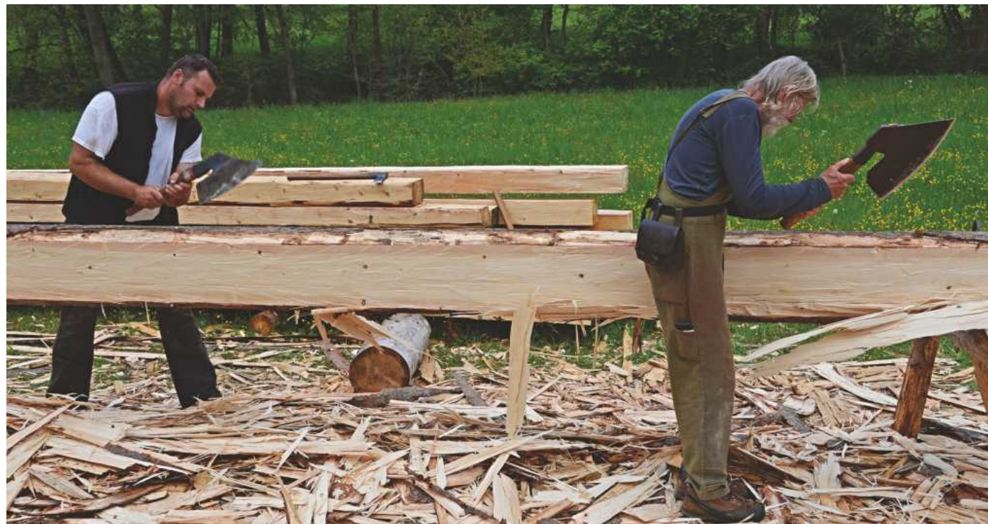
40] Práce praváka a leváka při lícování na jednom prvku
