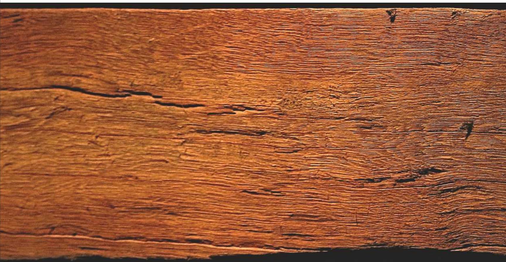
4] Stopy po tesání vysokou prací na dubovém prvku krovu presbytáře magdeburského dómu
