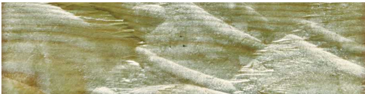
Podobné stopy opracování bradaticí se nacházejí na vazném trámu krovu kostela Všech svatých v Praze-Slivenci z roku 1323.
