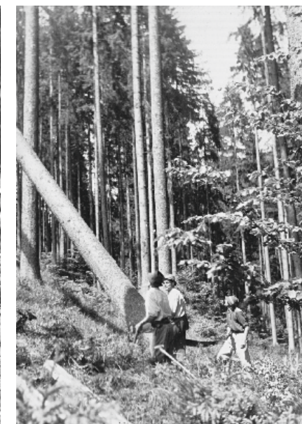
Kácení lesního stromu, Dolní Lomná, místní část Tatínky. Vbíjení dřevěného klínu do zářezu a shazování stromu 1950, foto J. Zahradník a Zd. Straka, Ostravské muzeum, Etnografický fotoarchiv, album 342/113-115, film VIII.2 a VIII.1
