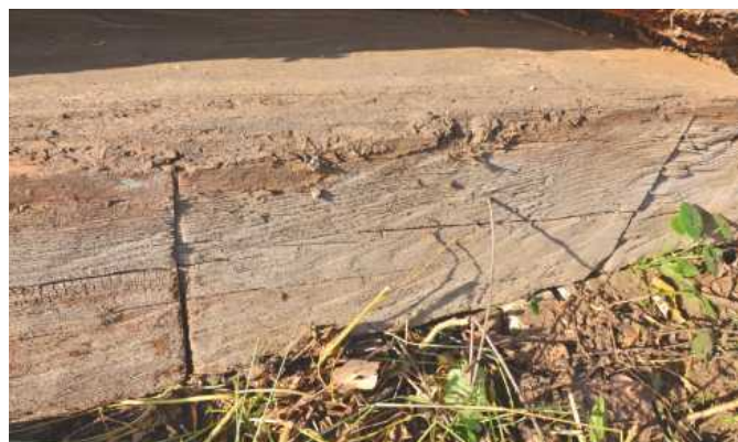
25 | Stopy po vrubování pilou příčnicí
