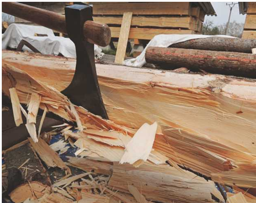
2] Tesání kulatiny nízkou prací pomocí sekery na dlouhém toporu
