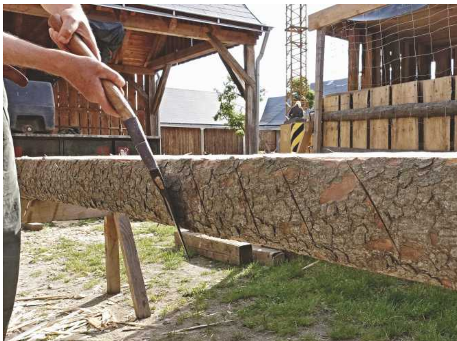
24 | Vrubování pomocí šikmých poseků šířčinou
