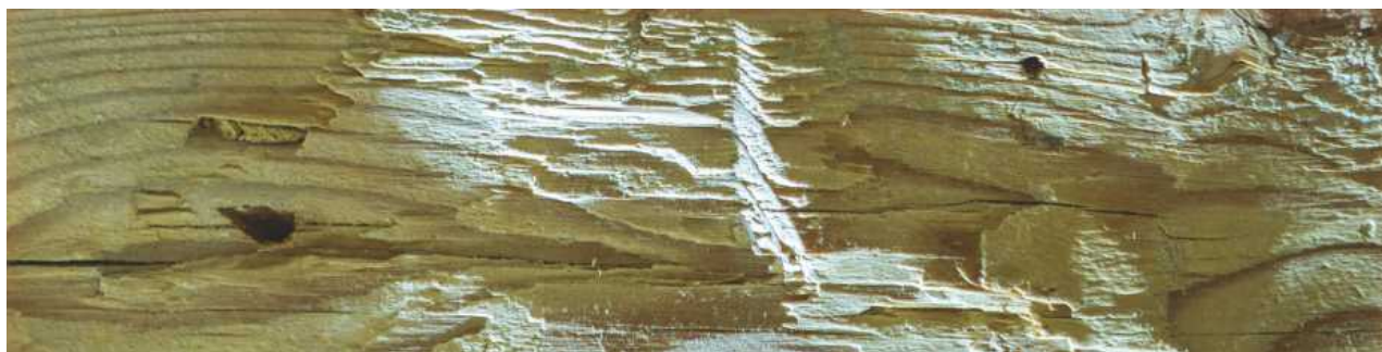
Stopy opracování hlavatkou na vezděném překladu z roku 1846 v bývalé poustevně při poutním kostele Panny Marie Pomocné v Teplicích nad Metují. Na této stavbě je výjimečné, že původní roubené stěny z roku 1753 byly na pohledových stranách otesány pouze hlavatkou. Hrubý povrch zmiňuje jen zalíčení vápnem.
