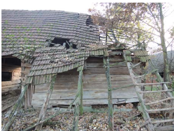
Obr. 6 Severní stěna západní části stodoly
