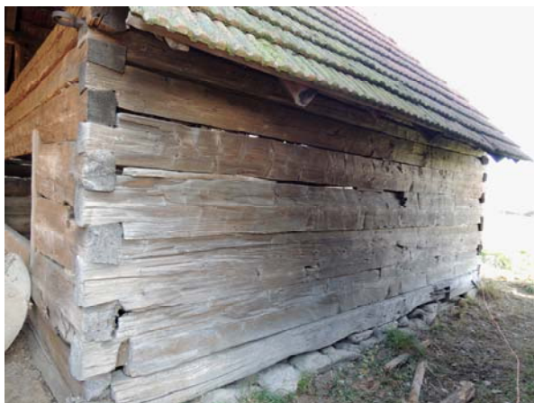
Obr. 8 Jižní stěna východní části stodoly
