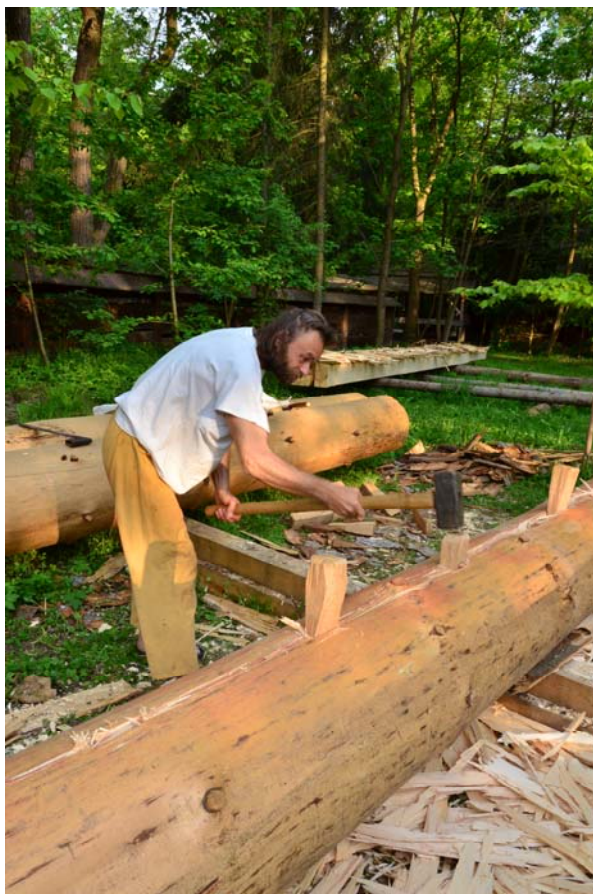
Obr. 24 Postupné zatloukání klínů při štípání
