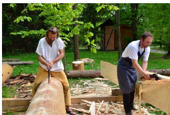
Obr. 27 Lícování vnitřní plochy a příprava další kulatiny ke štípání
