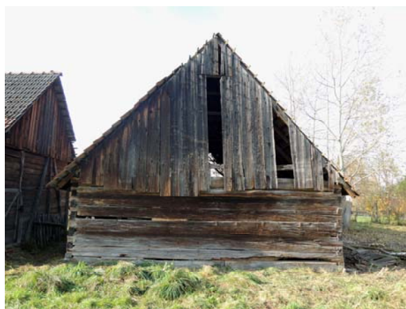
Obr. 11 Východní stěna východní části stodoly
