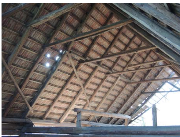
Obr. 12 Celkový pohled do krovu od severovýchodu
