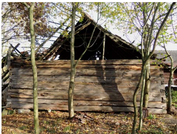
Obr. 5 Západní stěna západní části stodoly
