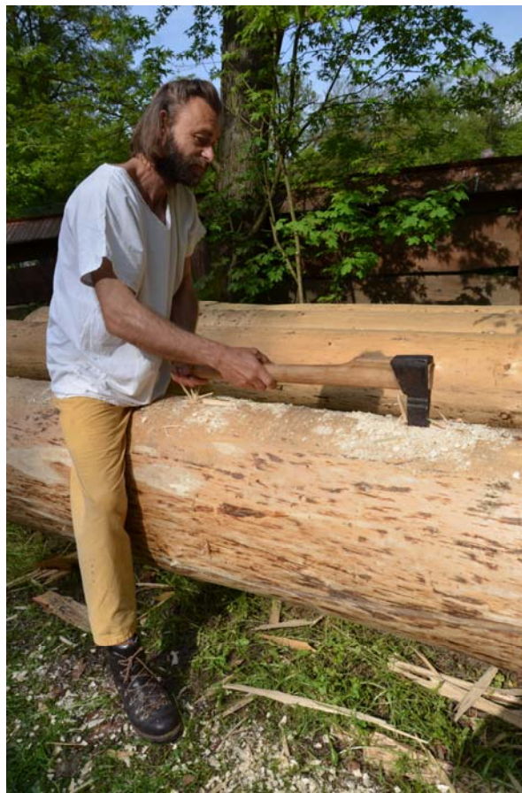
Obr. 21 Dlabání lůžka pro vkládání klínu
