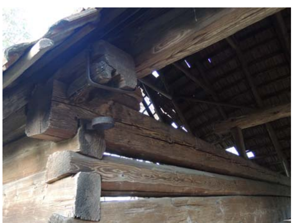
Obr. 13 Detail točnice vrat na jižní straně stodoly
