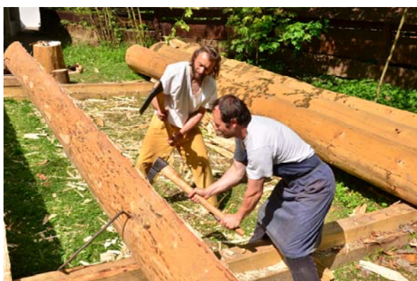
Obr. 26 Vrubování vnitřní plochy po štípání
