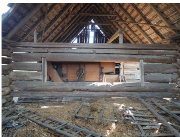
Obr. 7 Východní stěna západní části stodoly
