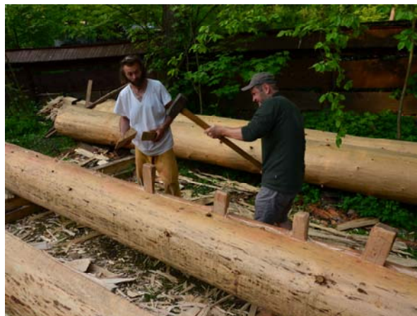
Obr. 23 Vkládání klínů do připravených dlabů
