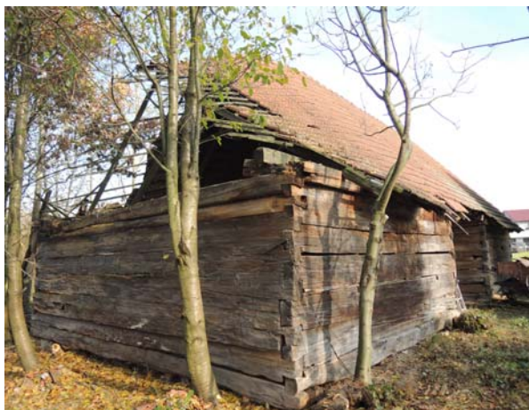
Obr. 2 Jihozápadní pohled na stodolu
