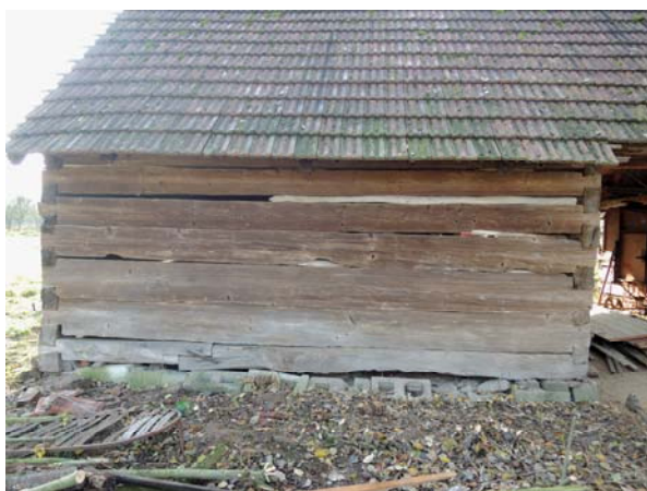
Obr. 10 Severní stěna východní části stodoly
