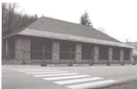
Rekonstrukce objektu vozovny z Ostravice, fotografie K. Matocha, fotoarchiv Valašského muzea v přírodě
