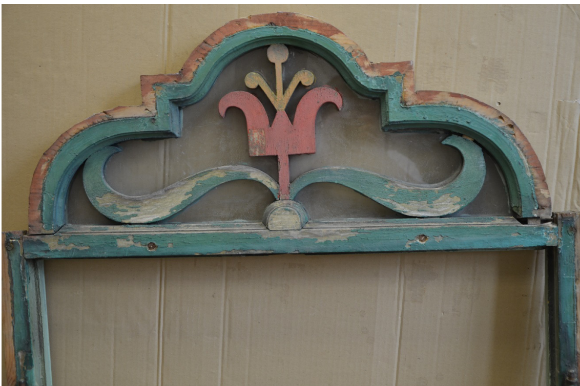
Obr. 6 Průzkum venkovní části objektu – celkový pohled na okno
