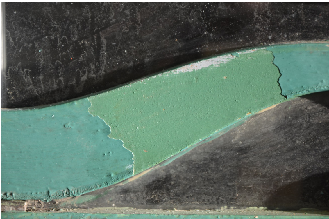
Obr. 9 Průzkum vnitřní části objektu – profil okna ve světlezeleném odstínu s šedou podmalbou
