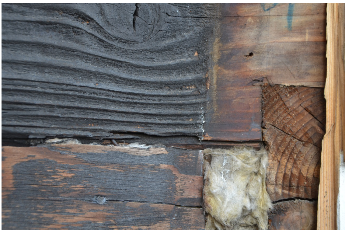
Obr. 12 Průzkum venkovní části objektu – detail červené lazury nacházející se na plášti budovy
