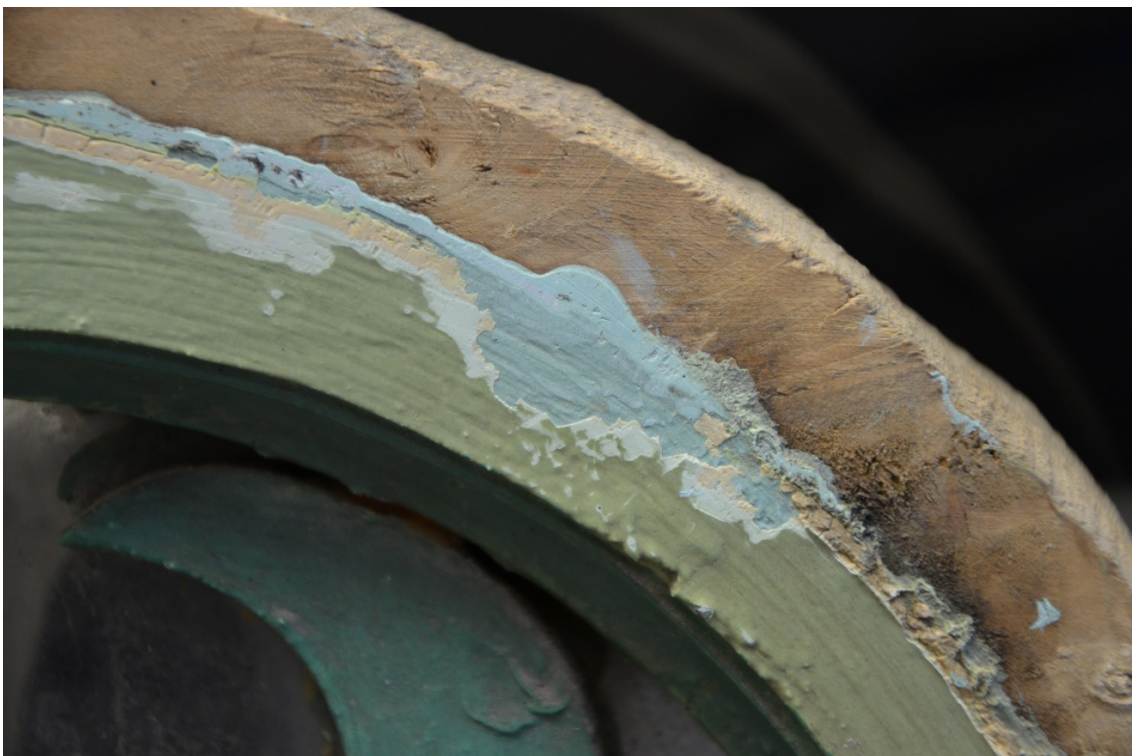
Obr. 5 Průzkum vnitřní části objektu – detail čištění barevných vrstev
