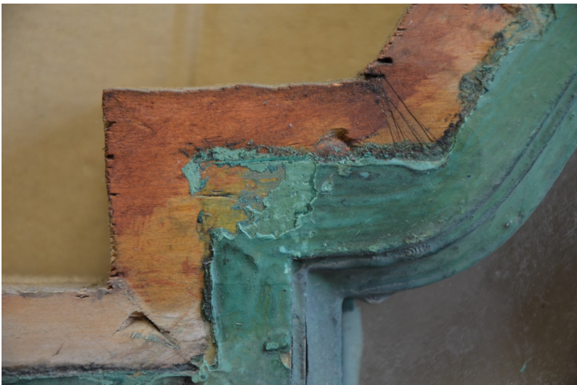
Obr. 7 Průzkum venkovní části objektu – detail okenního křídla s červenou lazurou, nátěr se nacházel v exteriéru na konstrukci nosných trámů a opláštění budovy
