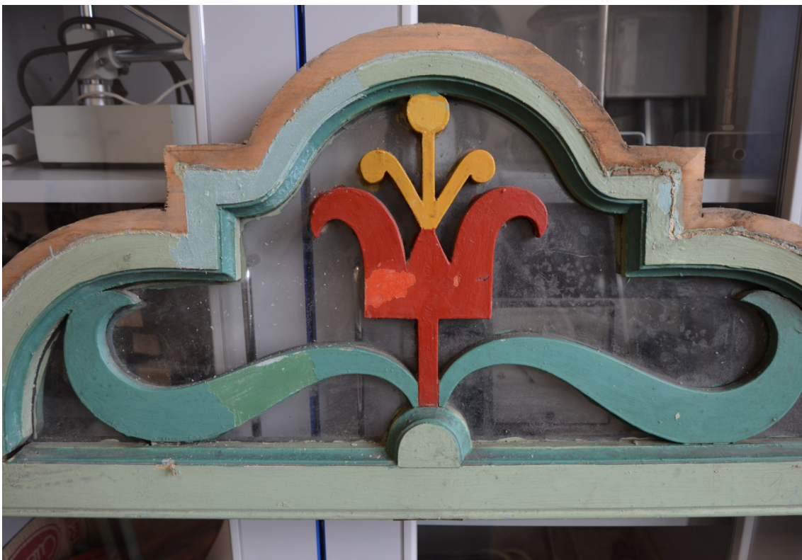
Obr. 4 Průzkum vnitřní části objektu – průběh čištění barevných vrstev
