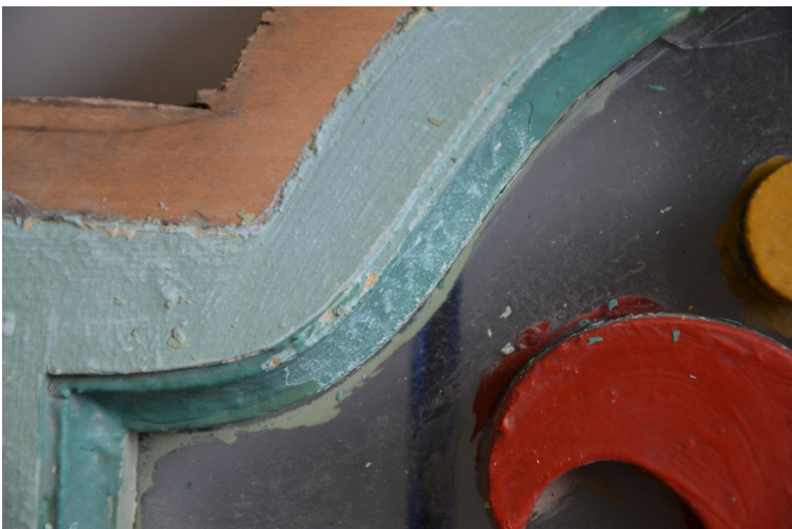
Obr. 8 Průzkum vnitřní části objektu – profil okna v modrozeleném odstínu s modrou podmalbou
