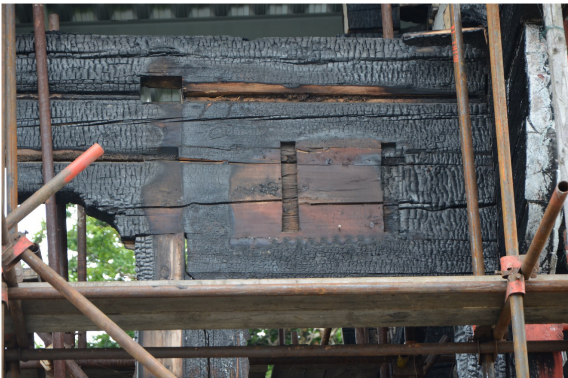
Obr. 10 Průzkum venkovní části objektu – pohled na červenou lazuru nacházející se na plášti budovy
