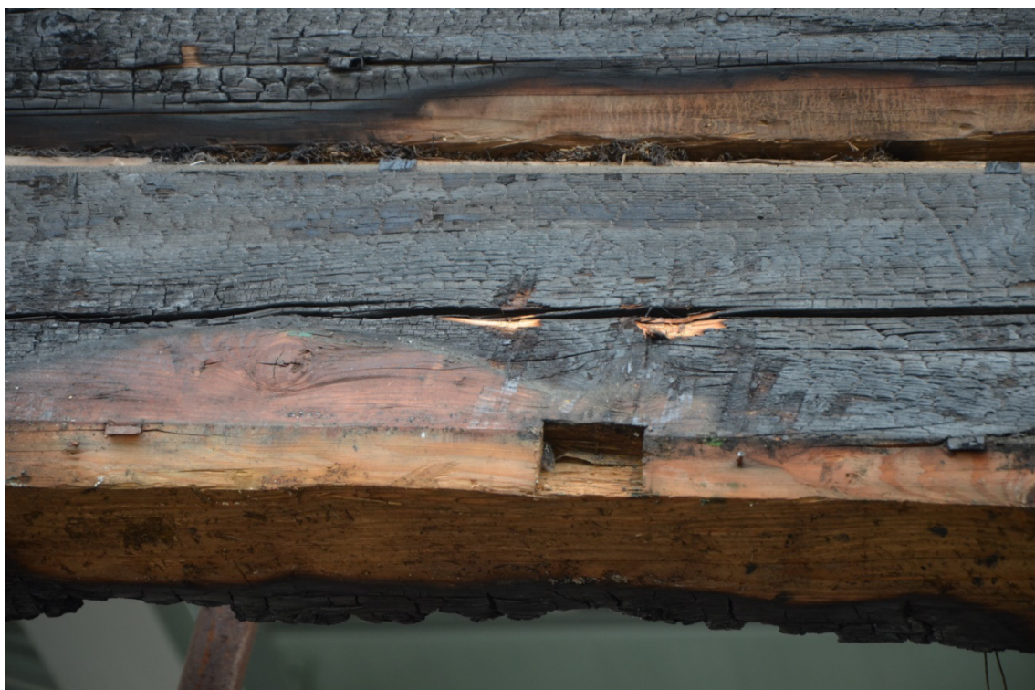
Obr. 11 Průzkum venkovní části objektu – detail červené lazury nacházející se na plášti budovy po odstranění okenního rámu
