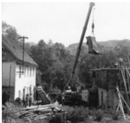
Mlýn čp. 27, rozebírání půdního roubeného tělesa komína a stropních trámů, květen 1986 (foto F. Ledvinka)
