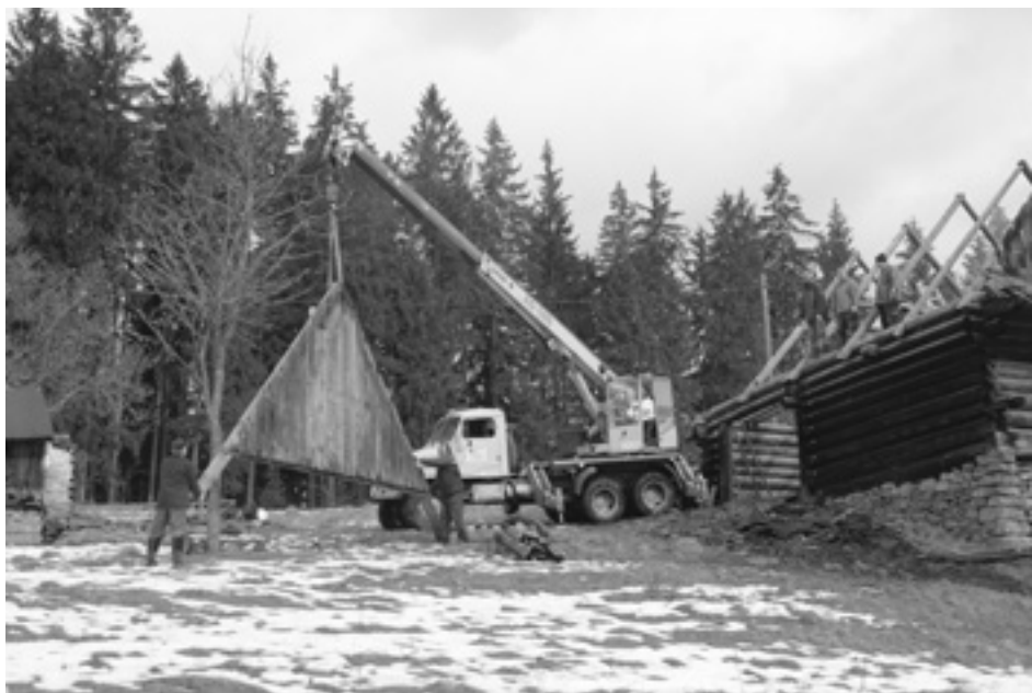
Při rozebírání staveb dbají pracovníci muzea na převezení co nejvíce konstrukcí, některých také vcelku podle možností techniky a následně přepravy. Stodola na Starých Hamrech – Porubáném, 2018 (foto R. Bryol)
