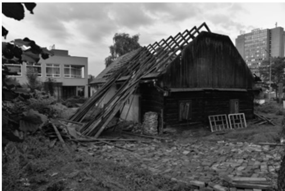
Pohled na dům čp. 124 v Kopřivnici od jihozápadu v době demontáže střešní konstrukce (foto P. Dvořák, 2018)
