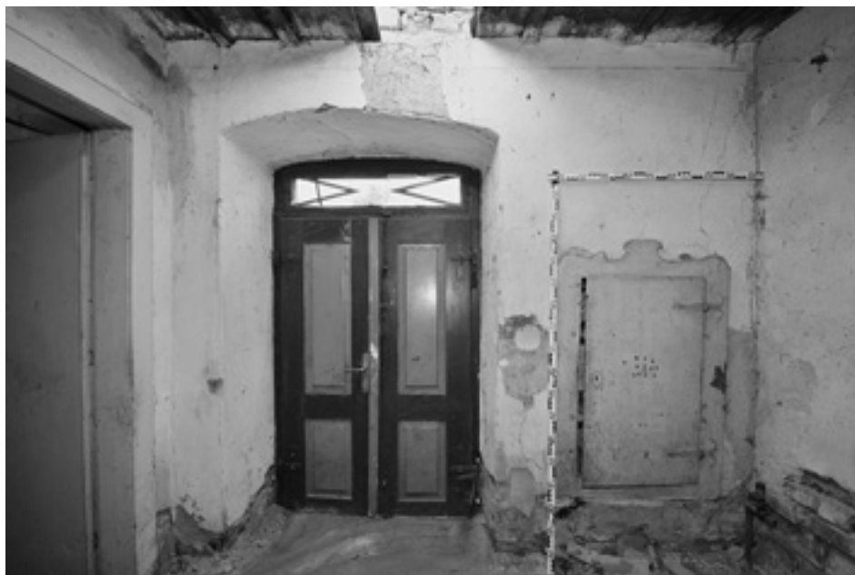
Pohled na východní stěnu předsíně 001 s hlavním vstupem do domu čp. 124 v Kopřivnici (foto J. Koudelová, 2018)
