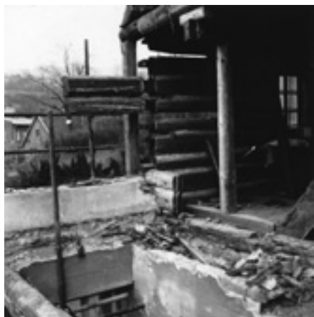
Detail oprav roubeného patra čp. 61 (foto F. Ledvinka, 1986)
