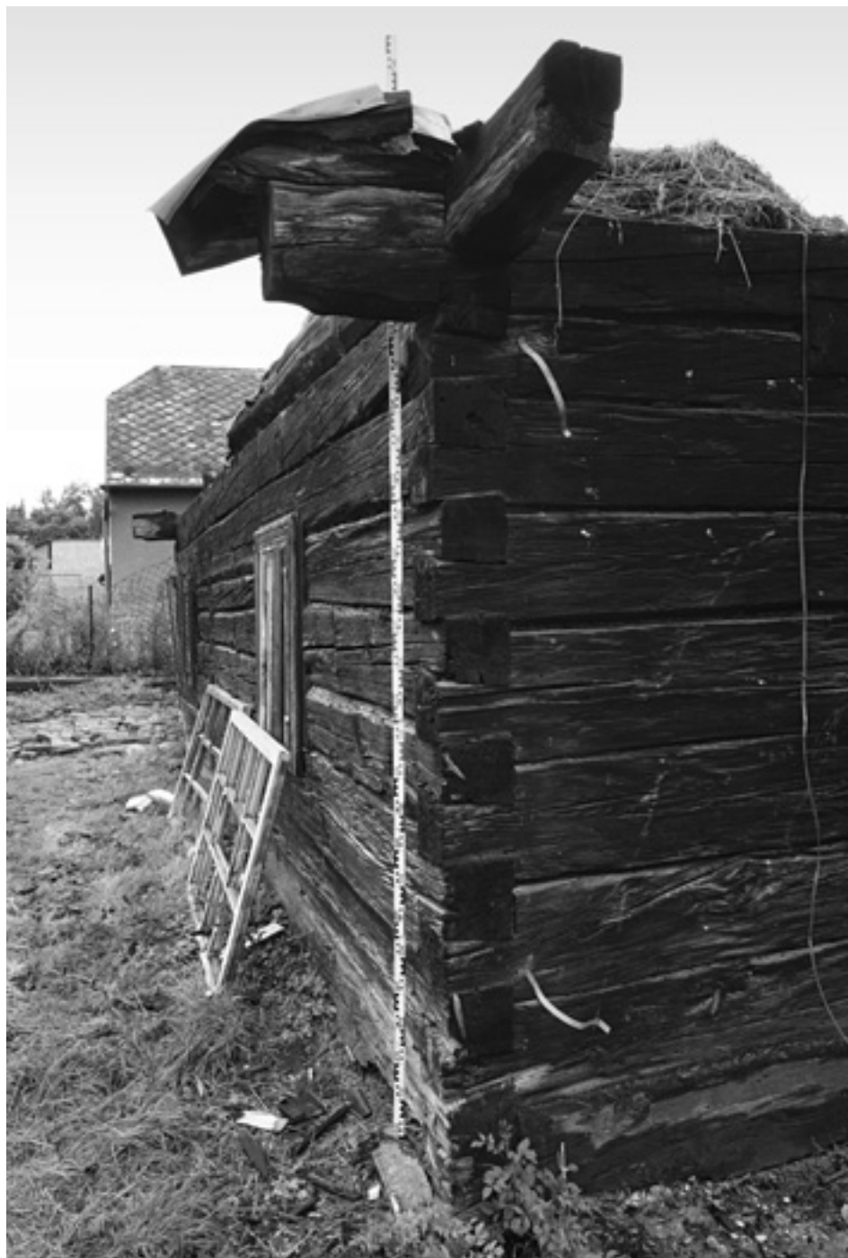
Detail nároží roubené konstrukce přední světnice domu čp. 124 v Kopřivnici (foto J. Koudelová, 2018)
