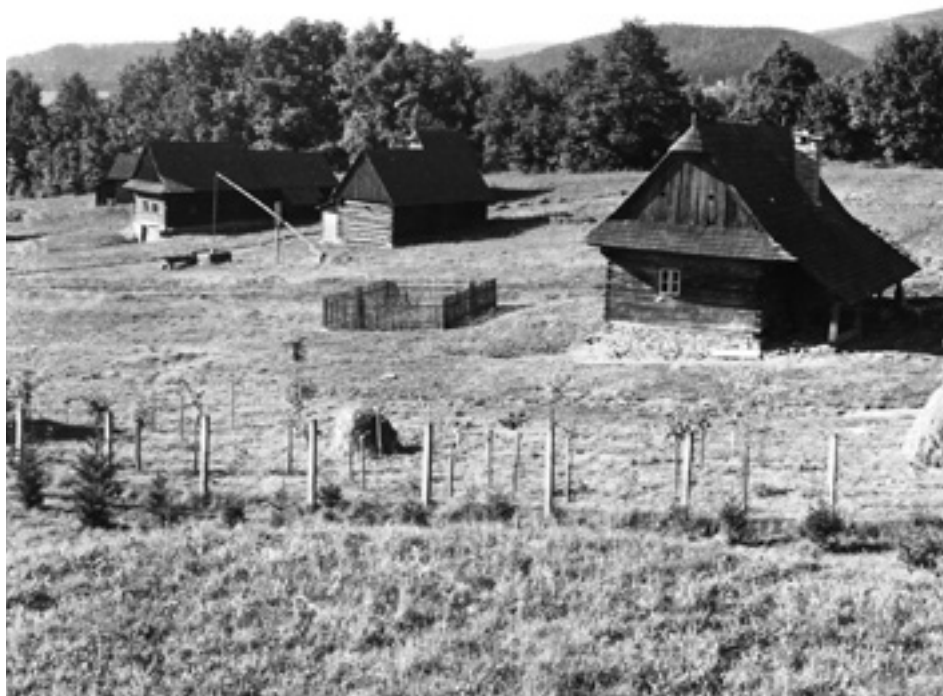
Budování jádra areálu Valašská dědina, 1969 (foto B. Přikryl, fotoarchiv NMvP – VMP)
