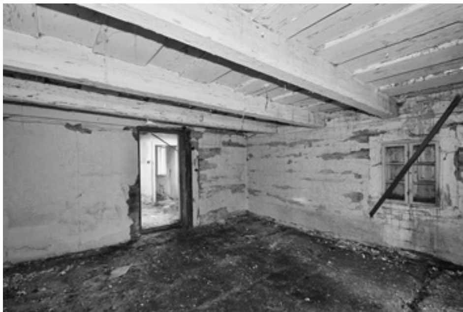
Pohled do roubené světnice 004 domu čp. 124 v Kopřivnici od jihozápadu (foto J. Koudelová, 2018)
