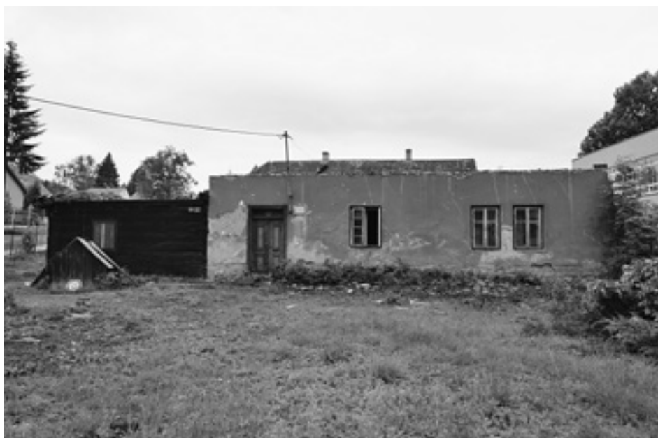
Pohled na východní okapové průčelí domu čp. 124 v Kopřivnici v době probíhající demolice (foto J. Koudelová, 2018)
