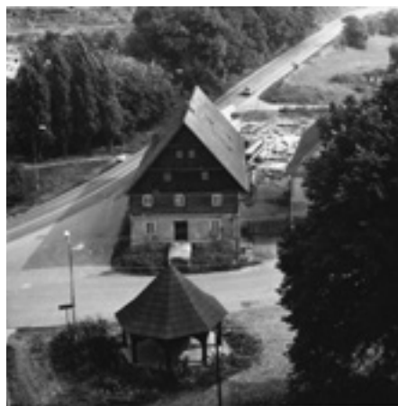
Náves a areál usedlosti čp. 61 před stavbou transferů stodoly, špýcharu a kůlny na vozy (foto F. Ledvinka, první pol. 80. let 20. století)
