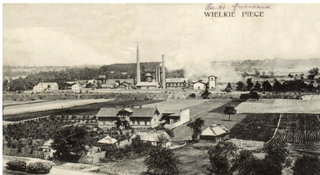
Ryc. 1. Widok od południa na Zakład Wielkopiecowy w Starachowicach (ok. 1901) Fot. ze zbiorów Muzeum Przyrody i Techniki w Starachowicach
