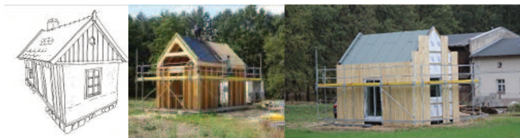
Ryc. 16. Pierwszy etap – Warsztaty pt. realizacja obiektu ekspozycyjnego z materiałów naturalnych. Koło Naukowe Studentów Architektury przy Wydziale Architektury Politechniki Poznańskiej
