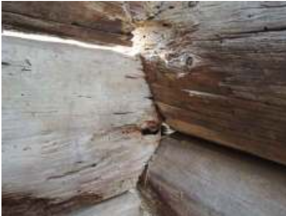
Obr. 3.10 Poškozený trám č. 2 v místě západního zhlaví
