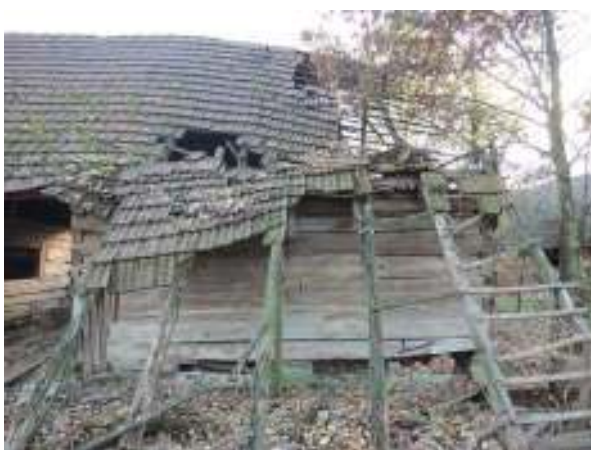
Obr. 1.8 Severní stěna západní části stodoly
