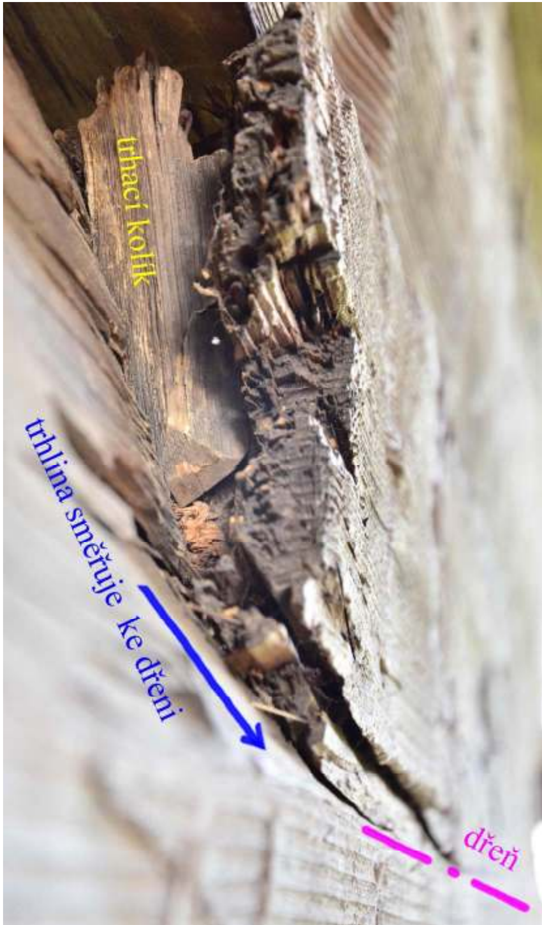
Obr. 2.24 Zbytek kolíku sloužícího patrně k regulaci směru štěpu při draní
