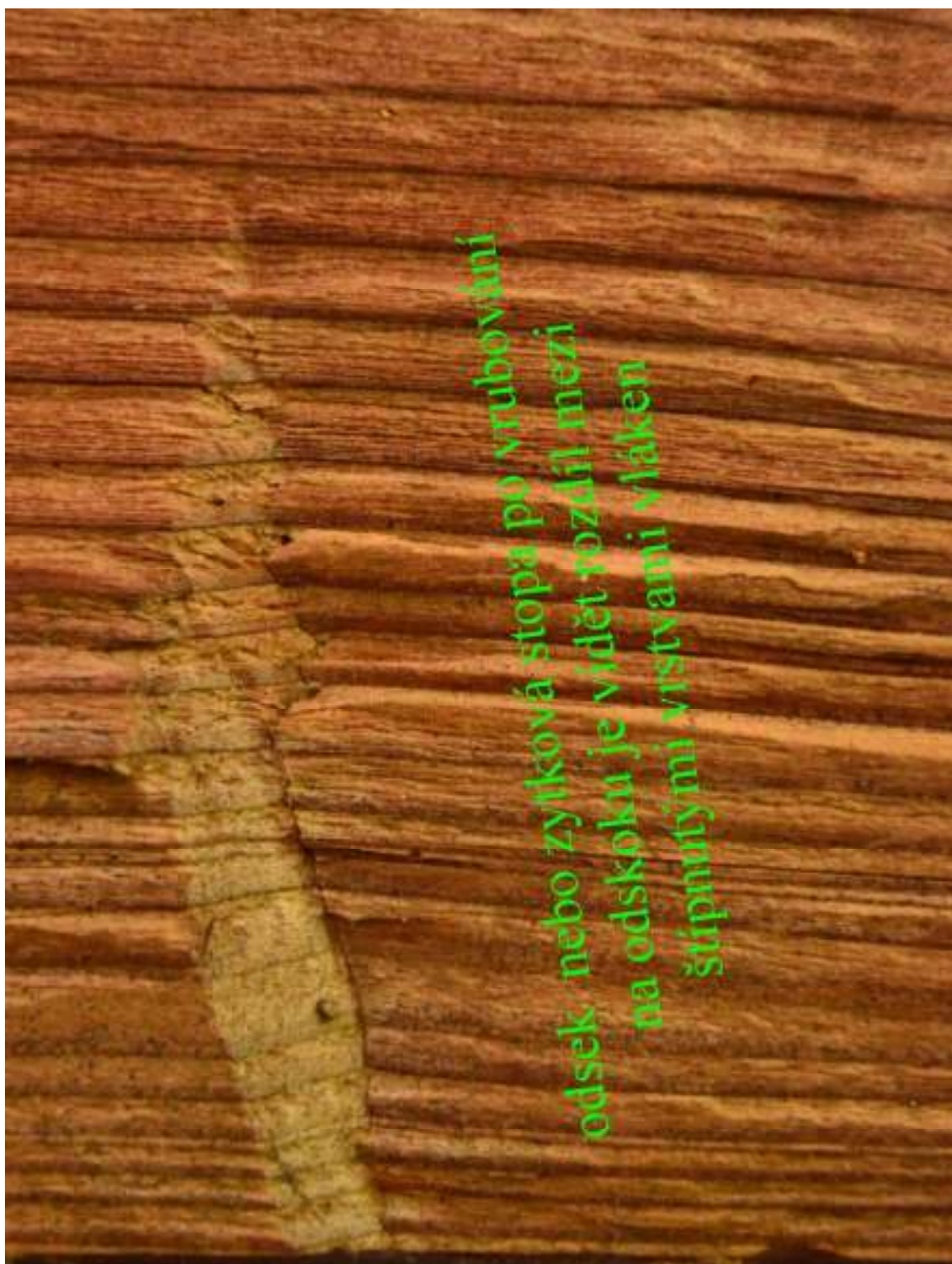
Obr. 2.12 Odseky odštípnutých hranových vláken provedené už pravděpodobně šířčinou, jedním úderem
