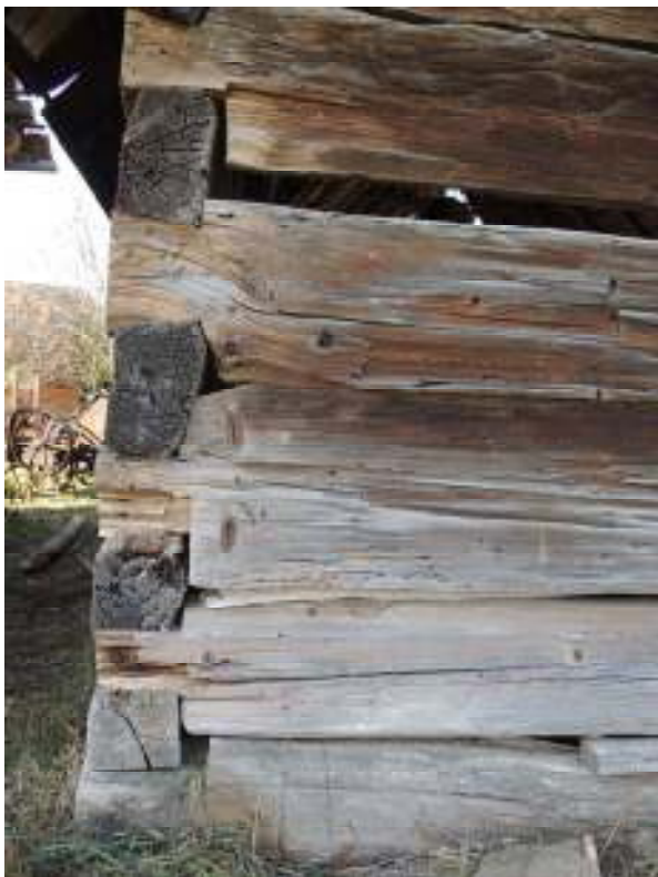
Obr. 3.20 Poškozený trám č.2 v místě jižního zhlaví
