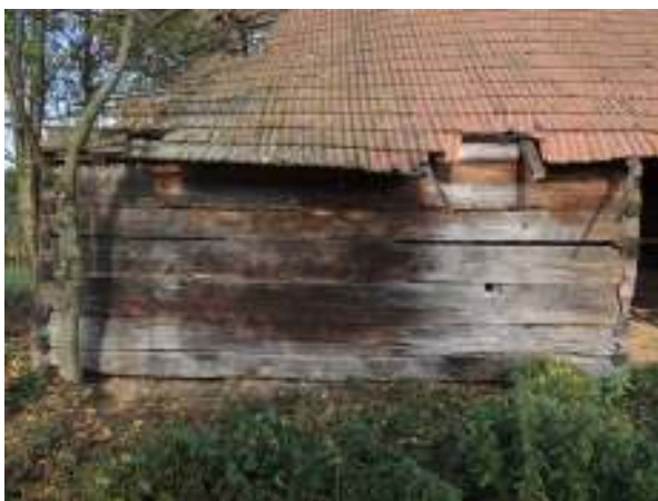
Obr. 1.6 Jižní stěna západní části stodoly
