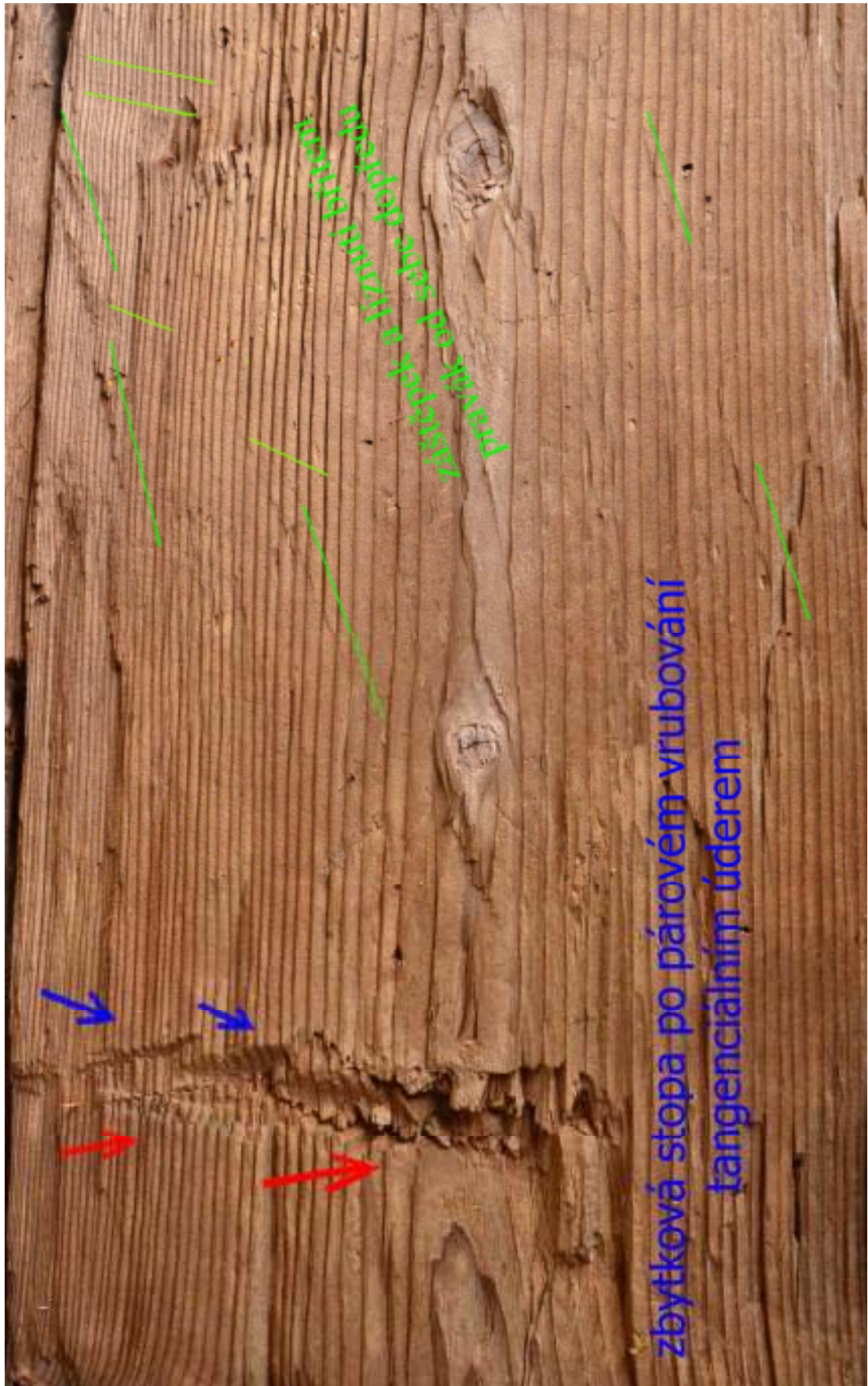
Obr. 2.10 Odstraňovaná vrstva s odtrženými vlákny byla natolik omezující, že ji tesař nemohl krátit
