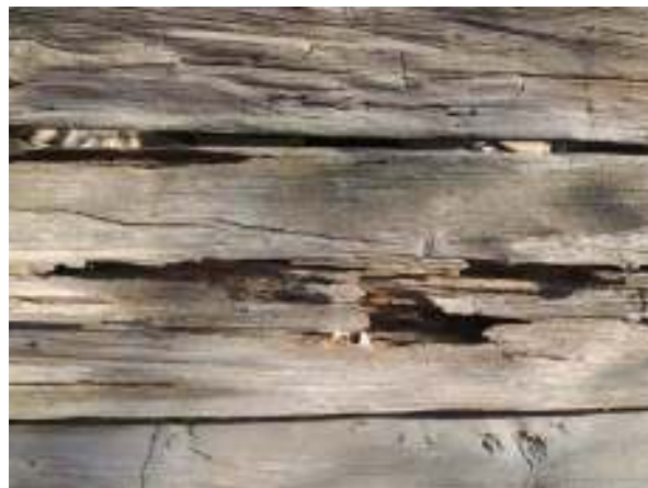
Obr. 3.15 Poškozený trám č.3 v místě severního zhlaví
