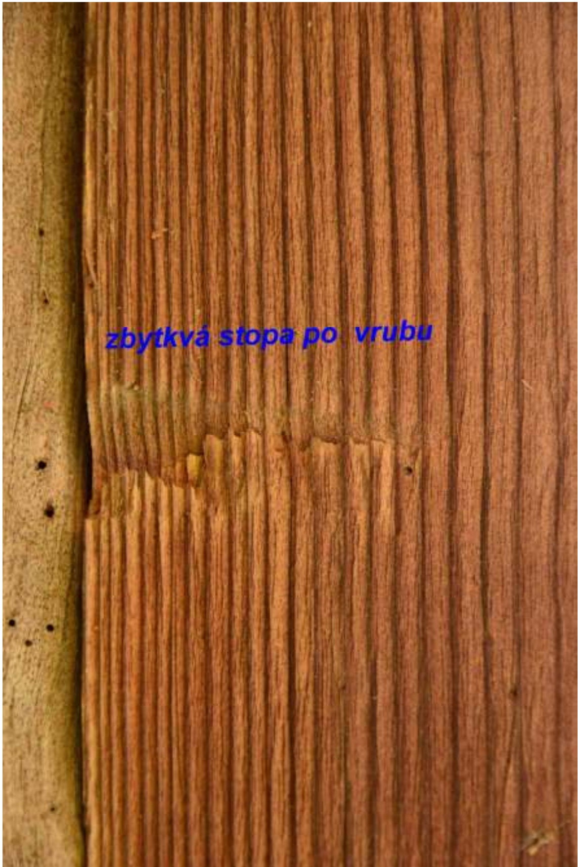
Obr. 2.13 Odseky odštípnutých hranových vláken provedené už pravděpodobně šířčinou, jedním úderem
