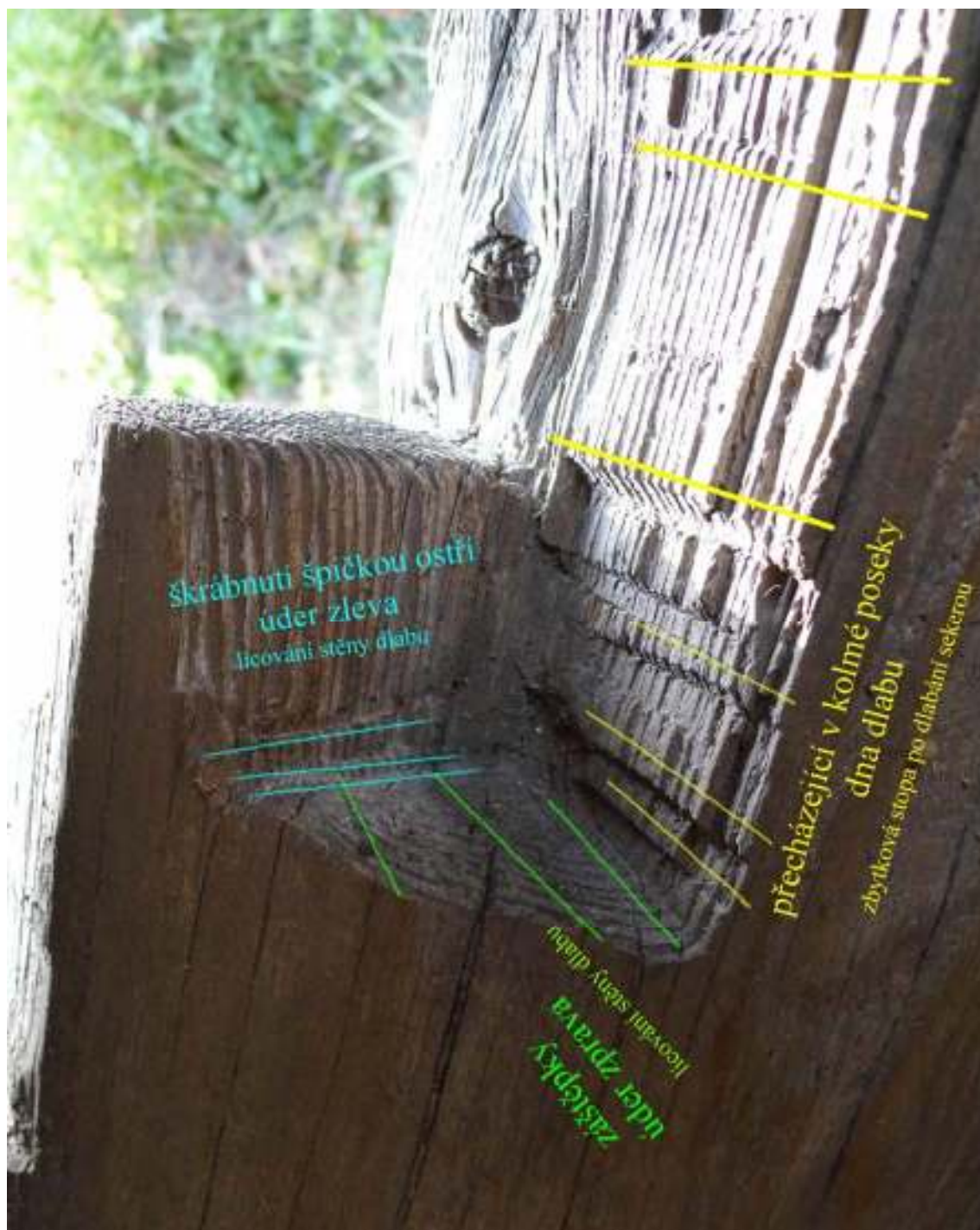
Obr. 2.27 Přístupný spoj vyrobený podle zřetelně dochovaných stop pouze sekerou
