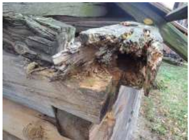
Obr. 3.13 Poškozený trám č.8 v místě západního zhlaví
