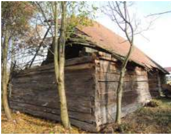
Obr. 1.4 Jihozápadní pohled na stodolu
