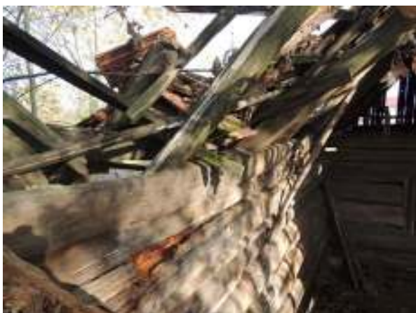
Obr. 3.18 Poškozený trám č.7 v místě západního zhlaví
