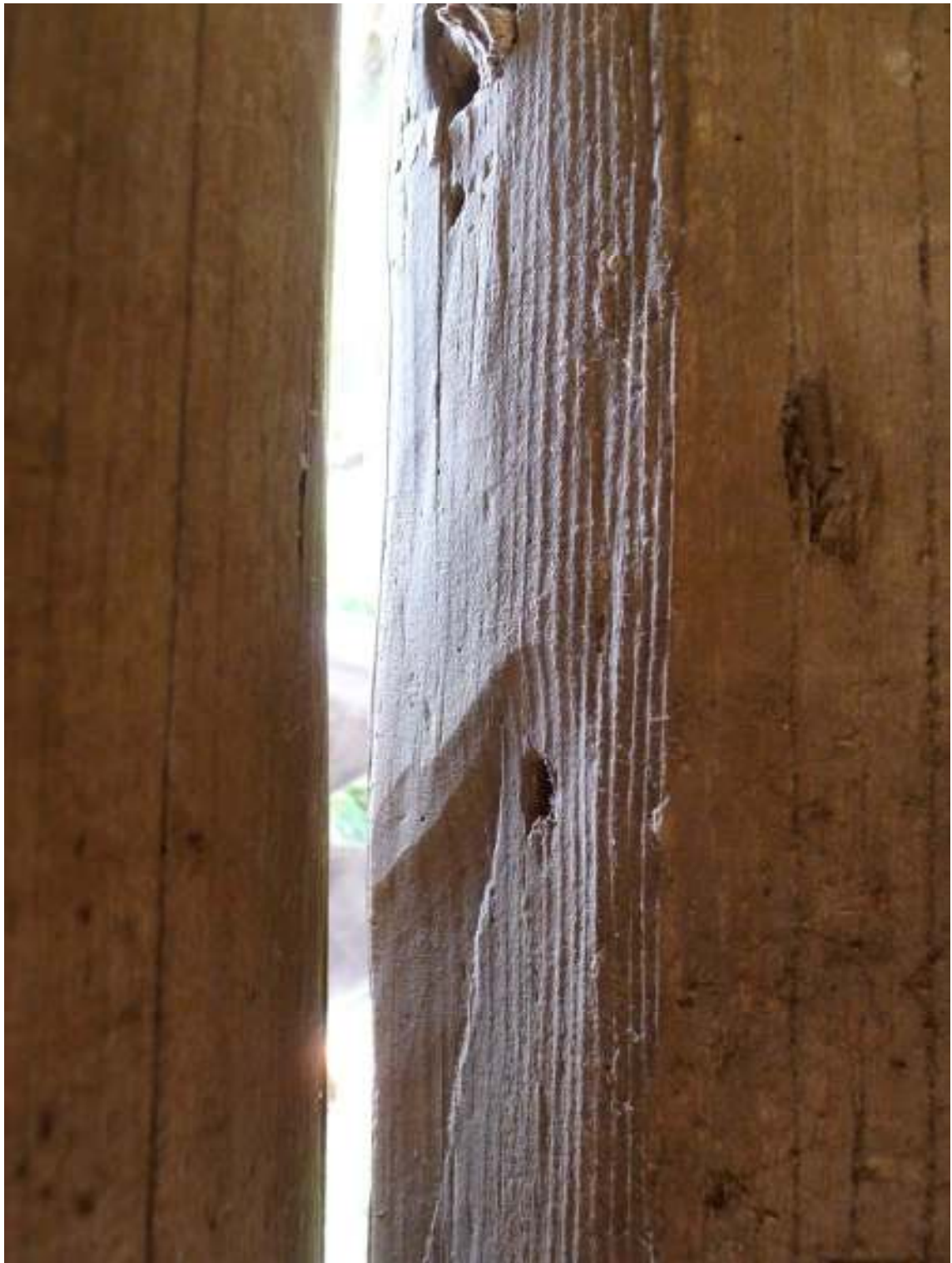
Obr. 2.15 Špatně identifikovatelné stopy po lícování
