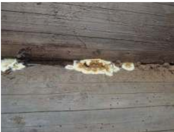
Obr. 3.12 Poškozený trám č.6 v místě západního zhlaví
