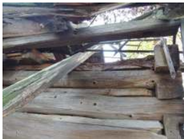
Obr. 3.19 Poškozený trám č.8 v místě západního zhlaví
