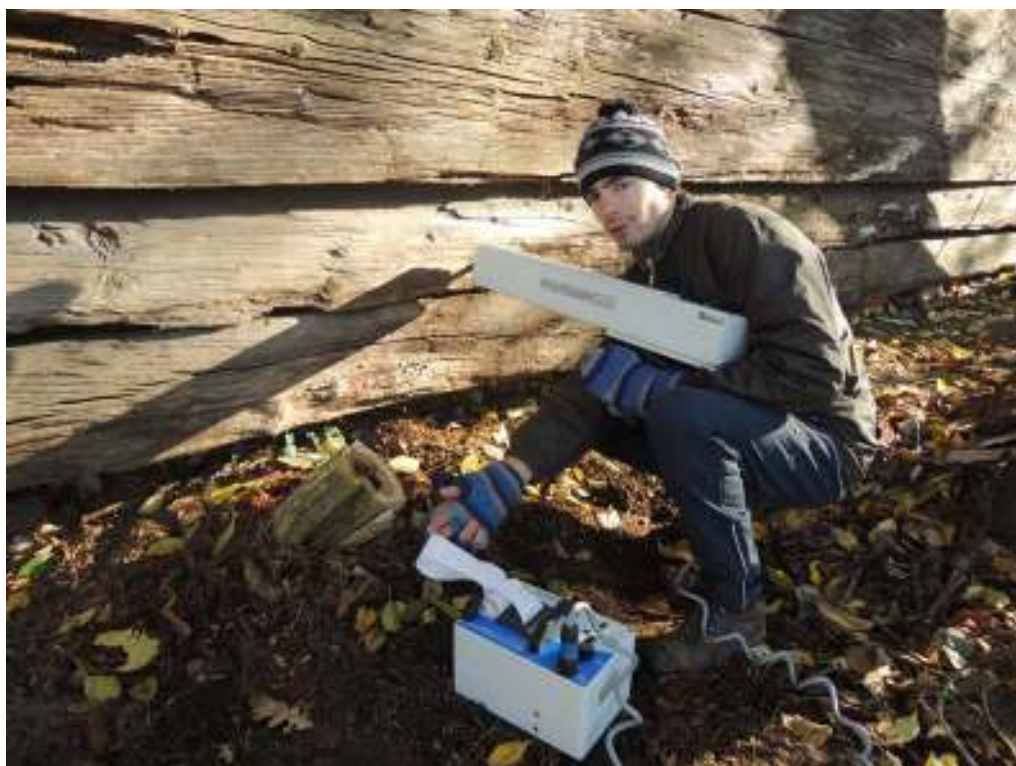
Obr. 3.1 Měření na místě pomocí odporové mikrovrtáčky Resistograph
