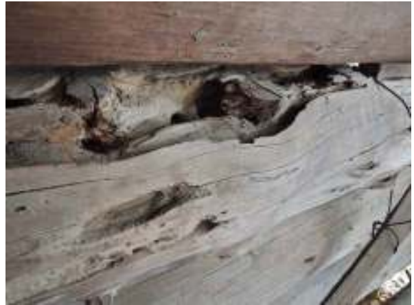
Obr. 3.11 Poškozený trám č.5 v místě západního zhlaví
