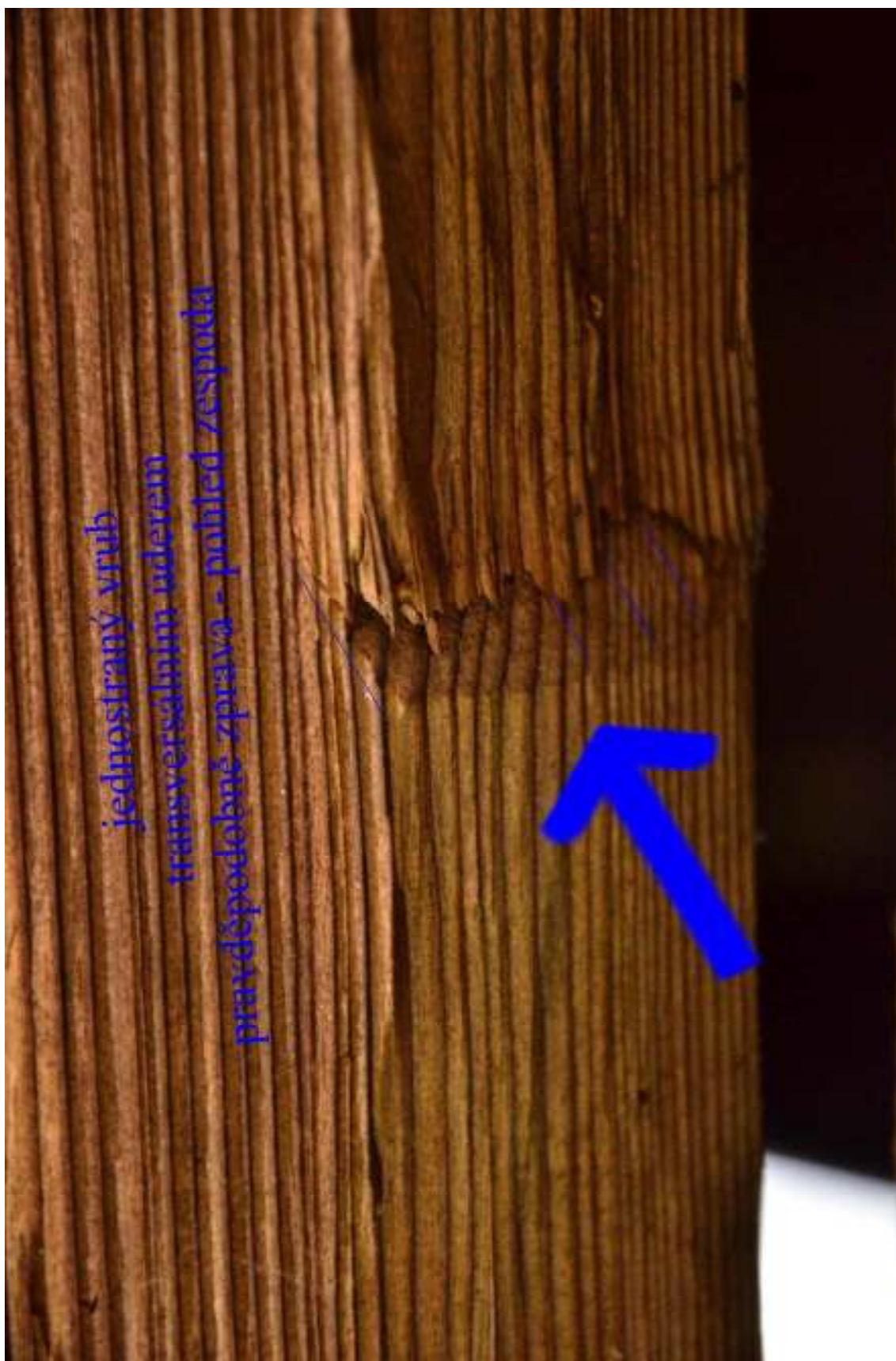
Obr. 2.21 Stopa po vrubování jedním tesařem – jednostranný vrub vytvořený dvěma záseky
