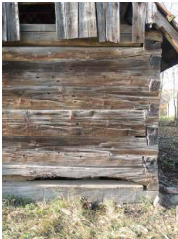
Obr. 3.21 Poškozený trám č.2 v místě severního zhlaví
