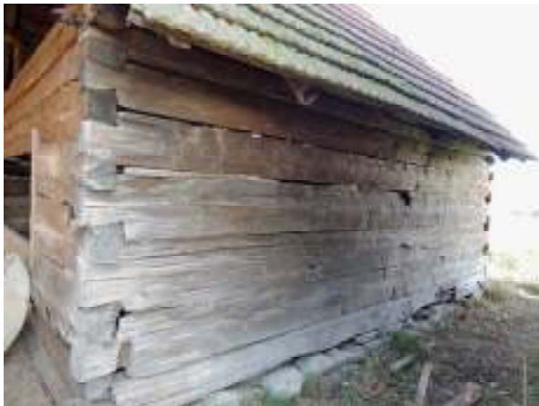
Obr. 1.10 Jižní stěna východní části stodoly
