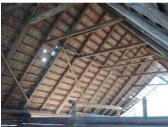
Obr. 1.14 Celkový pohled do krovu od severovýchodu
