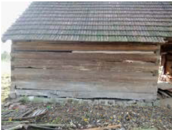
Obr. 1.12 Severní stěna východní části stodoly
