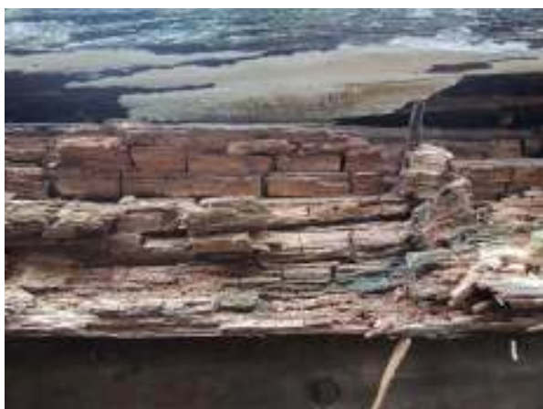
Obr. 3.16 Poškozený trám č.7 v místě severního zhlaví
