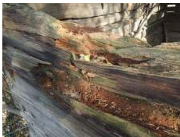
Obr. 3.17 Poškozený trám č.8 v místě severního zhlaví
