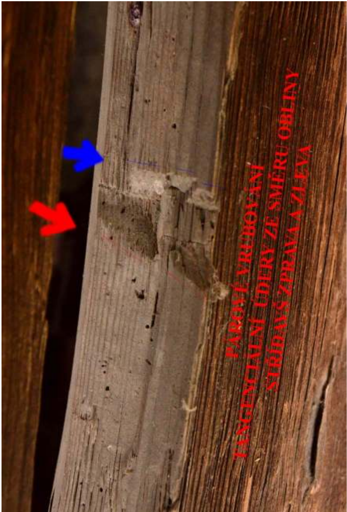
Obr. 2.16 Stopy po vrubování dvěma tesaři – úderý jsou vedené střídavě proti sobě (párové vrubování)
