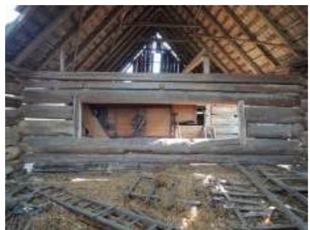
Obr. 1.9 Východní stěna západní části stodoly
