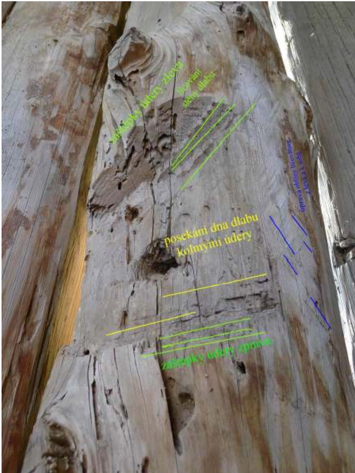
Obr. 2.29 Přístupný spoj vyrobený pouze sekerou
