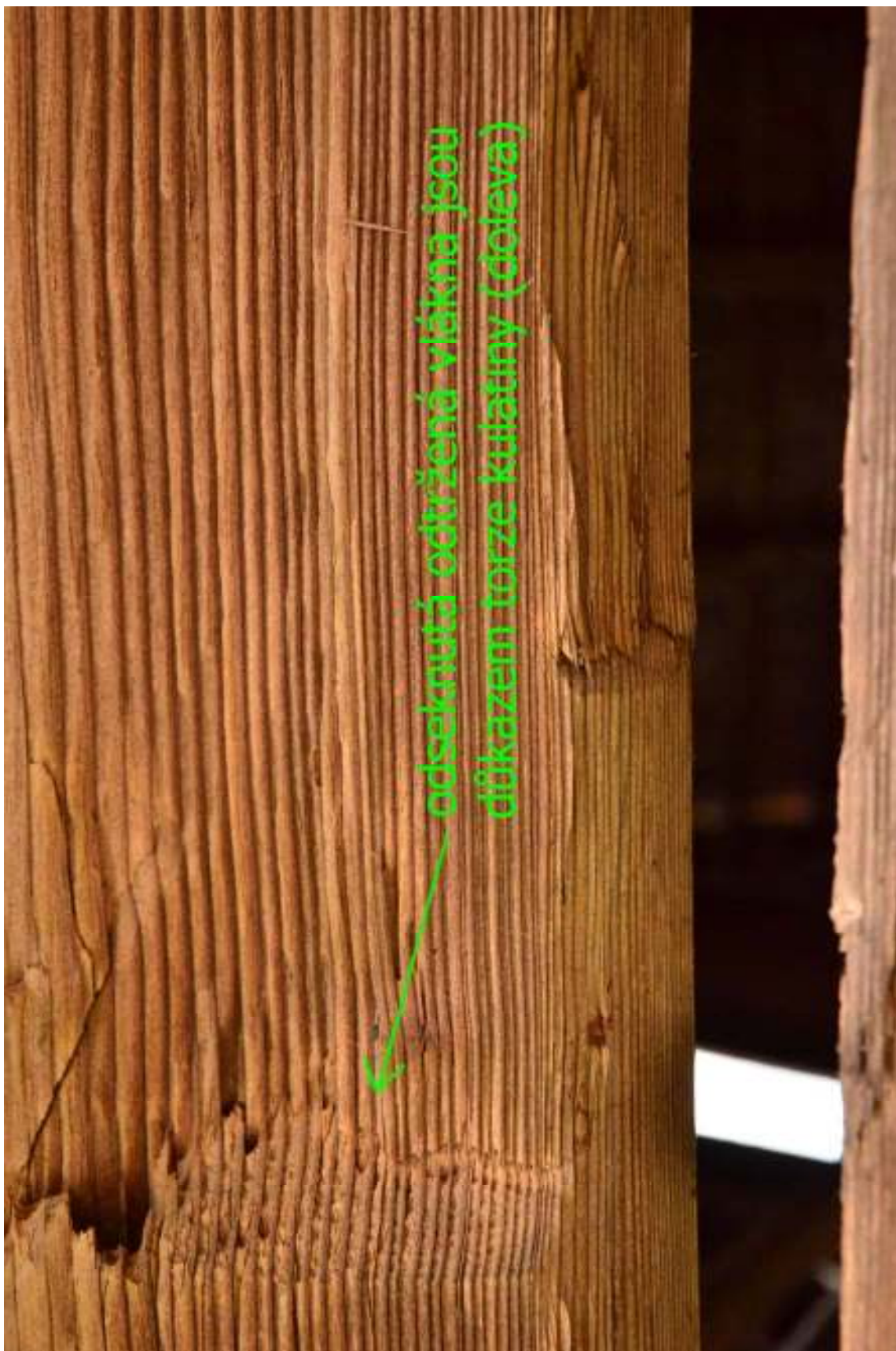
Obr. 2.2 Detail úpravy líce v místě odtržení vláken, které vzniká při draní stočného dřeva
