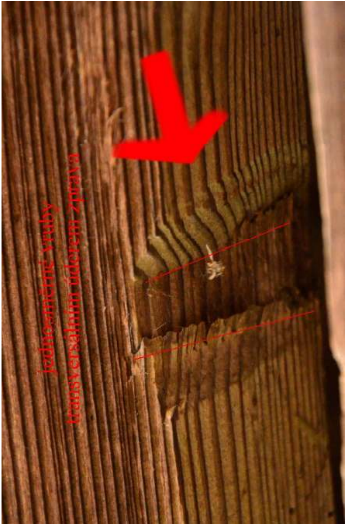
Obr. 2.19 Stopy po vrubování jedním tesařem – údery jsou vedené z boku šikmo do líce
