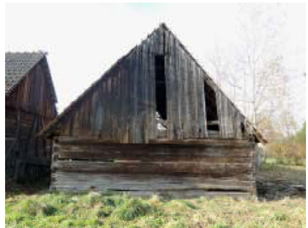
Obr. 1.13 Východní stěna východní části stodoly
