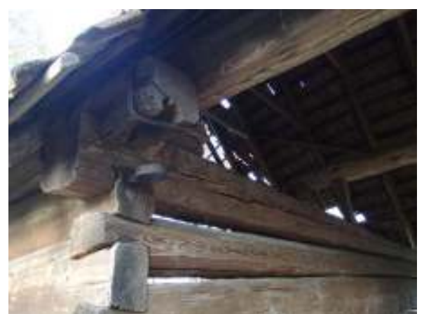
Obr. 1.15 Detail točnice vrat na jižní straně stodoly
