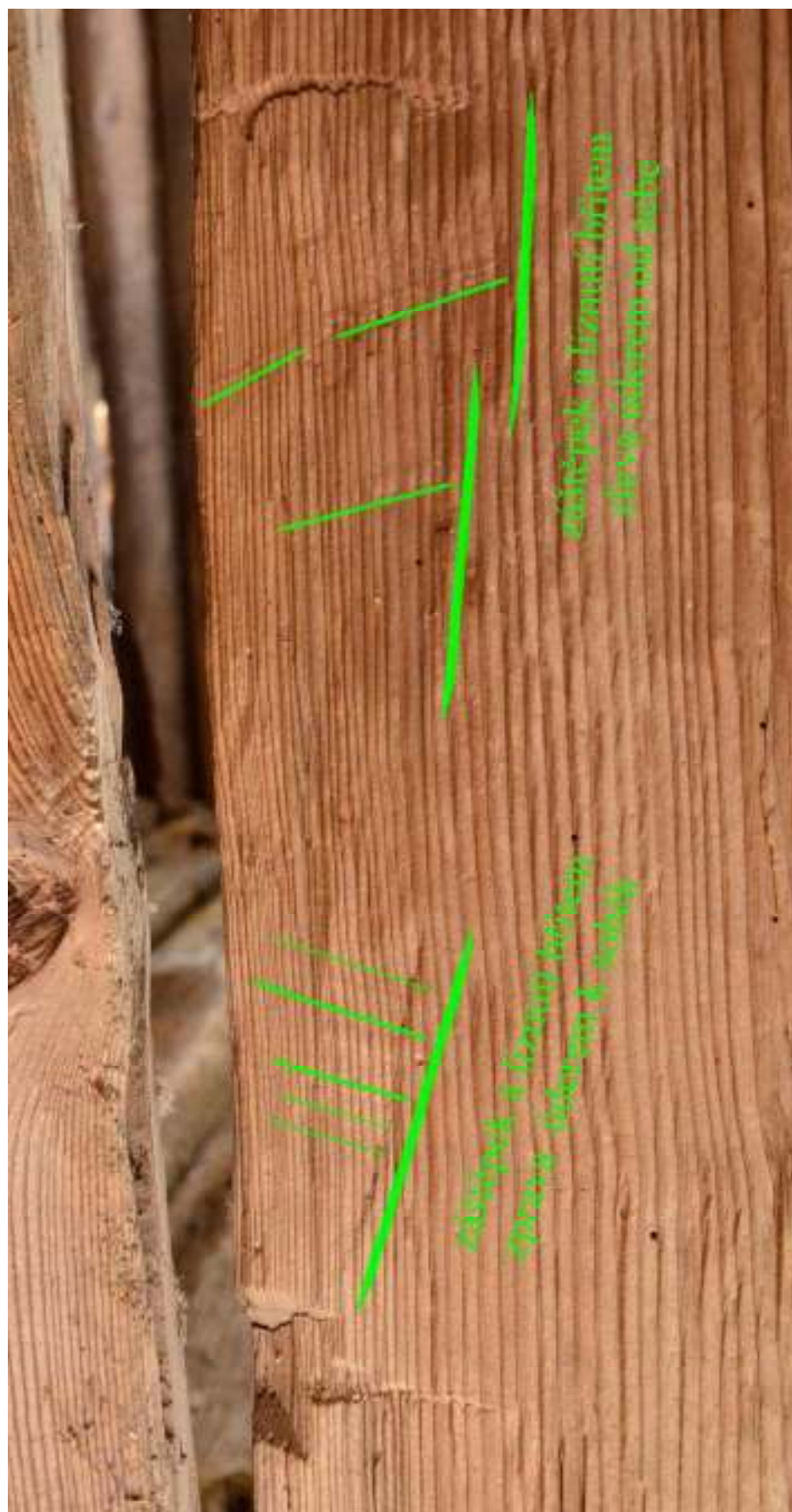
Obr. 2.14 Při hodnocení jednotlivých stop je třeba brát ohled na tloušťku odsekávané líc i míru stáčivosti (trhliny na lici, zatržení a odseky na hraně, výsušné trhliny na oblině)
