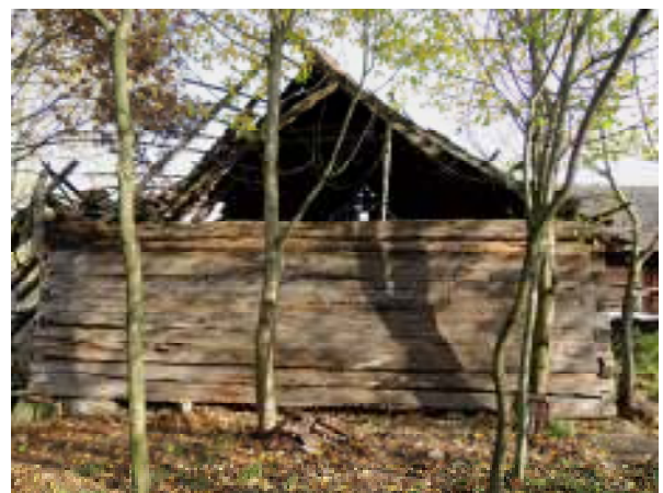
Obr. 1.7 Západní stěna západní části stodoly
