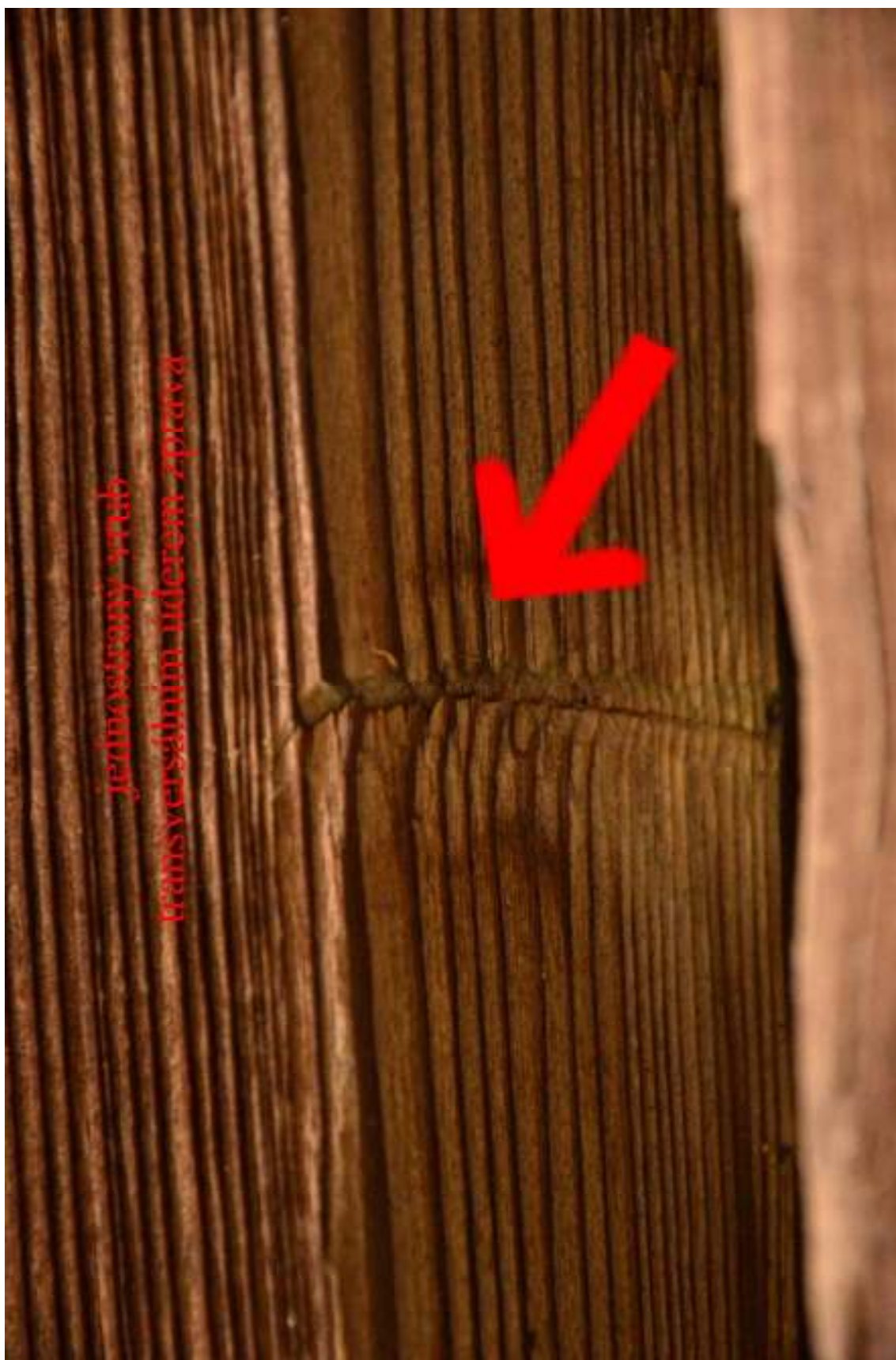
Obr. 2.20 Stopa po vrubování jedním tesařem – jednotlivý úder vedený z boku šikmo do líce
