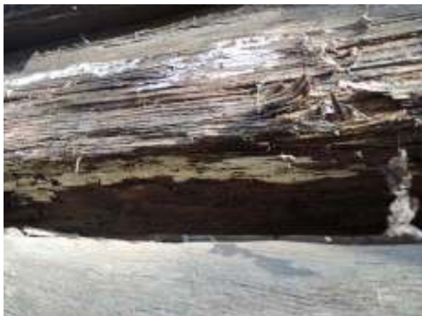
Obr. 3.14 Poškozený trám č.2 v místě severního zhlaví
