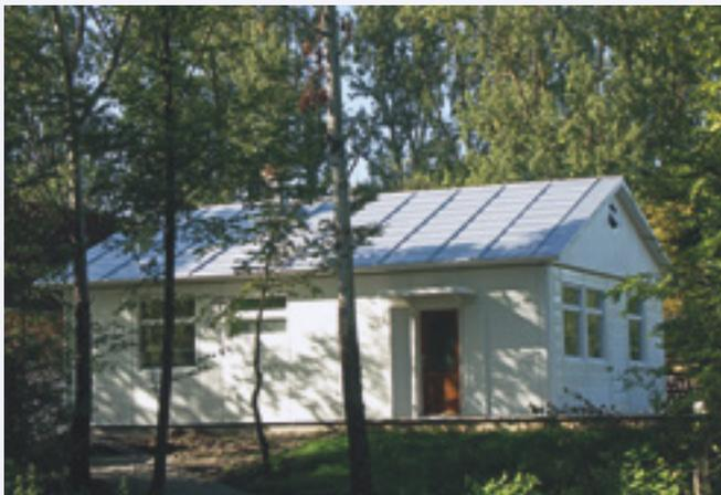
Auch das ist ländliches Bauen: hier eines der ersten Fertighäuser aus Stahl, die von den MAN-Werken nach 1946 entwickelt wurden. Es stand im mittelfränkischen Landkreis Roth.
