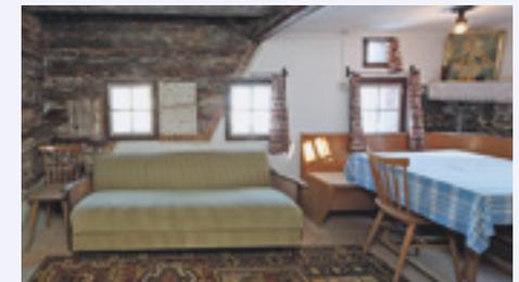
18 Hof „Steinbichl“, Stube mit zwei Zeitschichten, Blockbau 1621 mit Erweiterungen 1670 und 1868 mit unverputzten Blockwänden links, und Zeitschicht Ferienhaus 1970-1990 mit weiß verputzten und getünchten Wänden, Resopalanrichte und Einbau einer Dusche rechts.
