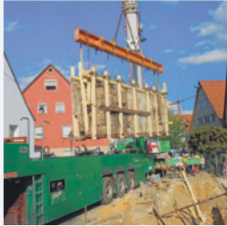
Abbau des spätmittelalterlichen Badhauses aus Wendelstein: Verladen eines gemauerten Wandteils auf einen Tieflader im August 2012. (Foto: Fränkisches Freilandmuseum)
