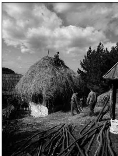
Покривање објекта у домаћинству ражаном сламом Re-covering of cottage (vajat) by rye hay.
