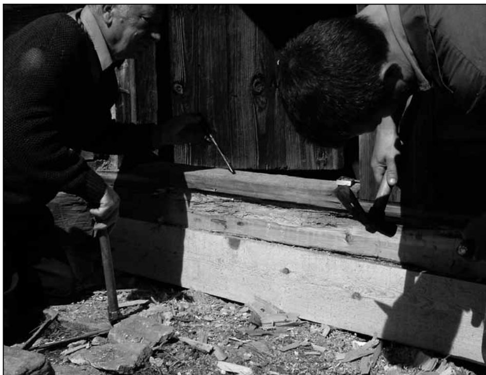
Замена поодвалне греде на објекту музејска кућа домаћинсџва The reconstruction of the lower door log in the Museum`s household main house
