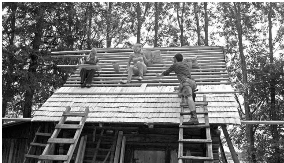
Рагионица: изграња дрвеної крова. Фойо: Е. Луйсейй, 2008. Workshop of building of wooden roof. Photo: E. Lutsepp, 2008.
