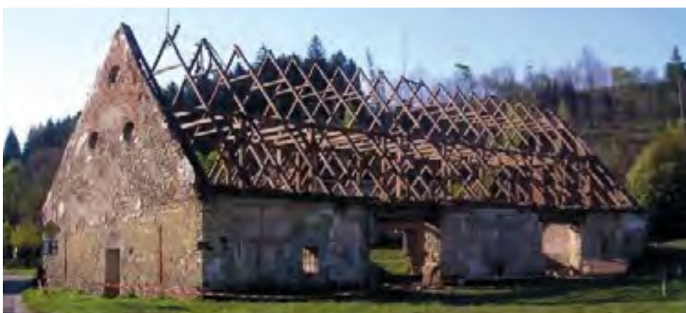
5. Bělá nad Svitavou, zámecká stodola během demolicí areálu zámku a pivovaru, hospodářské budovy byly nahrazeny podřadnou bytovou zástavbou, foto J. Lenočh, 2006. Bělá nad Svitavou, manor house barn during the demolition of the manor house and brewery complex, farm buildings were replaced by inferior housing development. Bělá nad Svitavou (Deutsch Bielau), Schlossscheune während des Abrisses vom Schloss- und Bierbrauereiareal, die Wirtschaftsgebäude wurden durch minderwertige Wohnhäuser ersetzt.
