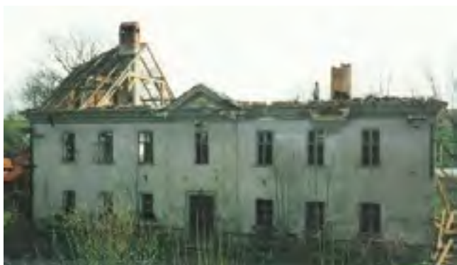
12. Rychta v Opatově, objekt bez využití zbořen roku 1990, autor neznámý, 1990, archiv obce Opatov. Reeve's office in Opatov, unused building demolished in 1990. Vogtei in Opatov, das Objekt ohne Nutzen niedergerissen im Jahre 1990.
