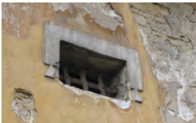
20. Mravín čp. 18, detail štukové výzdoby fasády sýpky, šambrána okenního otvoru v patře dochované na dvorní štítové straně ze závěru 19. století, 2011, foto Z. Vařeková. Mravín No. 18, detail of the stucco decoration of the granary facade; the chambranle of the upstairs window on the court gable wall is preserved from the late 19 th century. Mravín Hs.-Nr. 18, Detail des Stuckschmucks von der Speicherfassade, die Fensterumrahmung im ersten Stock auf der Hofgiebelfront stammt aus dem Ende des 19. Jahrhunderts.
