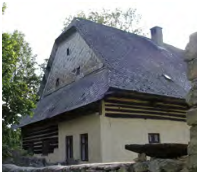
51. Helvíkov čp. 1, částečně roubená archaická usedlost ve středu obce, foto J. Lenočh, 2012. Helvíkov No. 1, partially timbered archaic farmstead in the centre of the municipality. Helvíkov (Klein Hermigsdorf) Hs.-Nr. 1, teilweise in Blockbauweise errichteter archaischer Bauernhof inmitten des Dorfes.
