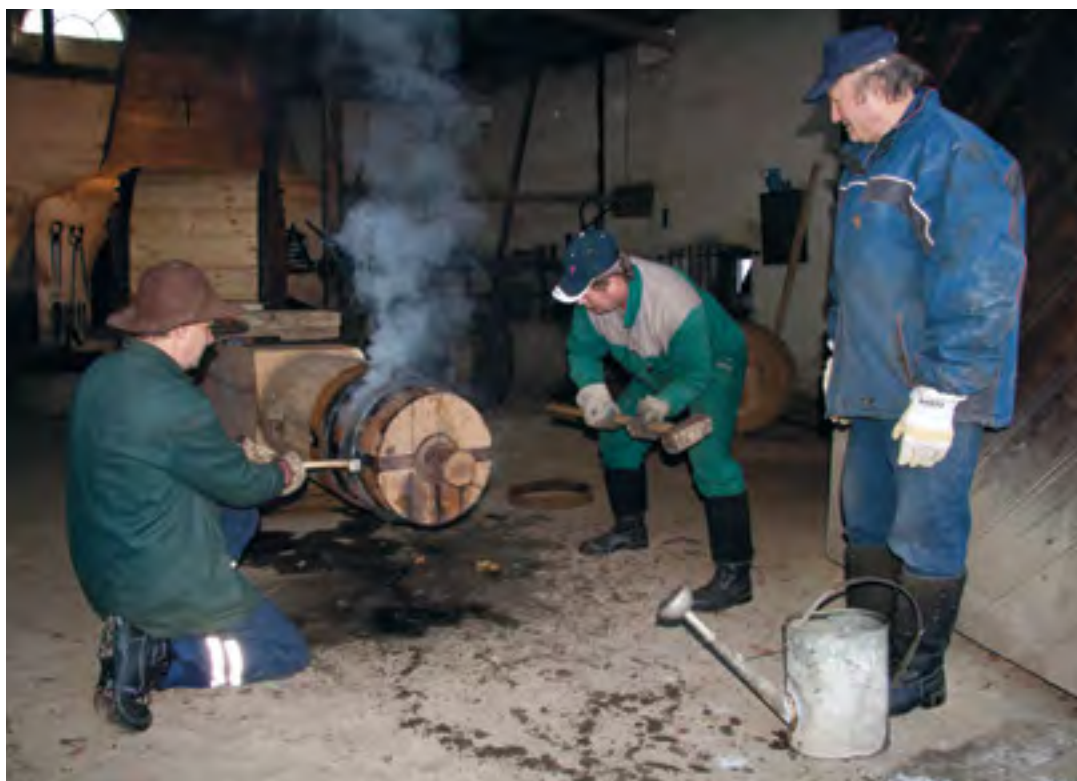
11. Péče o stavební památky ve Valašském muzeu obnáší celou řadu operací s využitím tradičních i moderních technologií, 2013, foto J. Kolář, Oddělení dokumentace VMP. The care for monuments in the Wallachian Open-Air Museum involves numerous operations using both traditional and modern technologies. Die Pflege der Bauwerke im Walachischen Museum umfasst zahlreiche Operationen, wo sowohl moderne als auch traditionelle Technologien angewandt werden.
