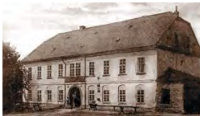
13. Rychta v Javorníku, po nárazu kamionu zbořena před rokem 1980, autor neznámý, před 1945. Reeve's office in Javorník, demolished after a truck crash before 1980. Vogtei in Javorník (Mohren), niedergerissen vor 1980 nach dem Aufprall eines LKWs.
