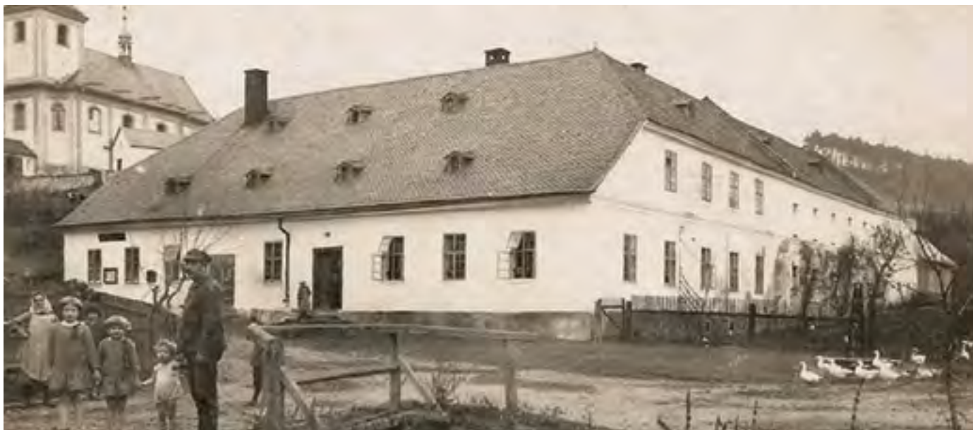
14. Rychta v Pohledech, zbořena před rokem 1970, autor neznámý, 1930. Reeve's office in Pohledy, demolished before 1970. Vogtei in Pohledy (Pohler), niedergerissen vor 1970.
