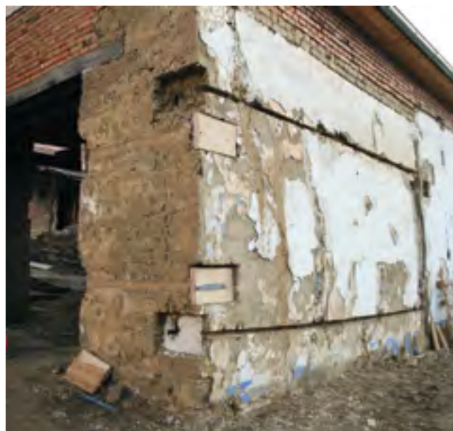
10. Detail instalace táhel při statickém zajištění obytného domu, 2011, foto V. Říhová. Detail of the installation of construction rods during the securing protection of the residential house. Detail der Anbringung von Zugstangen bei der statischen Sicherstellung des Wohnhauses.
