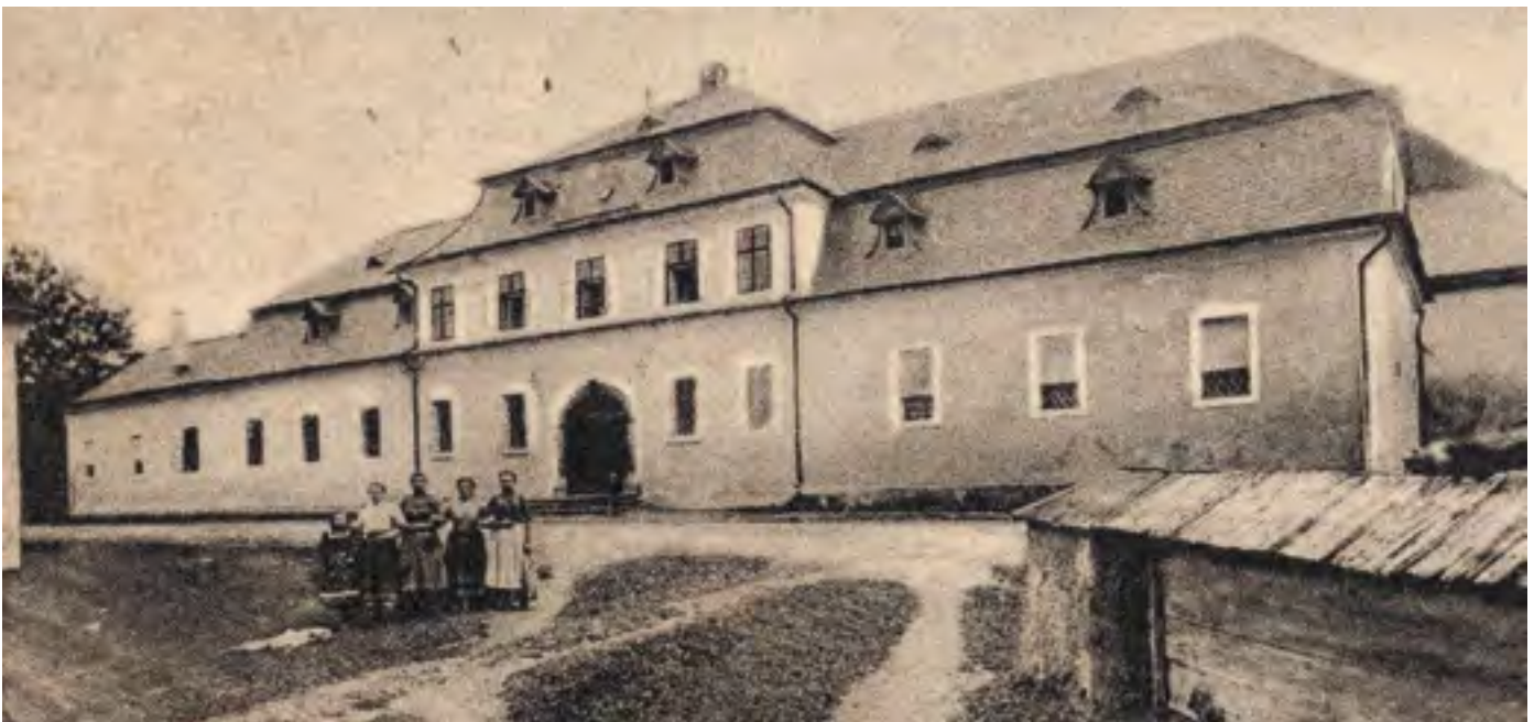
25. Rychta v Koclířově, zbořena v roce 1960, hospodářské budovy vyhořely již roku 1956, autor neznámý, před 1945, archiv J. Lenočha. Reeve's office in Koclířov, demolished in 1960, farm buildings destroyed by fire in 1956. Vogtei in Koclířov, niedergegrissen im Jahre 1960, die Wirtschaftsgebäude erlagen einer Feuersbrunst bereits im Jahre 1956.
