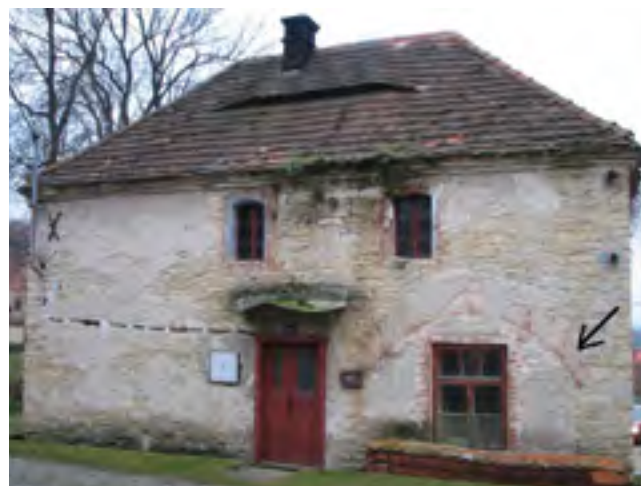
22. Mravín čp. 25, pohled na průčelí chalupnické usedlosti, 2011, foto Z. Vařeková. Mravín No. 25, view of the facade of a cottager house. Mravín Hs.-Nr. 25, Hausfront des Gehöfts von einem Chalupner.
