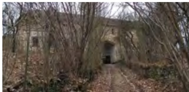
47. Karle čp. 55, zamýšlená rekonstrukce v roce 2006 byla ukončena demolicí roku 2014, foto J. Lenoč, 2008. Karle, No. 55, an intended reconstruction from 2006 was ended by demolition in 2014. Karle Hs.-Nr. 55, die geplante Rekonstruktion aus dem Jahre 2006 mündete im Abriss im Jahre 2014.
