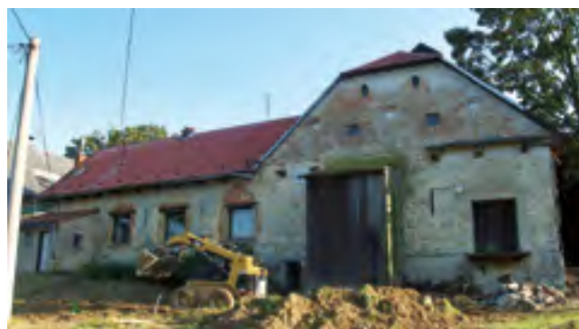
49. Koclířov čp. 11 (243), podoba nevyužívaných hospodářských částí usedlosti přestavěné na byt a sušku obilí, foto J. Lenoč 2009. Koclířov No. 11 (243), the appearance of unused agricultural parts of the farmstead rebuilt into a flat and a grain dryer. Koclířov Hs.-Nr. 11 (243), nicht genutzte Wirtschaftsteile wurden in eine Wohnung und Trockenraum für Getreide verwandelt.
