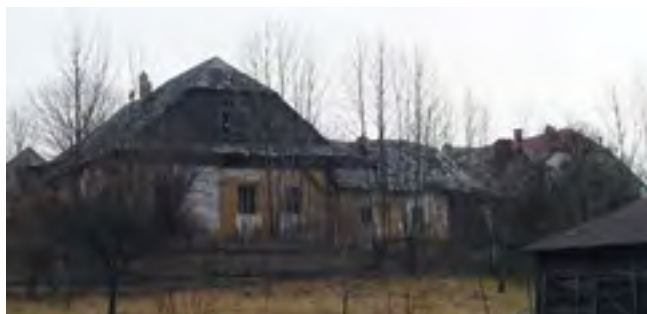
46. Květná čp. 7, po roce 2005 se zřítla střecha opuštěného výměnku, následně byly rozebírány ostatní budovy a v současnosti stojí jen pozůstatky obvodových zdí, foto J. Lenoč, 2005. Květná No. 7, roof of abandoned reservatum rusticum collapsed after 2005, other buildings were taken to pieces subsequently; only remnants of outside walls remain at present. Květná Hs.-Nr. 7, nach 2005 stürzte das Dach des verlassenen Ausgedinges ein, danach wurden die anderen Gebäude abgetragen, heutzutage stehen hier nur die Reste der Umfassungsmauern.
