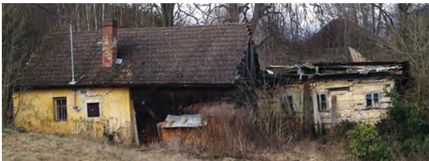
43. Horákova Lhota čp. 1, po zřícení střechy v roce 2007 ponechána usedlost na pospas přírodě, foto J. Lenočh, 2006. Horákova Lhota No. 1, after roof collapse in 2007, the farmstead was left exposed to the forces of nature. Horákova Lhota (Horaköhlütte) Hs.-Nr. 1, nach dem Einsturz des Daches im Jahre 2007 wurde der Bauernhof den Kräften der Natur überlassen.
