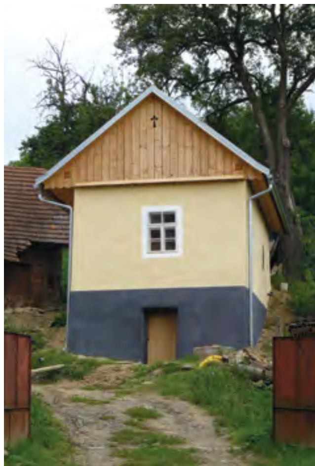
6. Výměnek po obnově, 2012, foto V. Říhová. Reservatum rusticum after the reconstruction. Ausgedinge nach der Erneuerung.
