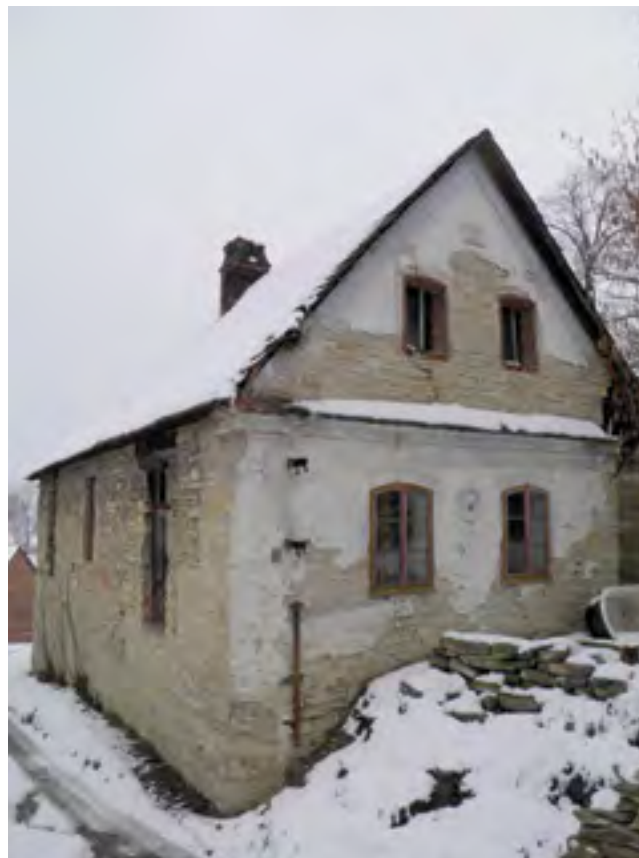
17. Mravín čp. 10, pohled na průčelí domu domkáře, postaveného po požáru v roce 1877, 2011, foto Z. Vařeková. Mravín No. 10, view of the facade of a cottager house built after the 1877 fire. Mravín Hs.-Nr. 10, Fassade eines nach dem Brand im Jahre 1877 gebauten Häuslerhauses.
