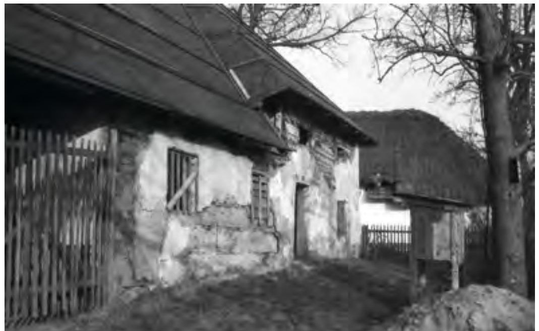
3. Rekonstrukce domu čp. 64 v Rymicích, 1982, foto J. Langer, Oddělení dokumentace VMP. Reconstruction of house No. 64 in Rymice. Rekonstruktion des Hauses Nr. 64 in Rymice.
