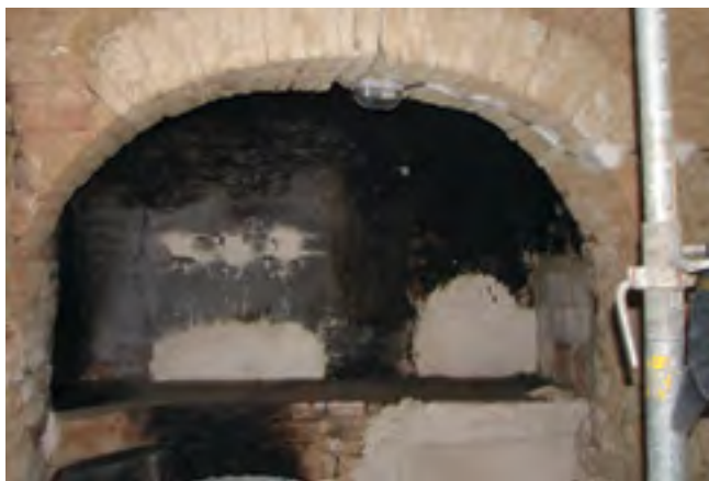
16. Mravín čp. 3, pohled na zazděná ústí obslužných otvorů (zleva kamna, pec) pod dymníkem v kuchyňské nische v zadní části síně, 2011, foto Z. Vařeková. Mravín No. 3, view of the bricked up utility holes (from the left: stove, oven) under the chimney hood in the kitchen niche in the rear part of the hall. Mravín Hs.-Nr. 3, vermauerte Wandöffnungen vom Ofen unter dem Rauchschlot in der Küchennische im hinteren Teil des Hausflurs.
