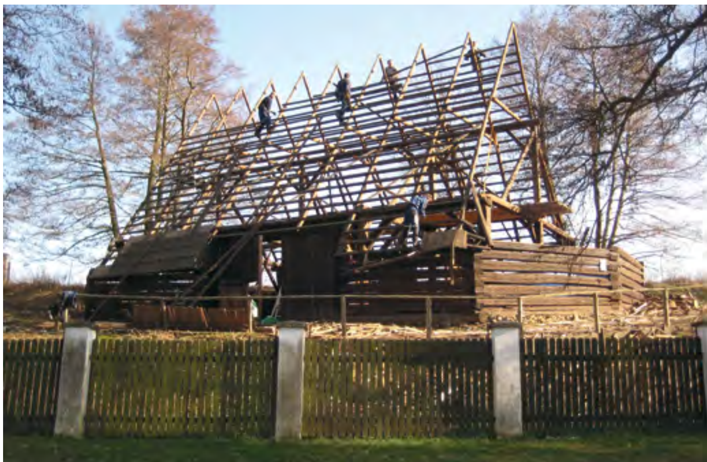
5. Durdice čp. 7, rozebírání stodoly při druhém transferu, 2012, foto V. Rišlink, RM Kolín. Durdice No. 7, disassembly of the barn before the second transfer. Durdice Hs.-Nr. 7, Abbau der Scheune während der zweiten Transferierung.
