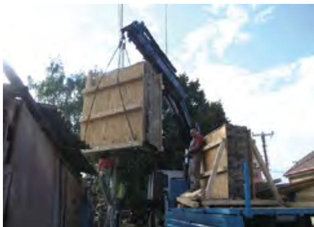
16. Dům čp. 65 v Oskořínku, přenesení dvou kompaktních bloků zdiva z nepálených cihel pomocí jeřábu z původního místa na nákladní auto, září 2015, foto M. Hanzlíková, NPÚ ÚOP SČ. House No. 65 in Oskoříněk, the transfer of two compact blocks of masonry from the original place onto a lorry using a crane. Haus Nr. 65 in Oskoříněk, Transferierung der zwei kompakten Mauerwerkblöcke aus luftgetrockneten Ziegeln mithilfe eines Krans vom ursprünglichen Aufstellungsort auf den Lastkraftwagen.
