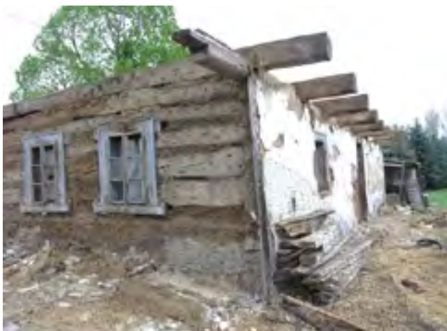
7. Dům čp. 65 v Oskořínce, stav po demontáži krovu, duben 2015, foto M. Hanzlíková, NPÚ ÚOP SČ. House No. 65 in Oskořínek, the state after the disassembly of the roof truss. Haus Nr. 65 in Oskořínek, Zustand nach dem Abbau des Dachstuhls.
