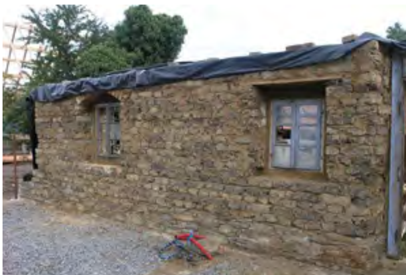
15. Přerov nad Labem, nově vyzděné dvorní průčelí domu s podsíní čp. 65 z Oskořínku z přenesených nepálených cihel, pohled z interiéru, září 2015, foto M. Hanzlíková, NPÚ ÚOP SČ. Přerov nad Labem, the courtyard facade of house with arcade No. 65 from Oskoříněk newly lined with transferred unfired bricks, view from the interior. Přerov nad Labem, die unter der Verwendung von transferierten Lehmziegeln neu gemauerte Hoffassade des Vorlaubenhauses Nr. 65 aus Oskoříněk, Ansicht vom Hausinneren.
