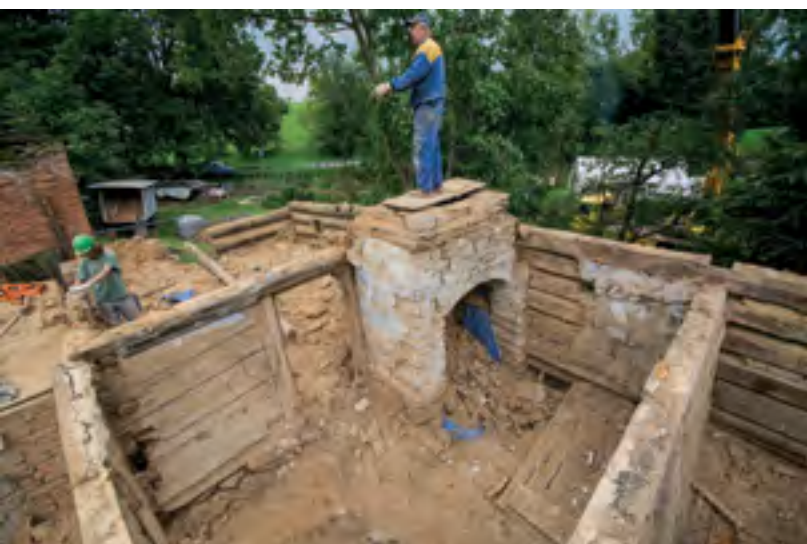
1. Průběh demontáže roubenného domu čp. 97 v Čisté, 2015, foto J. Kmošek. The course of the disassembly of timbered house No. 97 in Čistá. Verlauf des Abbaus vom Blockhaus Hs.-Nr. 97 in Čistá.
