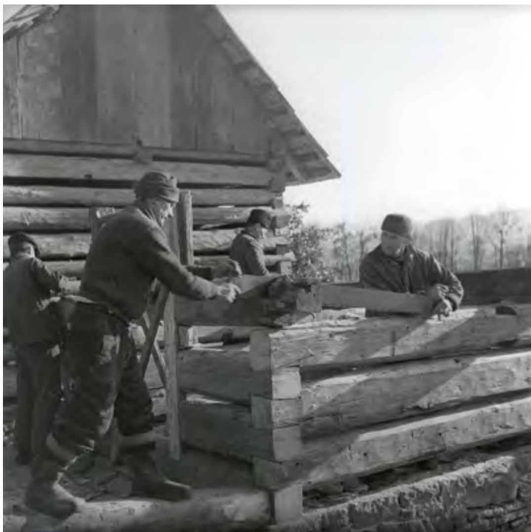
9. Chalupa z Leskovce, při stavbě jsou využívány starší prvky i nové prvky, vyniká ruční práce. 1963, foto V. Bulavová, oddělení dokumentace VMP. Cottage of a landless person from Leskovce. Older elements from the material reserves as well as new elements were used during the construction, outstanding manual work. Das Haus eines Landlosen aus Leskovce, beim Wiederaufbau wurden sowohl ältere Bauelemente aus den Materialvorräten wie auch neue Teile benutzt, ausgezeichnete Handarbeit.
