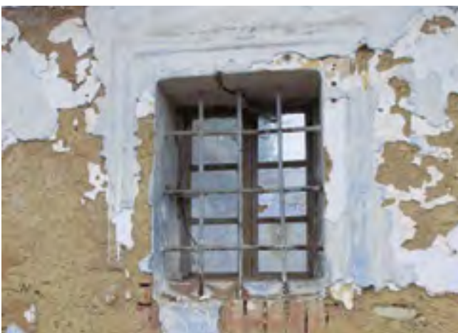
9. Dům čp. 65 v Oskořínce, stav po demontáži krovu, okno komorového dílu, duben 2015, foto M. Hanzlíková, NPÚ ÚOP SČ. House No. 65 in Oskořínek, the state after the truss disassembly, a window of the chamber section. Haus Nr. 65 in Oskořínek, Zustand nach dem Abbau des Dachstuhls, Wohnspeicherfenster.
