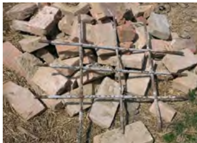
10. Dům čp. 65 v Oskořínce, neodborně demontovaná mříž, osvětlení a nadpraží okna komorového dílu, duben 2015, foto M. Hanzlíková, NPÚ ÚOP SČ. House No. 65 in Oskořínek, unprofessionally removed bars, jamb casing and head jambs of the chamber section window. Haus Nr. 65 in Oskořínek, unfachmännisch abgebautes Gitter sowie Anschlag des Wohnspeicherfensters.
