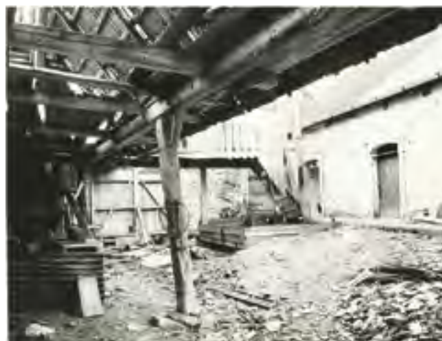
16. Stav hospodářské části usedlosti čp. 19, polootevřená kolna, před rozebráním a transferem na Veselý Kopec, 1995, foto P. Dostál, fotoarchiv SLS Vysočina. Agricultural part of farmstead No. 19 – the half-opened shed – the condition before its disassembly and transfer to Veselý Kopec. Erhaltungszustand des Wirtschaftsteiles vom Bauernhof Hs.-Nr. 19 – halboffener Schuppen – vor dem Abbau und vor der Transferierung ins Freilichtmuseum Veselý Kopec.
