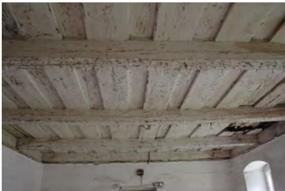
12. Nález původního dřevěného stropu při odstranění rákosového podhledu ve světnici, usedlost čp. 56 v Trstěnici, 2016, foto V. Kmošek. Finding of the original wooden ceiling after the removal of cane ceiling in the sitting room, farmstead No. 56 in Trstěnice. Fund der ursprünglichen Holzdecke nach dem Abtragen der Schilfverkleidung in der Stube, Bauernhof Hs.-Nr. 56 in Trstěnice.
