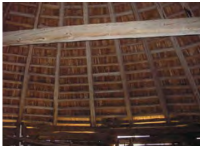
9. Konstrukce krovu polygonální stodoly, 2015, foto P. Bulena, fotoarchiv SLS Vysočina. Construction of the roof truss of the polygonal barn. Konstruktion des Dachstuhls der polygonalen Scheune.
