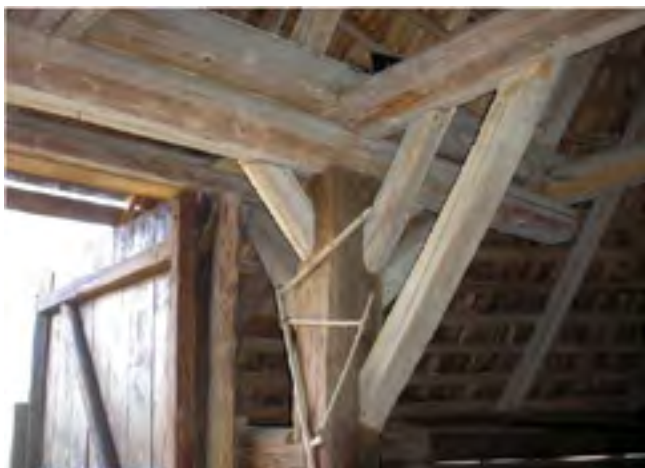
8. Konstrukce nosné stolice polygonální stodoly, 2015, foto P. Bulena, fotoarchiv SLS Vysočina. Construction of the roof truss supporting column of the polygonal barn. Konstruktion des Tragwerkes der polygonalen Scheune.
