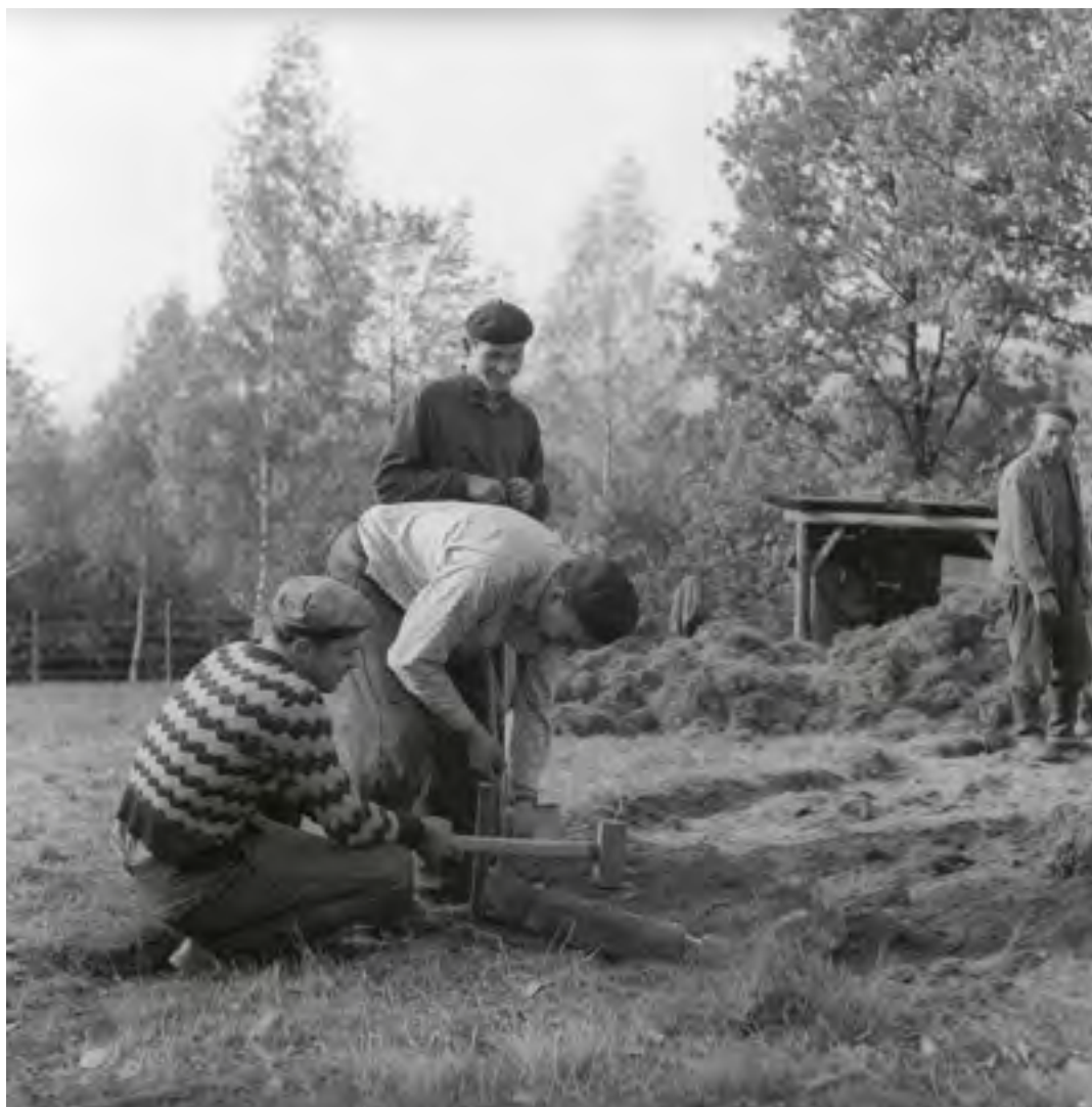
7. Zakládání chalupy z Miloňova na Valašské dědině přímo na srovnaný terén, ohnutý muž je mistr stavební skupiny JZD Velké Karlovice Ludvík Holčák. 1962, foto V. Bulavová, oddělení dokumentace VMP. Laying of the foundations of a cottage from Miloňov in the Wallachian Village directly on the levelled terrain; the bent man is Ludvík Holčák, foreman of the building group of the collective farm Velké Karlovice. Die Gründung des Bauernhauses aus Miloňov im sog. Walachischen Dorf auf eingeebnetem Terrain, der sich bückende Mann ist der Meister der Baugruppe aus der Agrargenossenschaft Velké Karlovice Ludvík Holčák.
