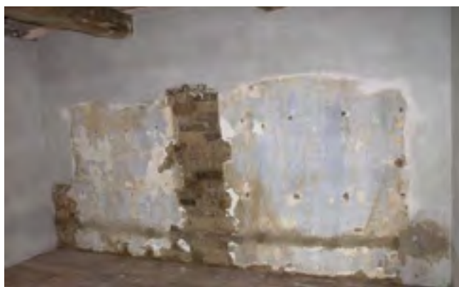
18. Přerov nad Labem, dva vzájemně provázané bloky zdiva včetně omazávky a vápenných nátěrů, interiér nově vyzděného komorového dílu domu čp. 65 z Oskořínku, září 2015, foto M. Hanzlíková, NPÚ ÚOP SČ. Přerov nad Labem, two interconnected blocks including coating and lime paint, the interior of the newly lined chamber section of house No. 65 from Oskoříněk. Přerov nad Labem, zwei miteinander verbundene Mauerwerkblöcke einschließlich Lehmputzes und Kalkanstrichs, Interieur des neu ausgemauerten Wohns-peicherteils vom Haus Nr. 65 aus Oskoříněk.
