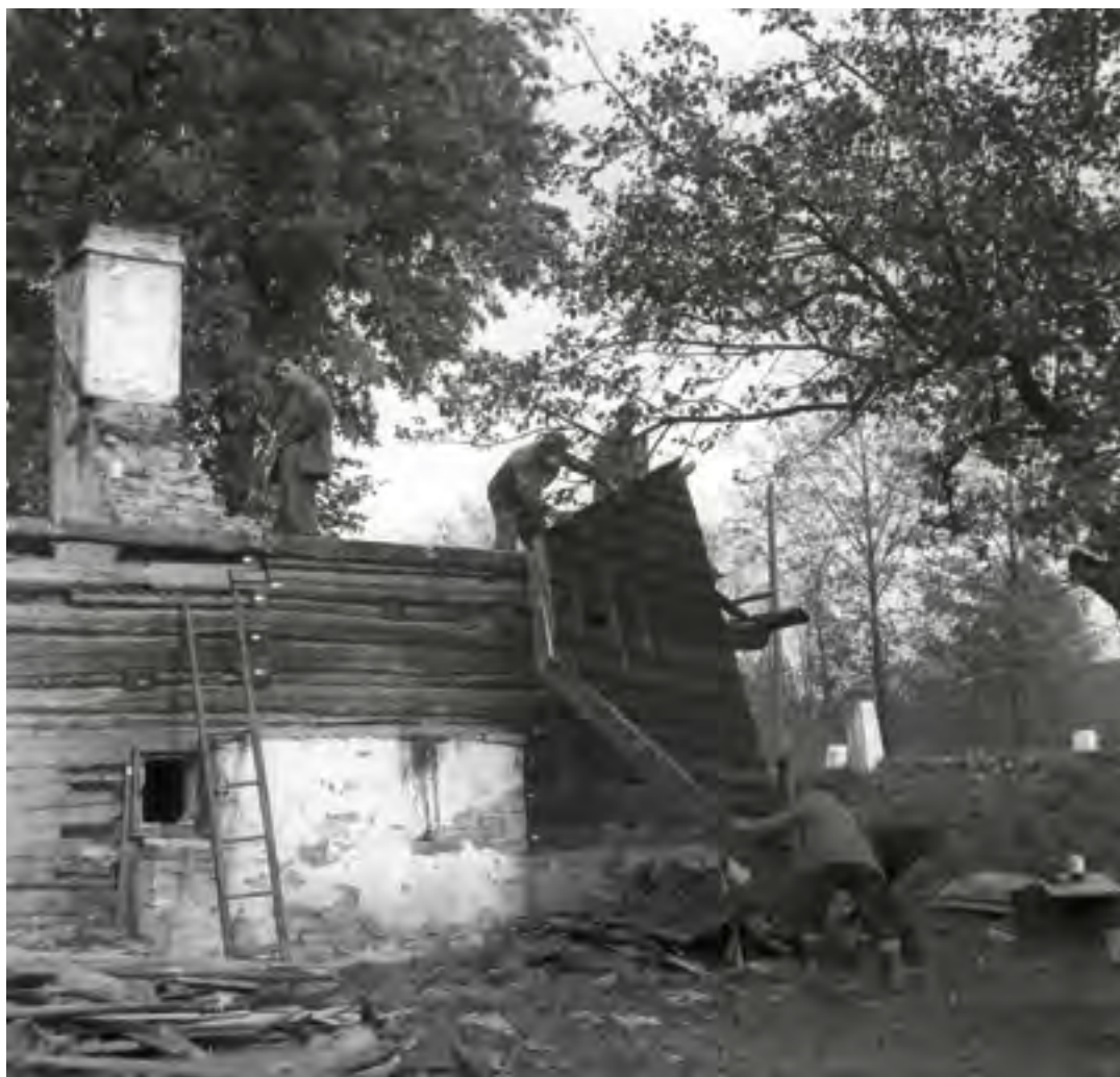
11. Chalupa z Valašské Polanky, v případě některých chalup probíhala demontáž konstrukcí v celku, snímání štítu objektu pod vedením Antonína Závady. 1967, foto M. Baďuříková, oddělení dokumentace VMP. Cottage from Valašská Polanka; the disassembly of some constructions was done in one piece in the case of certain cottages – removal of the gable under the supervision of Antonín Závada. Bauernhaus aus Valašská Polanka, im Falle einiger Bauernhäuser wurden ganze Konstruktionen abgetragen, Abbau der Giebelwand unter der Leitung von Antonín Závada.
