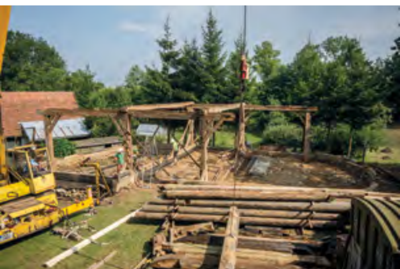
4. Průběh demontáže a převozu stavebních konstrukcí polygonální stodoly při usedlosti čp. 97 v Čistě, 2016, foto J. Kmošek. The course of the disassembly and transfer of building constructions of the polygonal barn at farmstead No. 97 in Čistá. Verlauf des Abbaus und Transports der Baukonstruktionen der polygonalen Scheune vom Bauernhof Hs.-Nr. 97 in Čistá.
