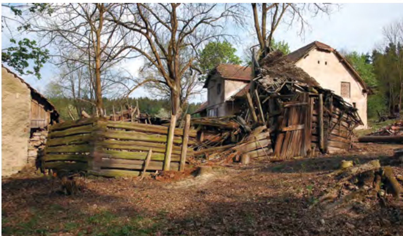
3, 4. Roubená polygonální stodola v usedlosti čp. 8 v Podolí u Vojkova před transferem do muzea ve Vysokém Chlumci, 2011, foto P. Dostál. Timbered polygonal barn in farmstead No. 8 in Podolí u Vojkova before its transfer to the museum in Vysoký Chlumeck. Gezimmete, polygonale Scheune vom Bauernhof Hs.-Nr. 8 in Podolí bei Vojkov vor der Transferierung ins Freilichtmuseum in Vysoký Chlumeck.
