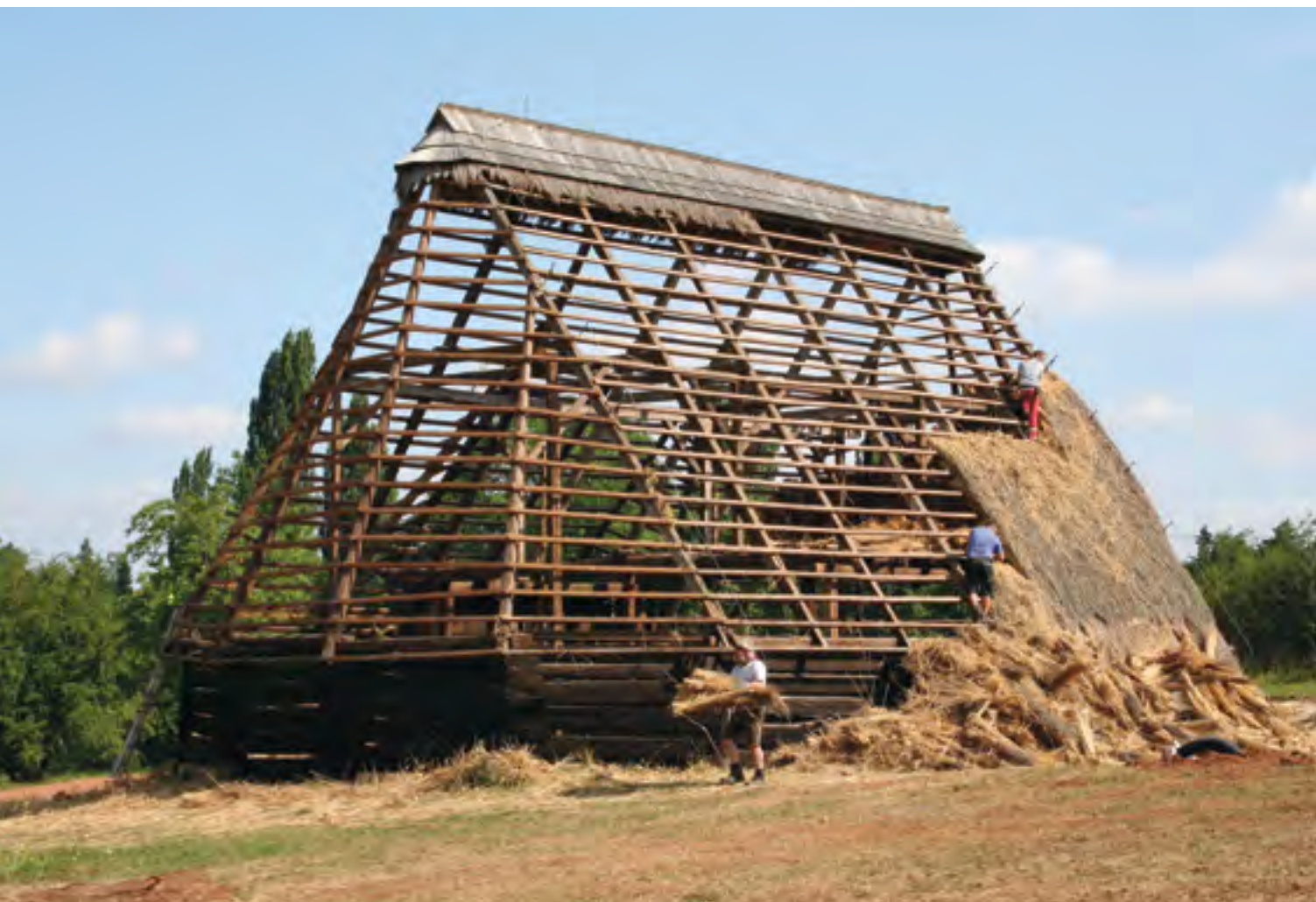
12. Želejov čp. 3, rozebírání stodoly při druhém transferu, 2015, foto V Rišlink, MLS Kouřim. Želejov No. 3, disassembly of the barn before the second transfer. Želejov Hs.-Nr. 3, Abbau der Scheune während der zweiten Transferierung.
