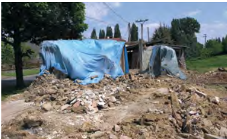
14. Dům s podsíní čp. 65 v Oskořínku, situace po přenesení roubeného dílu a částečné neodborné destrukci zdiva z nepálených cihel, zbývající hliněné zdivo provizorně překryto plachtami, červen 2015, foto M. Hanzlíková, NPÚ ÚOP SČ. House with arcade No. 65 in Oskoříněk, the situation after the transfer of the timbered part and partial unprofessional destruction of the unfired brick masonry, the remaining clay masonry provisionally covered by canvas. Vorlaubenhaus Nr. 65 in Oskoříněk, Zustand nach der Transferierung des Blockbauteiles und der unfachmännischen Destruktion des Mauerwerks aus luftgetrockneten Lehmziegeln, das restliche Lehm-mauerwerk ist provisorisch mit Planen bedeckt.
