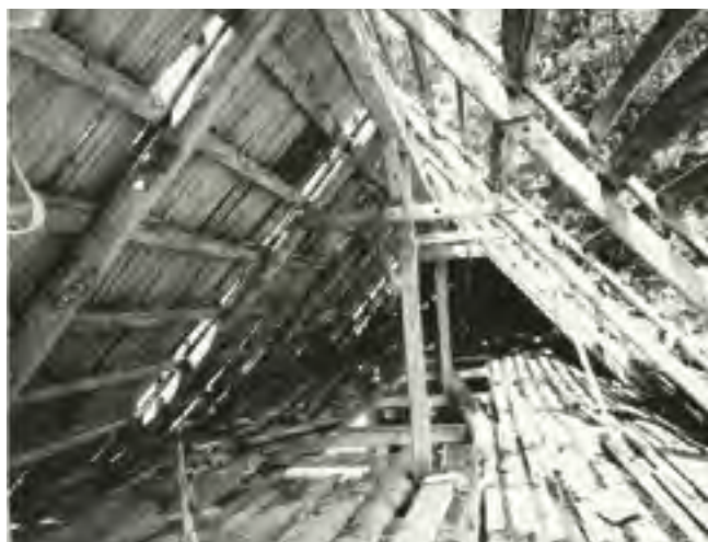
15. Stav hospodářské části usedlosti čp. 19, krov polootevřené kolny, před rozebráním a transferem na Veselý Kopec, 1995, foto P. Dostál, fotoarchiv SLS Vysočina. Agricultural part of farmstead No. 19 – the truss of the half-opened shed – the condition before its disassembly and transfer to Veselý Kopec. Erhaltungszustand des Wirtschaftsteiles vom Bauernhof Hs.-Nr. 19 – Dachstuhl des halboffenen Schuppens – vor dem Abbau und vor der Transferierung ins Freilichtmuseum Veselý Kopec.
