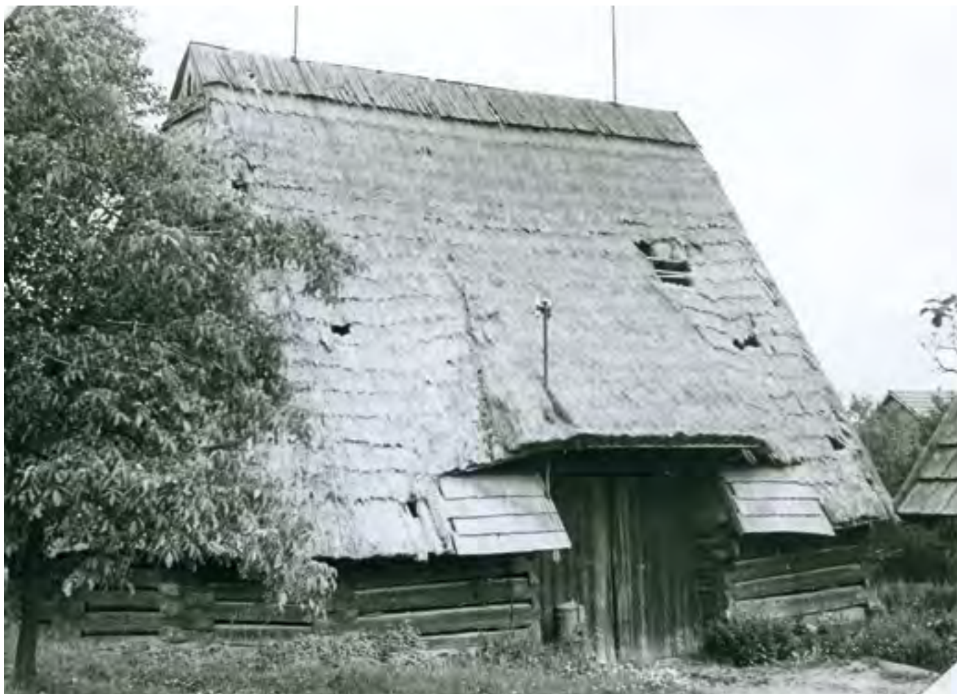
9. Želejov čp. 3, stodola in situ, asi 60. léta 20. stol., autor neznámý, RM Kolín. Želejov No. 3, the barn in situ. Želejov Hs.-Nr. 3, Scheune in situ.
