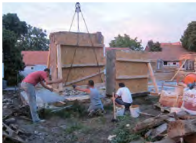
17. Přerov nad Labem, osazování dvou kompaktních bloků zdiva z uličního průčelí komorového dílu na připravenou podezdívku, září 2015, foto M. Hanzlíková, NPÚ ÚOP SČ. Přerov nad Labem, placing the two compact blocks from the street facade of the chamber section onto a prearranged socle. Přerov nad Labem, Wiederaufbau der zwei kompakten Mauerwerkblöcke von der Straßenseite des Wohns-peicherteils auf dem vorab vorbereiteten Sockel.
