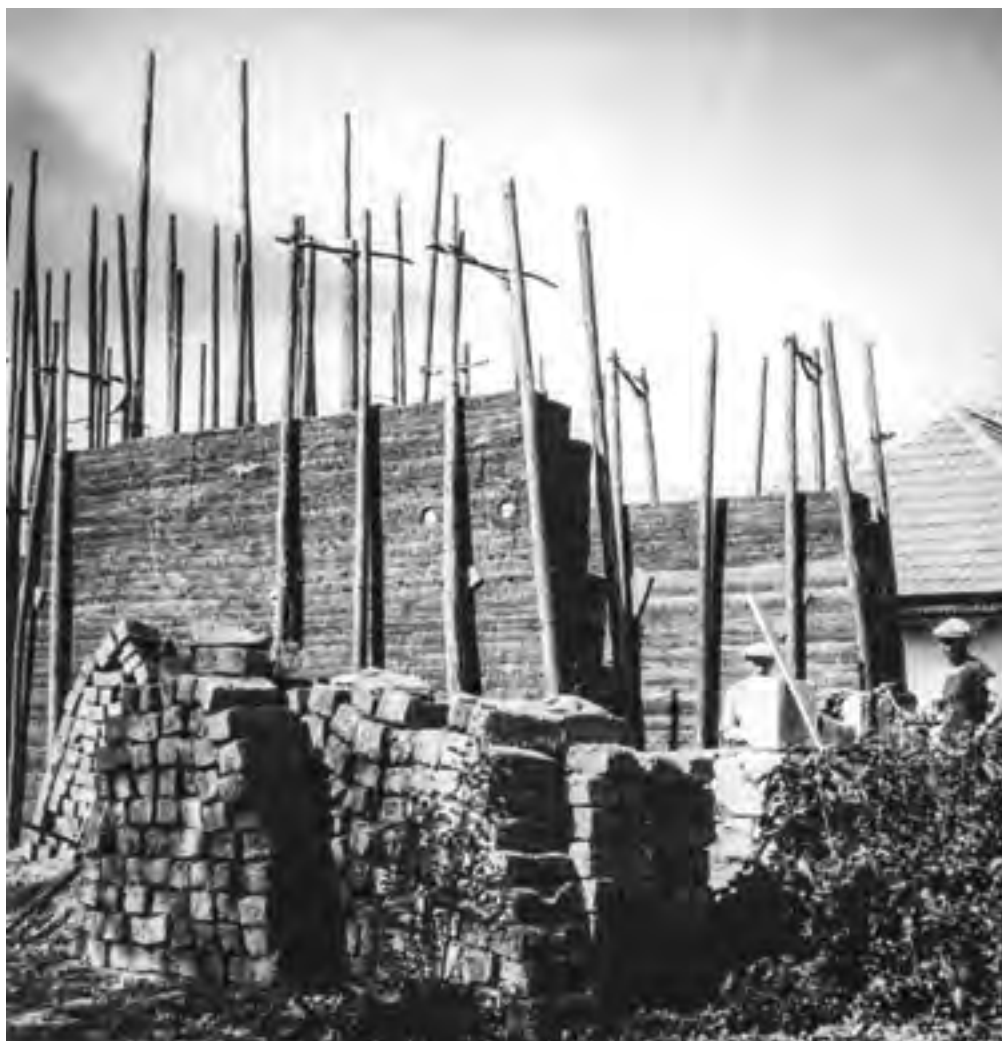
3. Stavba domu s nabíjenými stěnami za použití sloupového bednění, Abaújszántó (Maďarsko), nedat., Archiv Szabádtéri Néprajzi Múzeum. Construction of a house with packed-down walls using column formwork. Bau des Hauses mit Lehmstampfmauerwerk unter der Benutzung von Pfostenschalung.
