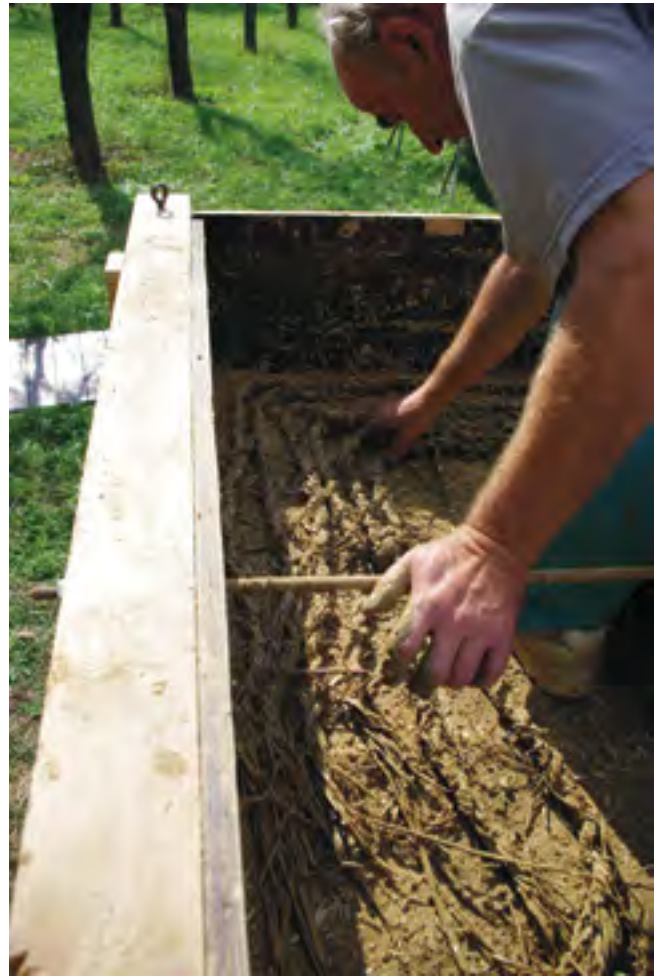
2. Experimentální stavba provedená technikou nabíjeného zdiva (Muzeum vesnice jihovýchodní Moravy) – zpevnění nároží pomocí slaměných povřísel, 2011, foto M. Novotný, fotoarchiv NÚLK. Experimental construction built using the technique of packed-down masonry (Museum of South-East Moravian Village) – reinforcement of the corners using straw binders. Experimenteller Bau, ausgeführt in der Technik des Lehmstampfmauerwerks (Muzeum vesnice jihovýchodní Moravy) – die Mauerecken wurden mit Strohseilen verstärkt.
