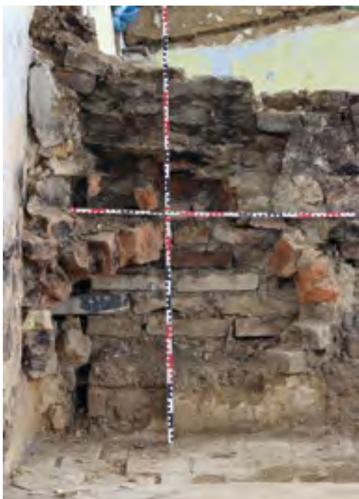
13. Dům s podsíní čp. 65 v Oskořínku, prostor topeniště, torzo kapkovité pece s druhotnou vyzdívkou, fotografický podklad pro zpracování fotoměřičské dokumentace, červen 2015, foto A. Rákosníková, NPÚ ÚOP SČ. House with arcade No. 65 in Oskoříněk, the fireplace area, the torso of a drop-shaped oven with secondary lining, photographic material used for the preparation of photometric documentation. Vorlaubenhaus Nr. 65 in Oskoříněk, Feuerstelle, Torso des tropfenförmigen Ofens mit sekundärer Ausmauerung, fotografische Unterlage für die Ausarbeitung der fotometrischen Dokumentation.
