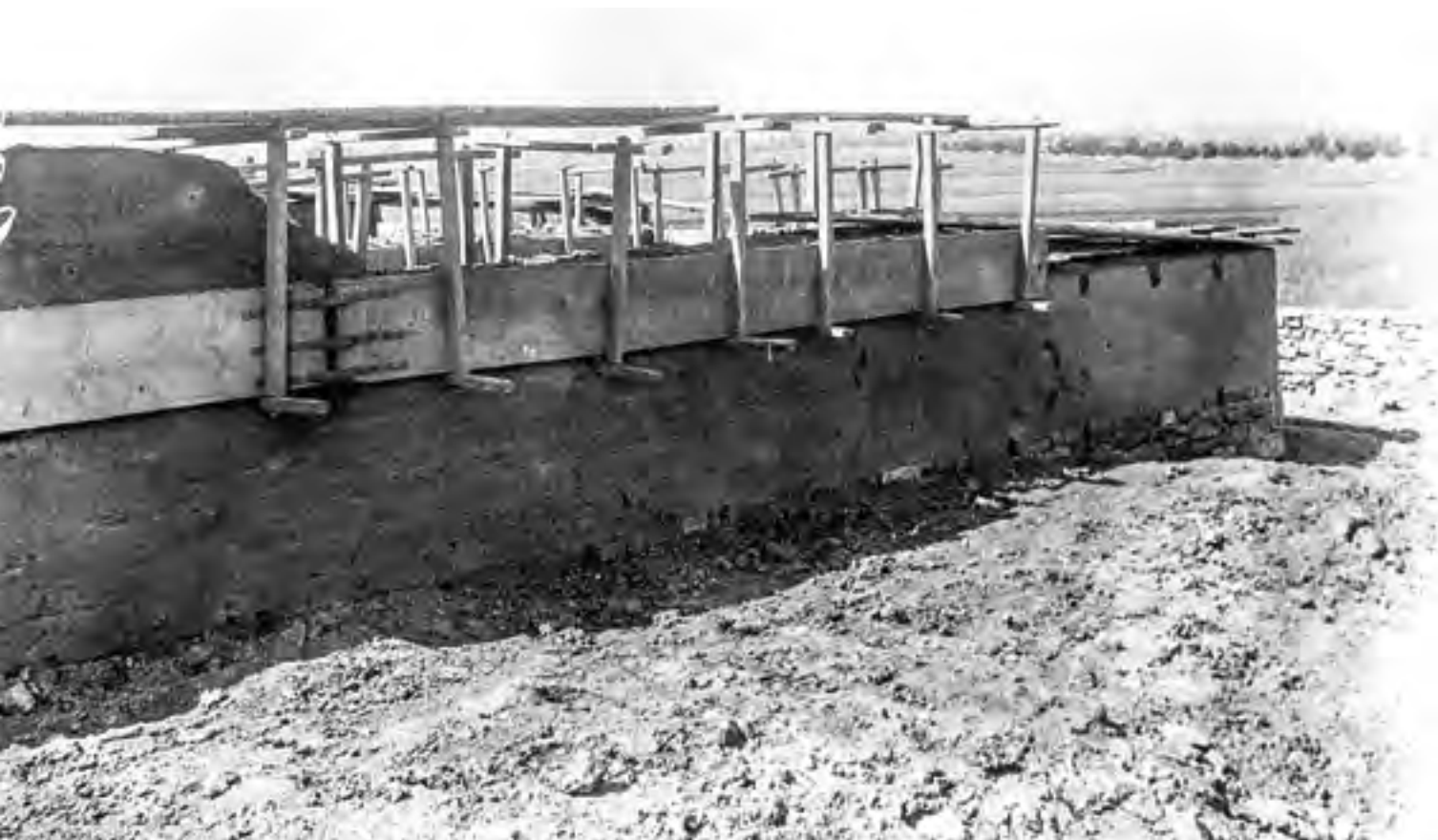
4. Stavba nabíjených stěn pomocí jármového bednění, Hroznová Lhota, 1910, foto K. Chotek, archiv M. Novotného. Construction of packed-down walls using yoke formwork, Hroznová Lhota. Errichtung des Lehmstampfmauerwerks mithilfe von Jochschalung, Hroznová Lhota.
