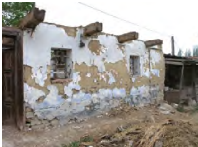
8. Dům čp. 65 v Oskořínce, po demontáži krovu, zděná část dvorního průčelí s okny do síně a komorového dílu, duben 2015, foto M. Hanzlíková, NPÚ ÚOP SČ. House No. 65 in Oskořínek, after the truss disassembly, the brick part of the courtyard facade with windows leading into the hall and the chamber section. Haus Nr. 65 in Oskořínek, nach dem Abbau des Dachstuhls, der gemauerte Teil der Hoffassade mit den Fenstern zur Stube und zum Wohnspeicherteil.
