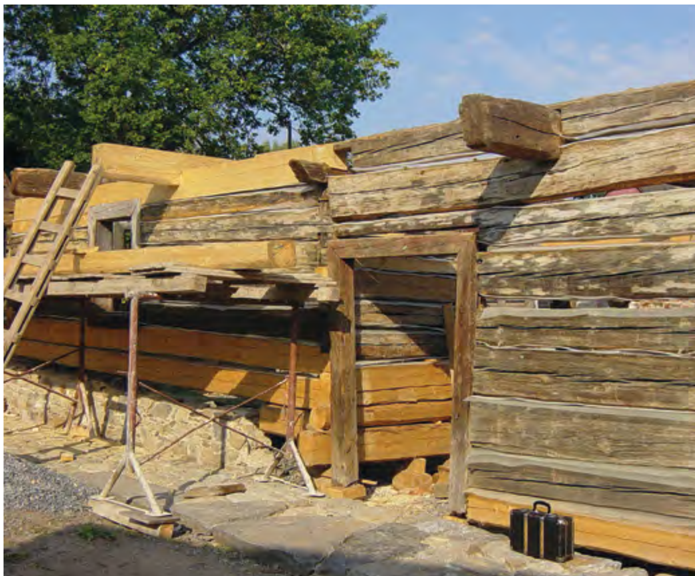
24, 25, 26. Stavba transferovaného domu čp. 3 z Arnoštic v muzeu ve Vysokém Chlumci, 2003, foto P. Dostál. Construction of the transferred house No. 3 from Arnošovice in the museum in Vysoký Chlumec. Wiederaufbau des transferierten Hauses Nr. 3 aus Arnošovice im Freilichtmuseum in Vysoký Chlumec.
