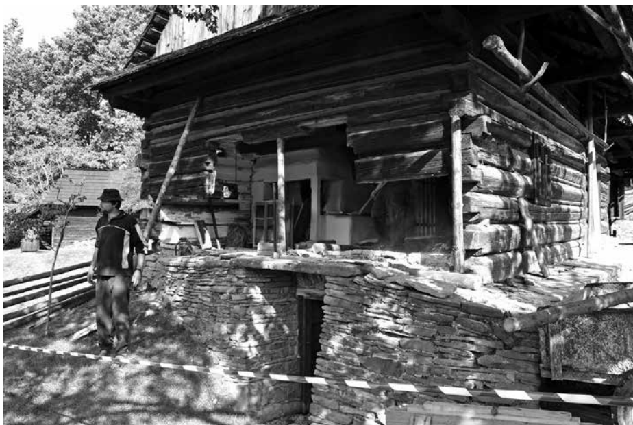
Valašská dědina, chalupa z Lužné během realizace stavebních úprav, 2015, foto J. Jurka, fotoarchiv VMP
