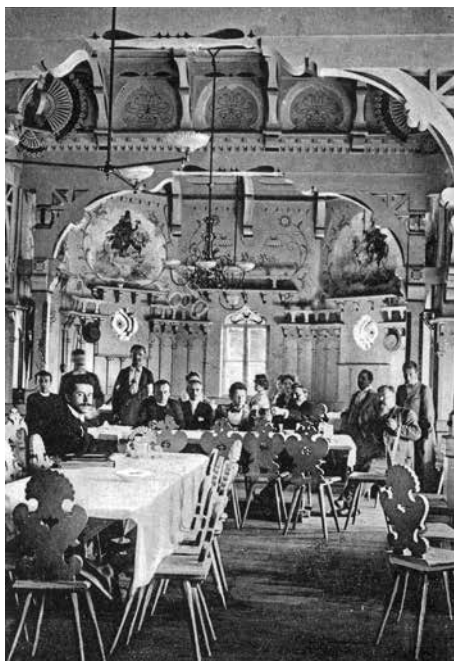
Interiér Libušína, acetylenové osvětlení s využitím prozatímních svítidel, pohlednice z poč. 20. st., Oddělení dokumentace VMP
