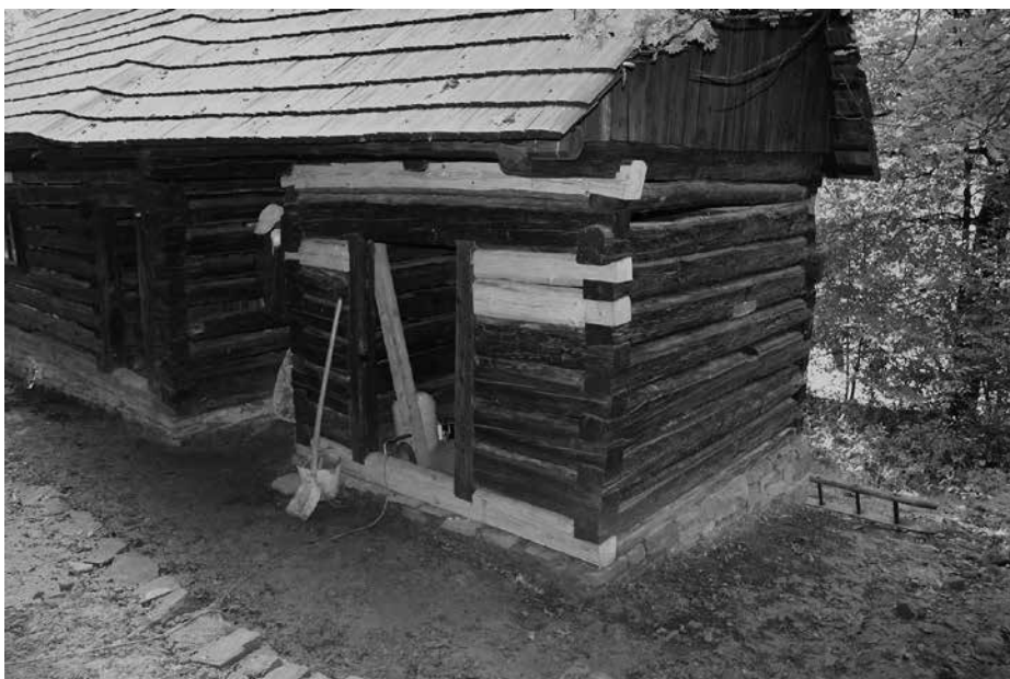
Valašská dědina, chalupa bezzemka z Leskovce, výměna nejvíce poškozených prvků za kopie provedené ručním tesáním, terénní úpravy kolem objektu, 2015, foto R. Bryol
