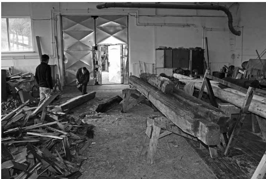
Vyjmuté prvky roubení chalupy z Lužné při posouzení, impregnaci a tvorbě kopií v tesařské hale muzea, 2015, foto R. Bryol
