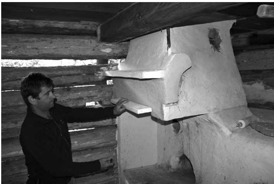
Valašská dědina, chalupa bezzemka z Leskovce, pec po stavebních úpravách – dřevěné prvky byly nahrazeny kamennými, tektonika zůstala zachována, 2015, foto R. Bryol
