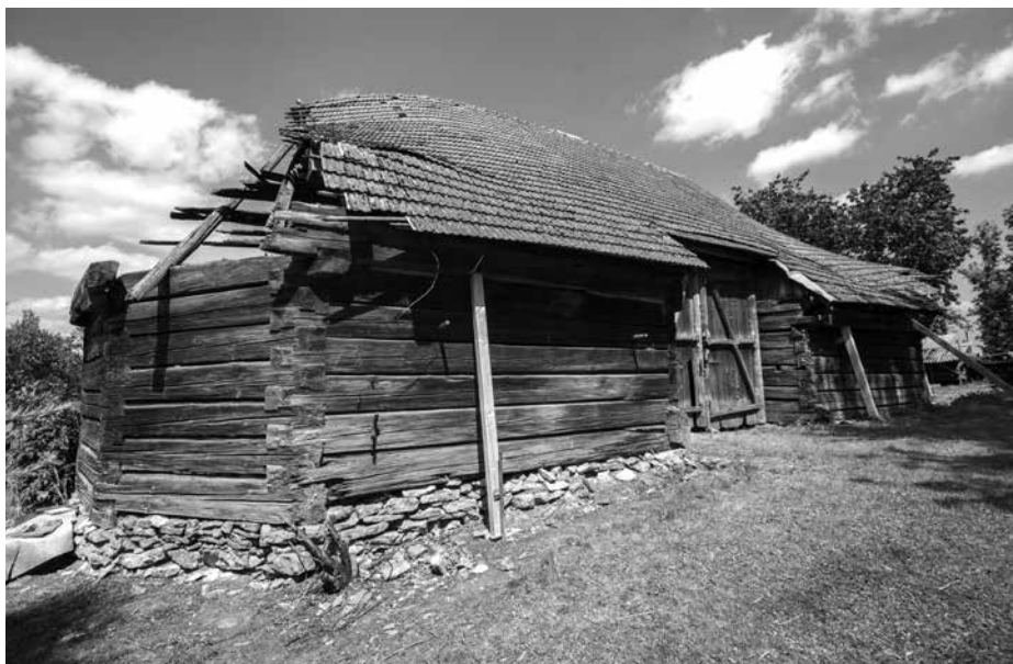
Roubená polygonální stodola usedlosti čp. 97 v obci Čistá u Litomyšle před transferem červenci roku 2015, foto J. Kmošek
