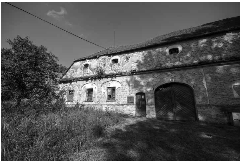
Průčelí zděné hospodářské usedlosti čp. 56 v Trstěnici u Litomyšle, 2015, foto J. Kmošek
