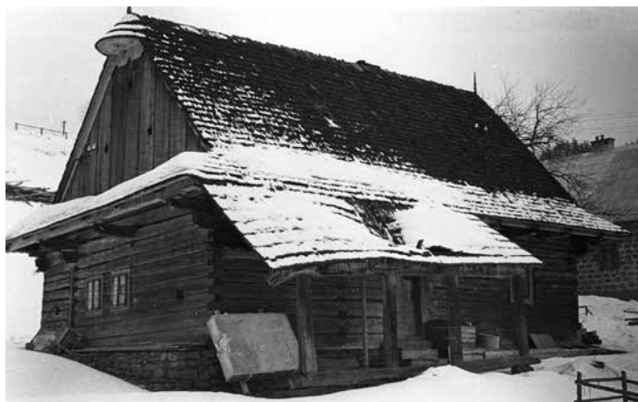
Pohled na komory ze dvora, 1968, foto B. Přikryl, fotoarchiv VMP
