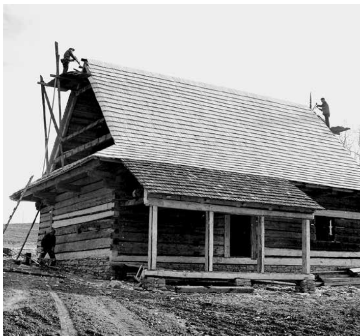
Stavba chalupy v muzeu po transferu, rekonstrukce stěny komory bez oken, použití nových trámů, 1969, foto L. Holčák, fotoarchiv VMP
