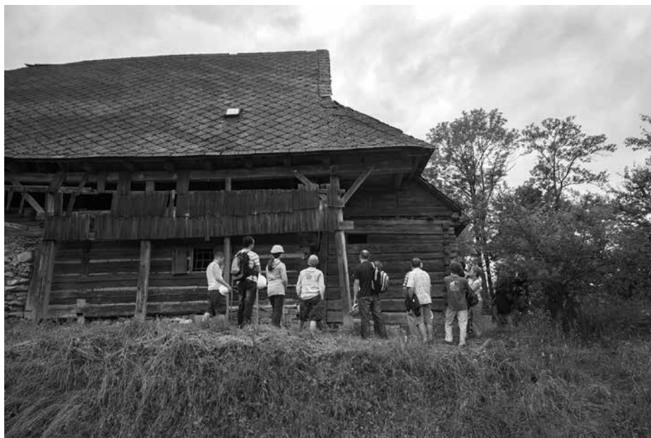
Roubený dům z usedlosti čp. 2 v obci Trstěnice u Litomyšle, 2015, foto J. Kmošek
