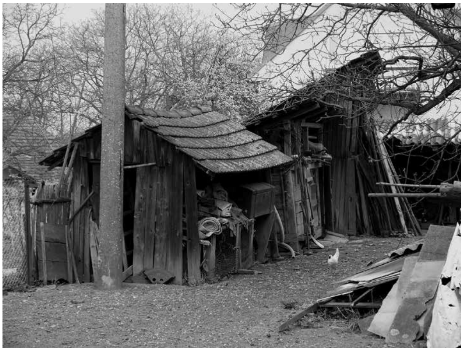
Zámrský čp. 16, chlévy a přístřešky rámové konstrukce s bedněním, 2014, foto R. Bryol, fotoarchiv VMP
