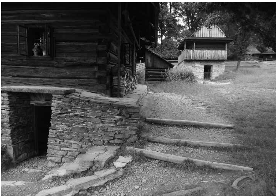
Mališova chalupa z Lužné s přirozeně provedenou násadou z doby budování areálu Na Stráni, před usedlostí je nevhodný zásyp průmyslovým kamenivem a netradiční detaily, vzadu je zídka zpevněná betonem, 2013, foto R. Bryol
