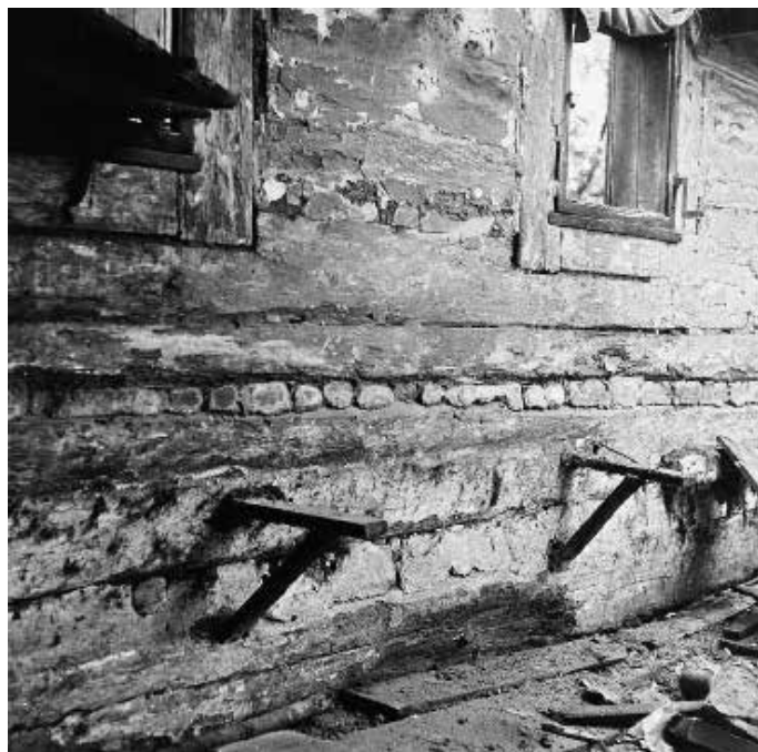
Demontáž: dřevěné konzoly, na nichž spočívala lavice na čelní stěně, fotoarchiv VMP.
