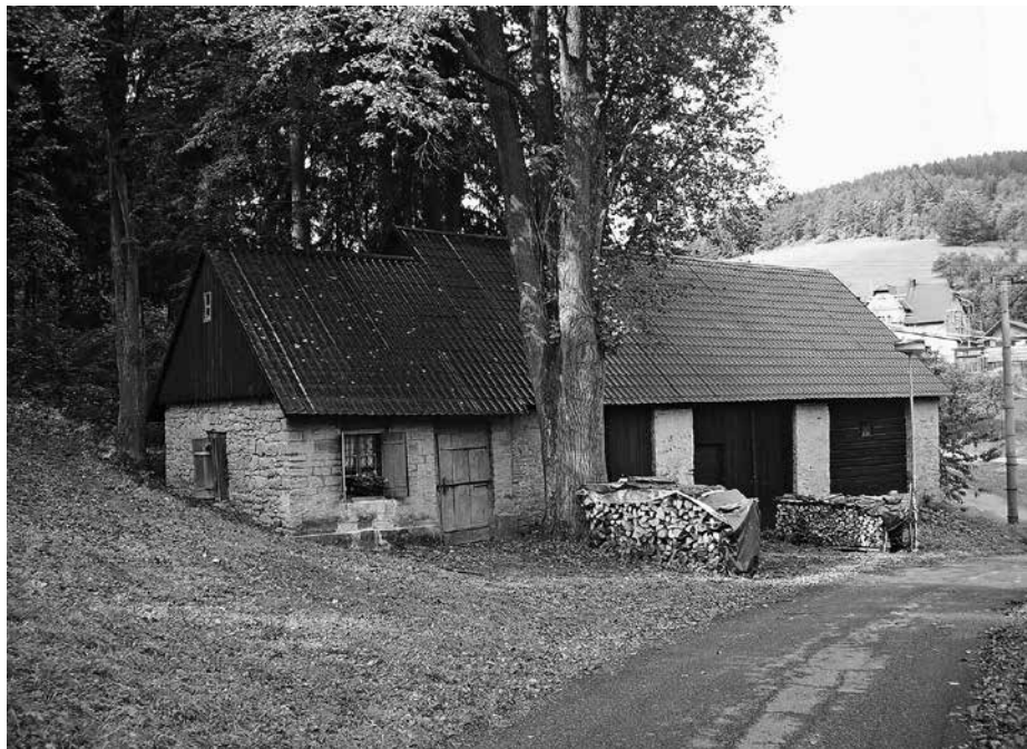
Objekt hospodařské budovy – stodoly u čp. 135 ve Zděchově, 2006, fotoarchiv VMP.
