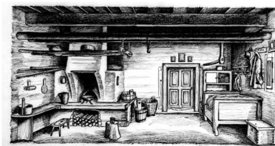
Pohled na pec s ohništěm. Vedle obkladu dveří jsou patrné zárubně původního širokého dvevního otvoru.
