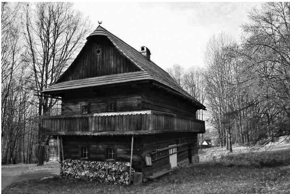
Objekt fojtství z jihovýchodní strany, foto Šárka Kramolišová.
