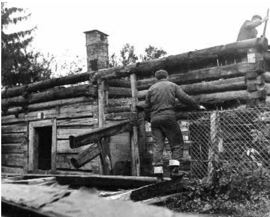
Demontáž: komín v celé výšce zděný z cihel, fotoarchiv VMP.
