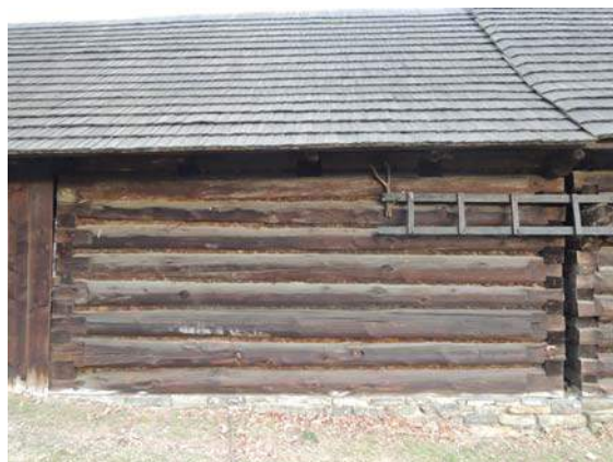
Obr. 83 Venkovní pohled na západní stěnu, pozice měření č. 16
