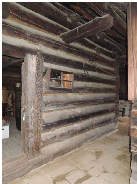
Obr. 85 Venkovní pohled na východní stěnu, pozice měření č. 18
