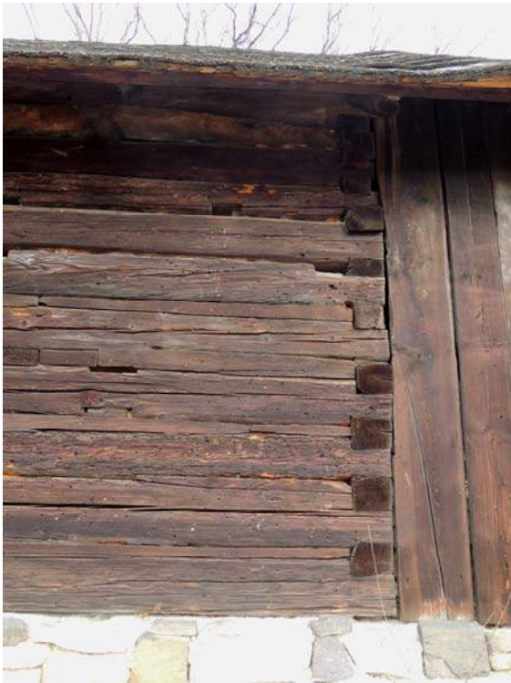
Obr. 50 Venkovní pohled na jižní stěnu, pozice měření č. 16
