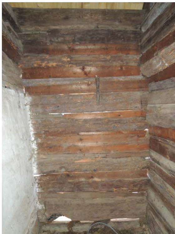
Obr. 37 Vnitřní pohled na jižní stěnu, pozice měření č. 7
