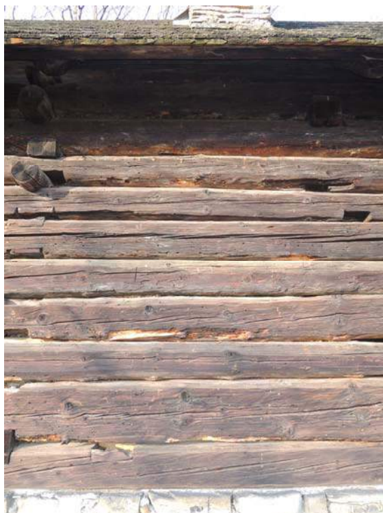
Obr. 34 Venkovní pohled na jižní stěnu, pozice měření č. 6
