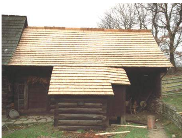
Obr. 13 Východní stěna chléva
