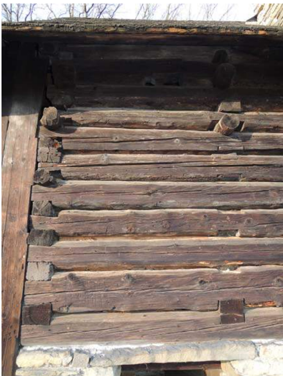
Obr. 36 Venkovní pohled na jižní stěnu, pozice měření č. 7
