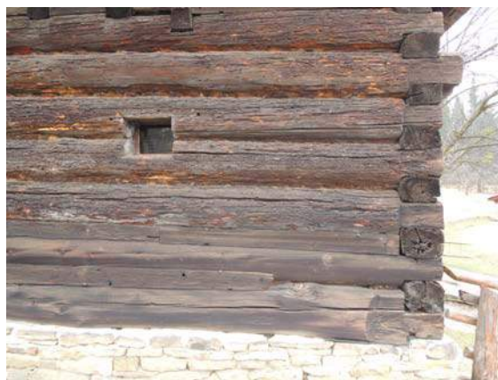
Obr. 79 Venkovní pohled na západní stěnu, pozice měření č. 14
