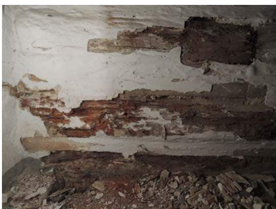
Obr. 63 Venkovní pohled na jižní stěnu, pozice měření č. 4
