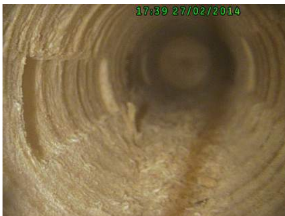
Obr. 109 Detail vrtu v trámu č. 5, západní stěna, pozice měření č. 14
