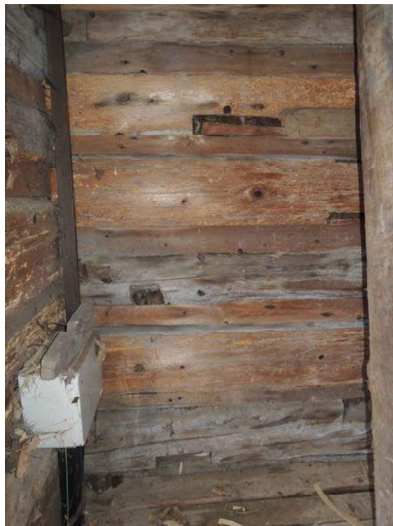
Obr. 47 Vnitřní pohled na východní stěnu, pozice měření č. 14
