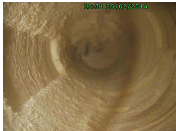
Obr. 89 Detail vrtu v trámu č. 6, severní stěna, pozice měření č. 2
