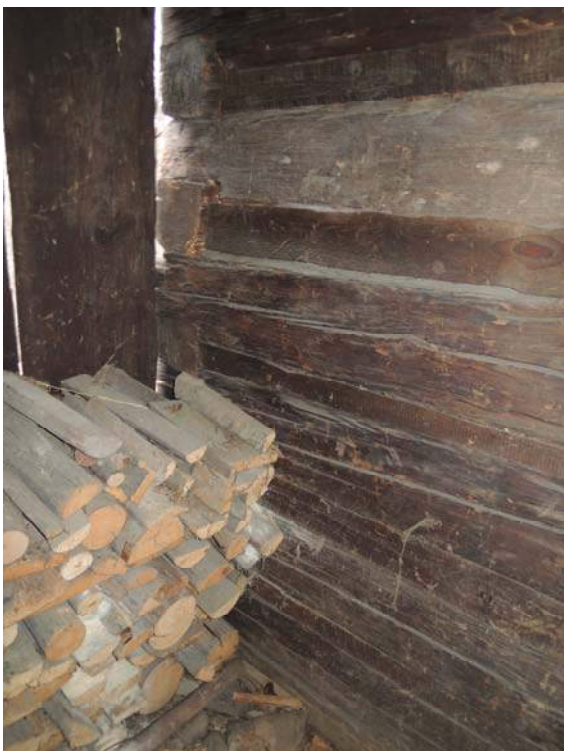
Obr. 48 Venkovní pohled na východní stěnu, pozice měření č. 15
