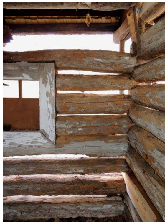
Obr. 27 Vnitřní pohled na severní stěnu, pozice měření č. 2
