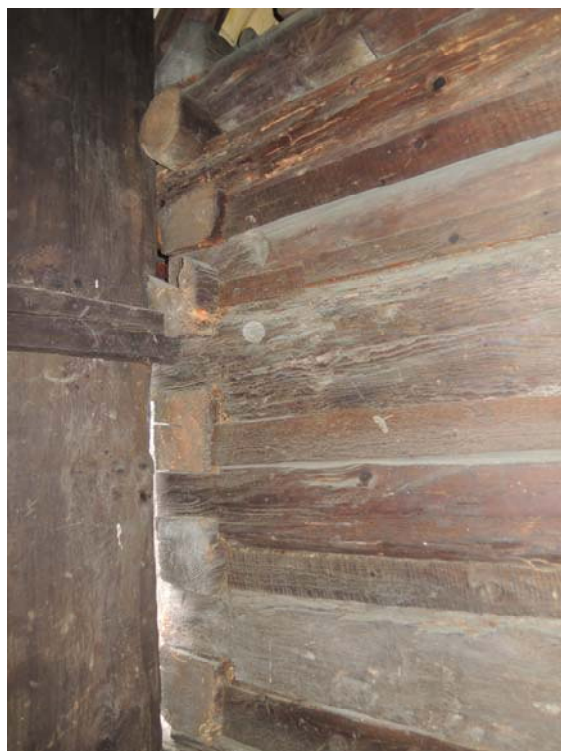
Obr. 49 Venkovní pohled na východní stěnu, pozice měření č. 15
