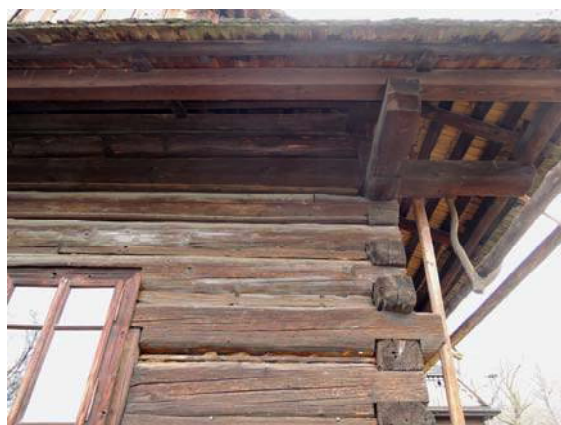
Obr. 62 Venkovní pohled na jižní stěnu, pozice měření č. 4
