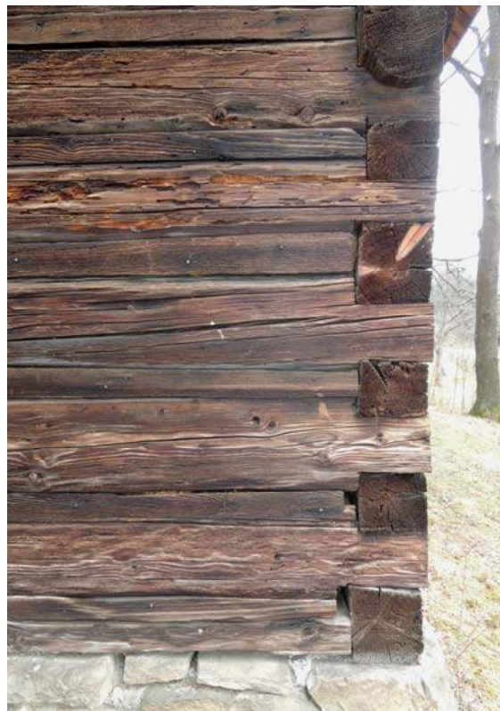
Obr. 55 Venkovní pohled na západní stěnu, pozice měření č. 18
