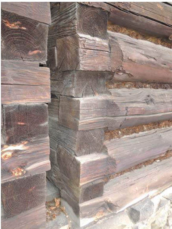
Obr. 72 Venkovní pohled na západní stěnu, pozice měření č. 11
