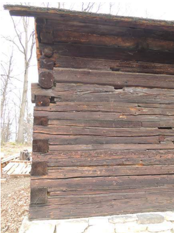
Obr. 52 Venkovní pohled na jižní stěnu, pozice měření č. 17
