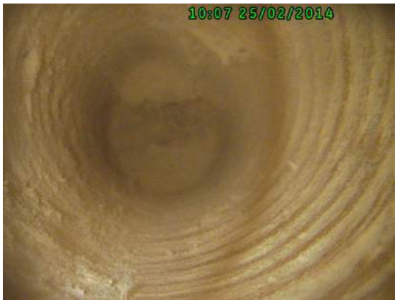
Obr. 86 Detail vrtu v trámu č. 3, severní stěna, pozice měření č. 1
