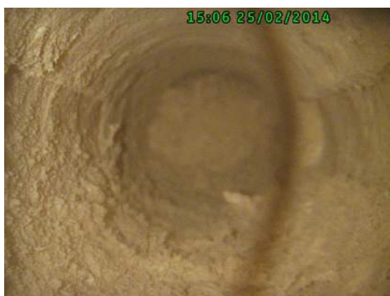
Obr. 96 Detail vrtu v trámu č. 6, jižní stěna, pozice měření č. 5
