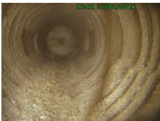
Obr. 111 Detail vrtu v trámu č. 7, západní stěna, pozice měření č. 14
