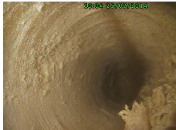
Obr. 87 Detail vrtu v trámu č. 5, severní stěna, pozice měření č. 1
