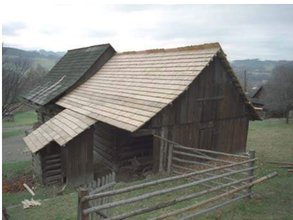
Obr. 10 Severní stěna chléva
