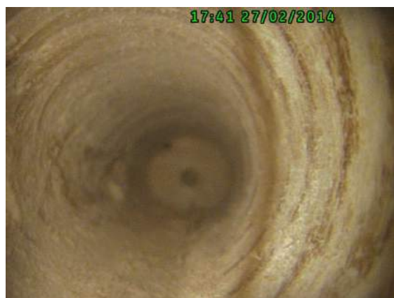
Obr. 112 Detail vrtu v trámu č. 4, jižní stěna, pozice měření č. 4
