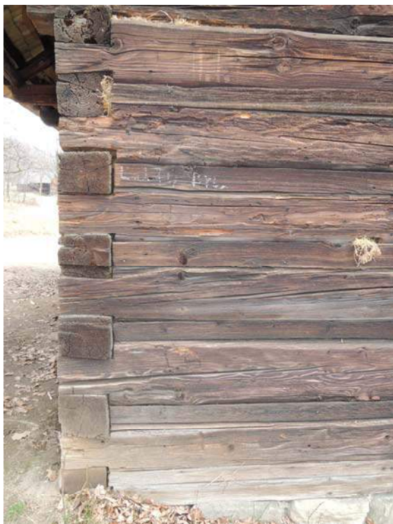
Obr. 56 Venkovní pohled na západní stěnu, pozice měření č. 19
