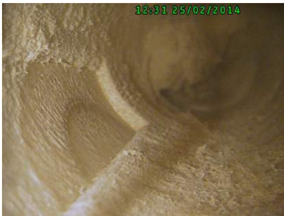
Obr. 88 Detail vrtu v trámu č. 6, severní stěna, pozice měření č. 1
