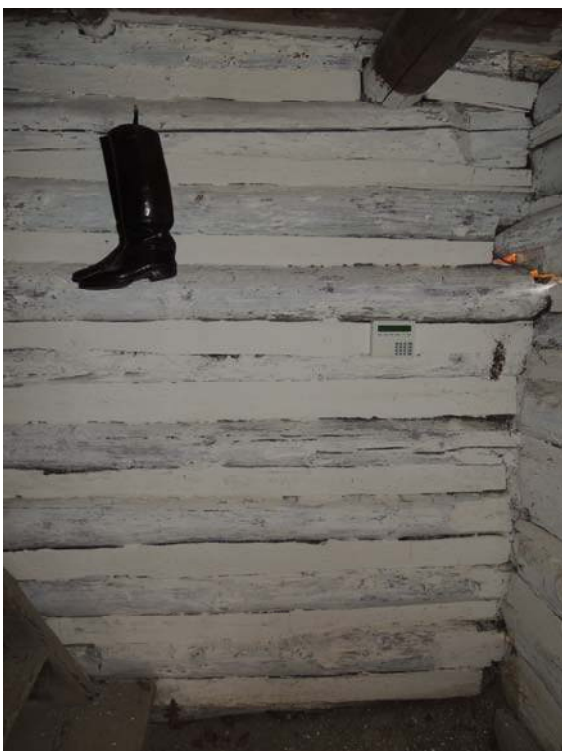
Obr. 70 Vnitřní pohled na severní stěnu, pozice měření č. 8
