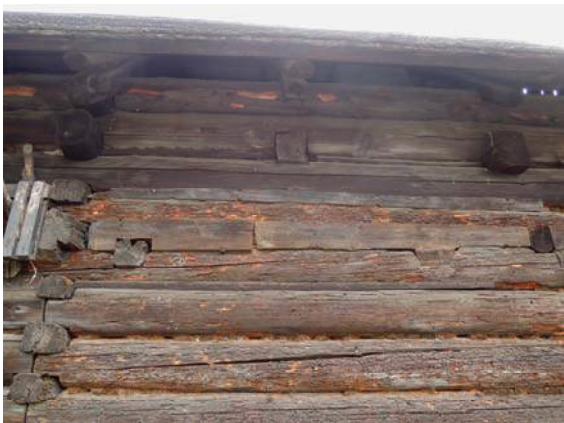
Obr. 76 Venkovní pohled na západní stěnu, pozice měření č. 13
