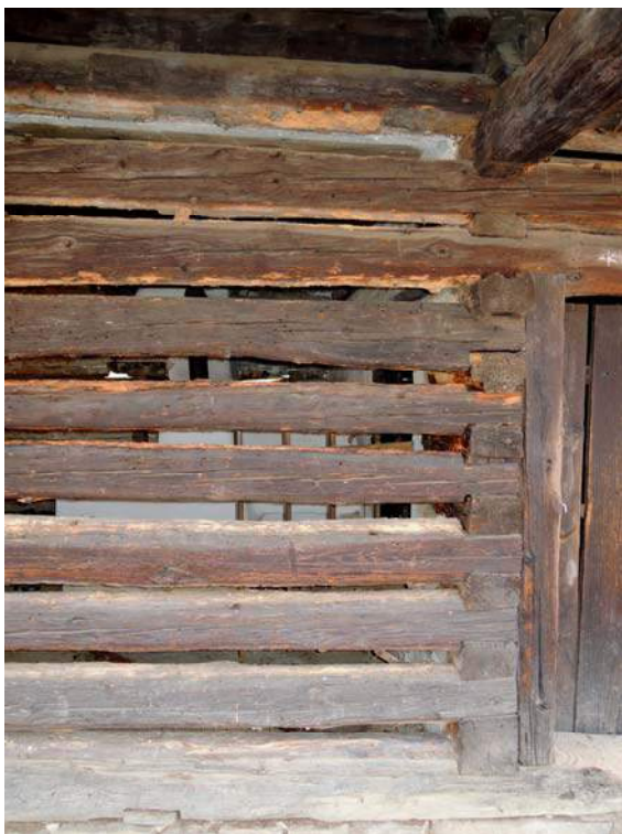
Obr. 24 Venkovní pohled na severní stěnu, pozice měření č. 1
