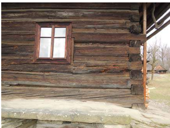
Obr. 61 Venkovní pohled na jižní stěnu, pozice měření č. 4
