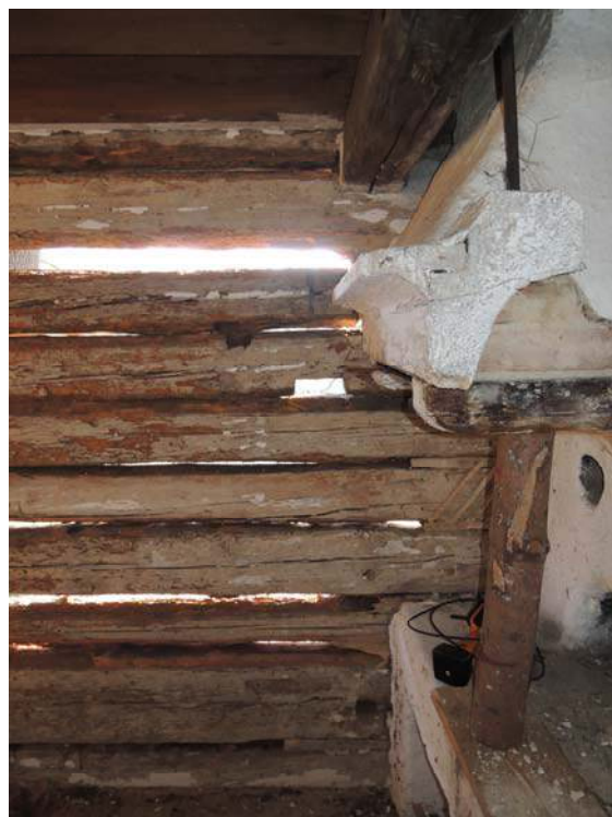
Obr. 35 Vnitřní pohled na jižní stěnu, pozice měření č. 6
