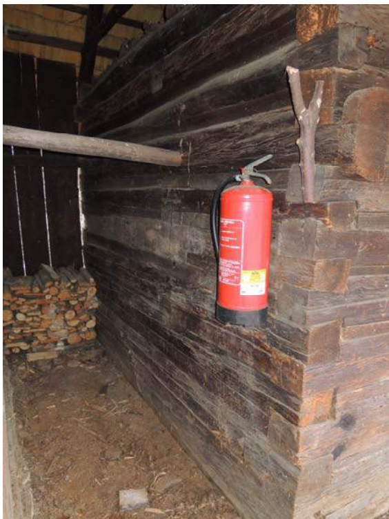
Obr. 46 Venkovní pohled na východní stěnu, pozice měření č. 14
