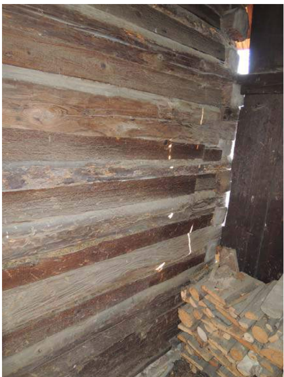
Obr. 38 Venkovní pohled na západní stěnu, pozice měření č. 8
