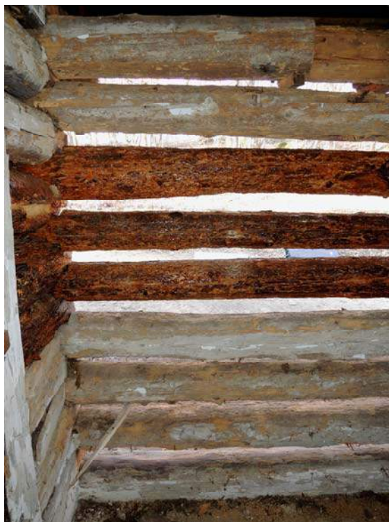
Obr. 25 Vnitřní pohled na severní stěnu, pozice měření č. 1
