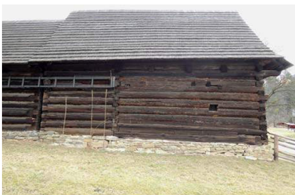
Obr. 14 Západní stěna obydlí
