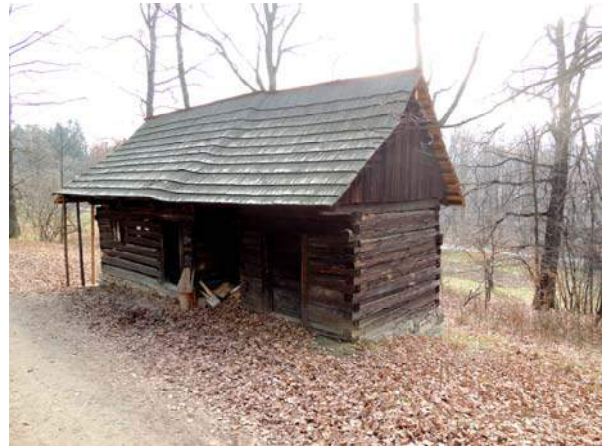
Obr. 5 Severní stěna obydlí a chléva
