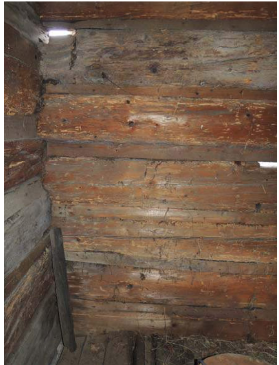
Obr. 51 Vnitřní pohled na jižní stěnu, pozice měření č. 16
