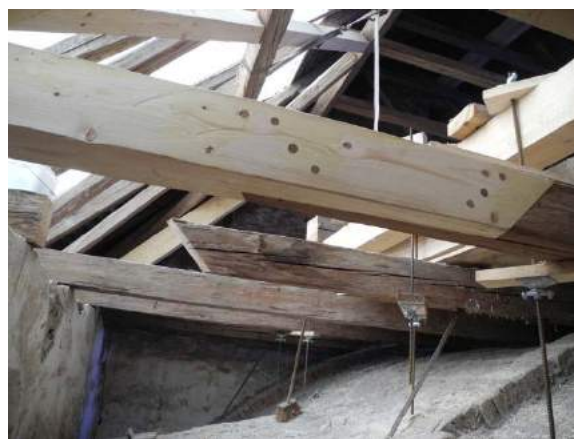
Obr. 111 Příklad sesazeného šikmého podélného se plátu se šikmým čelem s dosazením na šikmočelnou šiku (oprava krovu kostela ve Vranově nad Dyjí)
