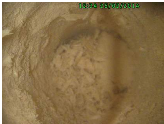
Obr. 94 Detail vrtu v trámu č. 8, východní stěna, pozice měření č. 3
