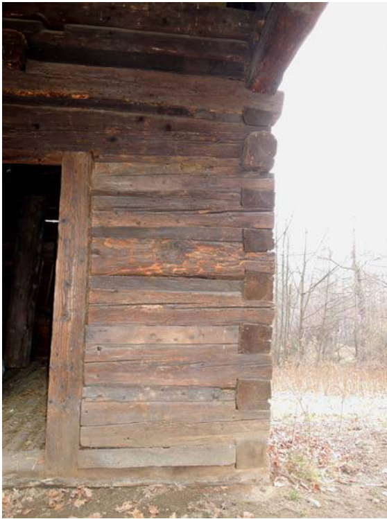
Obr. 42 Venkovní pohled na severní stěnu, pozice měření č. 12
