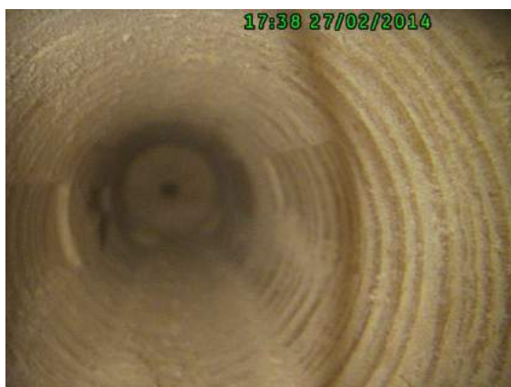
Obr. 107 Detail vrtu v trámu č. 3, západní stěna, pozice měření č. 14
