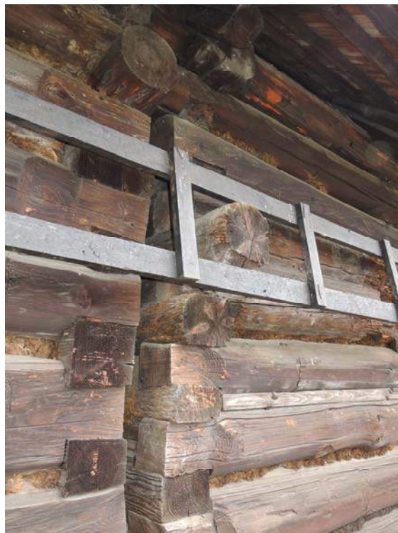
Obr. 73 Venkovní pohled na západní stěnu, pozice měření č. 11
