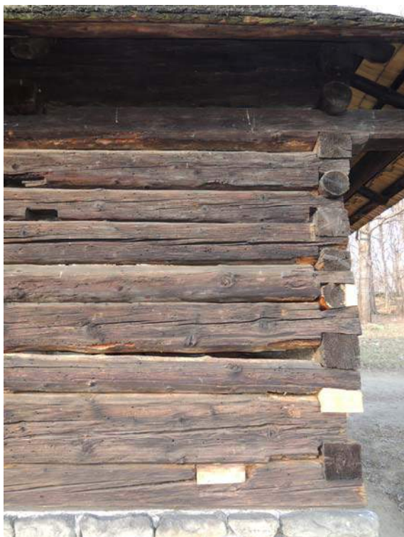
Obr. 32 Venkovní pohled na jižní stěnu, pozice měření č. 5
