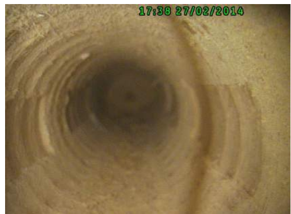
Obr. 108 Detail vrtu v trámu č. 4, západní stěna, pozice měření č. 14
