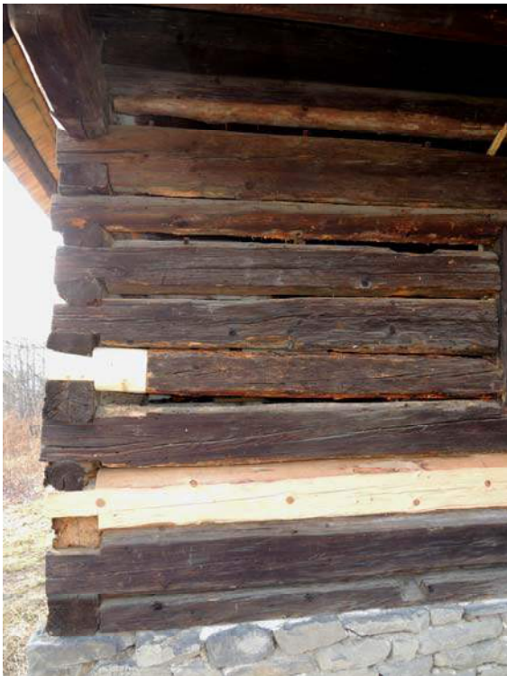
Obr. 30 Venkovní pohled na východní stěnu, pozice měření č. 4
