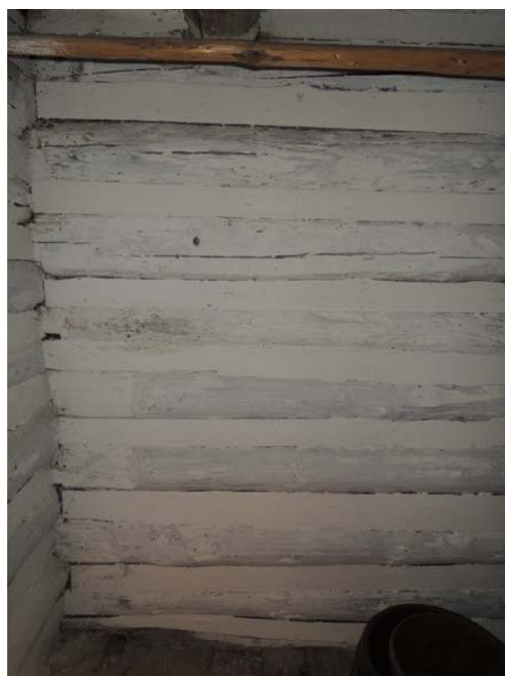
Obr. 71 Vnitřní pohled na severní stěnu, pozice měření č. 9
