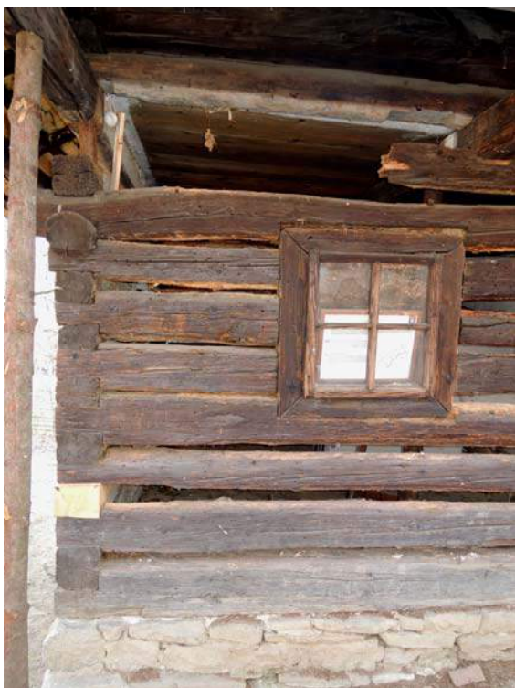
Obr. 26 Venkovní pohled na severní stěnu, pozice měření č. 2
