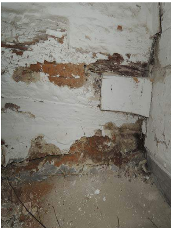
Obr. 60 Vnitřní pohled na jižní stěnu, pozice měření č. 1
