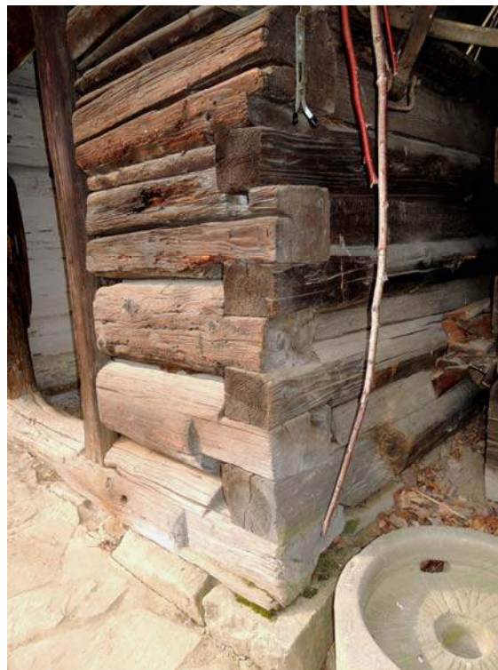
Obr. 69 Venkovní pohled na severní stěnu, pozice měření č. 8
