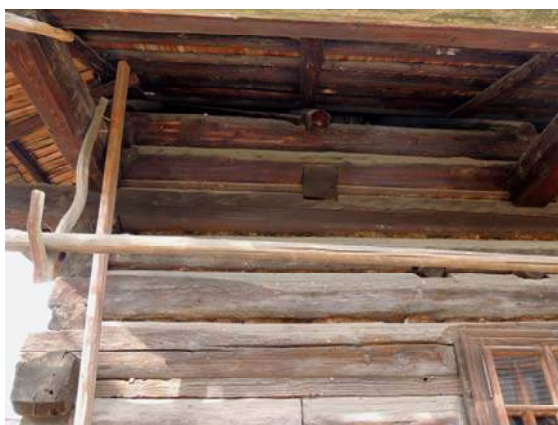
Obr. 65 Venkovní pohled na východní stěnu, pozice měření č. 5
