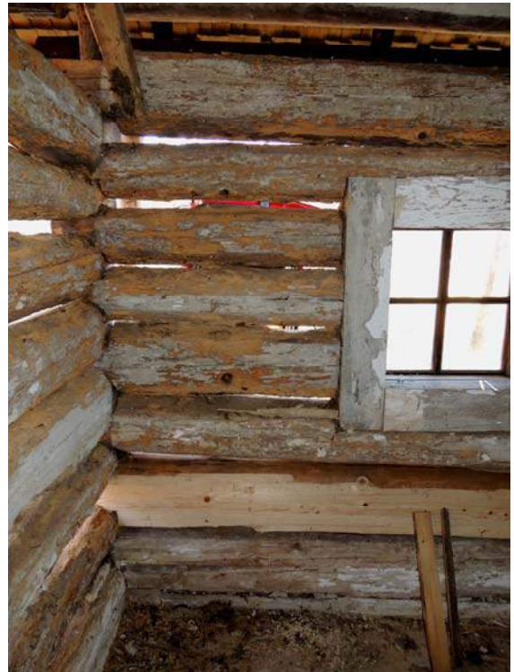
Obr. 29 Vnitřní pohled na východní stěnu, pozice měření č. 3
