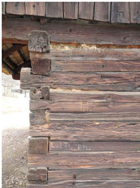
Obr. 57 Venkovní pohled na západní stěnu, pozice měření č. 19
