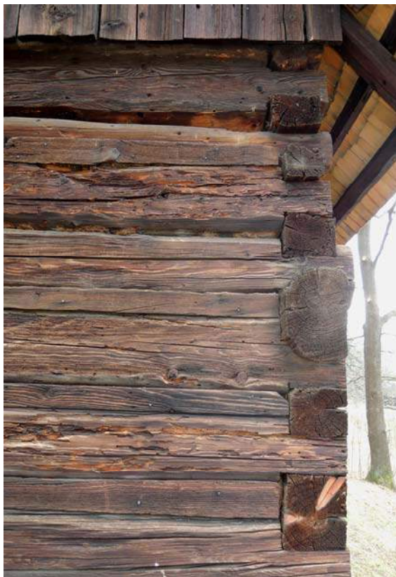
Obr. 54 Venkovní pohled na západní stěnu, pozice měření č. 18
