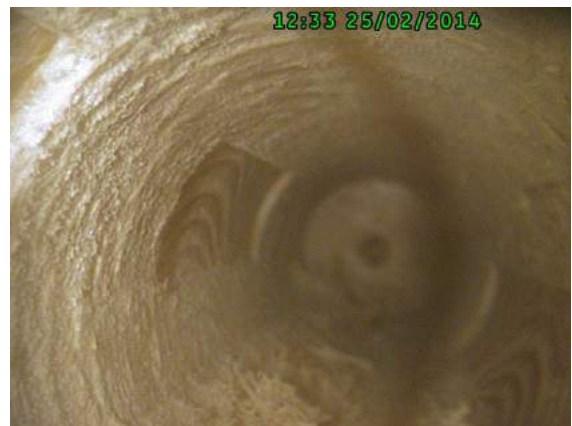
Obr. 93 Detail vrtu v trámu č. 5, východní stěna, pozice měření č. 3
