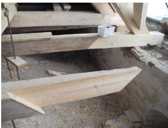
Obr. 110 Příklad použití šikmého podélného plátu šikmým čelem s dosazením na šikmočelnou šiku (oprava krovu kostela ve Vranově nad Dyjí)
