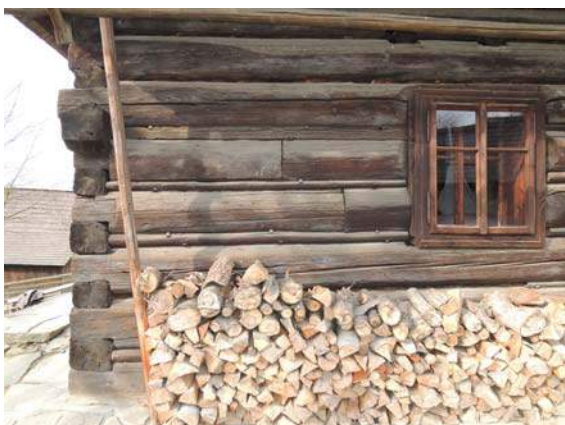
Obr. 64 Venkovní pohled na východní stěnu, pozice měření č. 5
