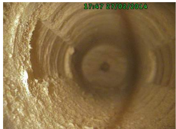
Obr. 106 Detail vrtu v trámu č. 4, jižní stěna, pozice měření č. 4
