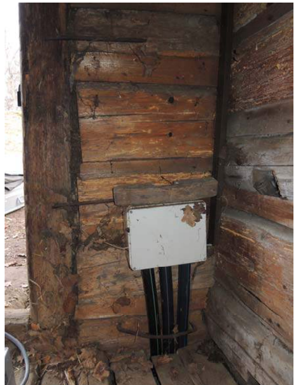
Obr. 45 Vnitřní pohled na severní stěnu, pozice měření č. 13
