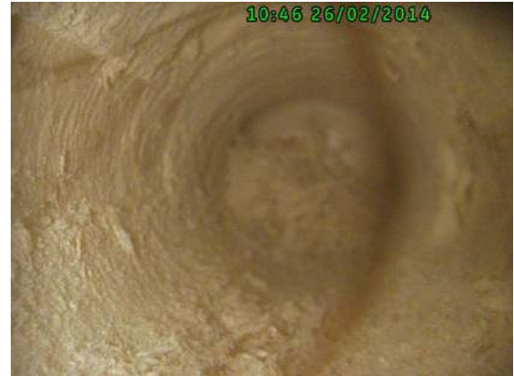
Obr. 102 Detail vrtu v trámu č. 4, jižní stěna, pozice měření č. 17
