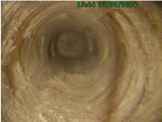
Obr. 103 Detail vrtu v trámu č. 1, jižní stěna, pozice měření č. 1
