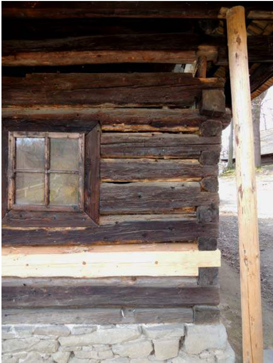
Obr. 28 Venkovní pohled na východní stěnu, pozice měření č. 3
