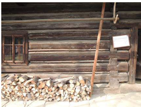
Obr. 67 Venkovní pohled na východní stěnu, pozice měření č. 6
