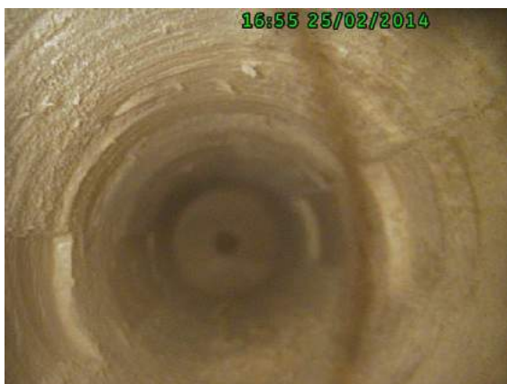
Obr. 100 Detail vrtu v trámu č. 8, východní stěna, pozice měření č. 3
