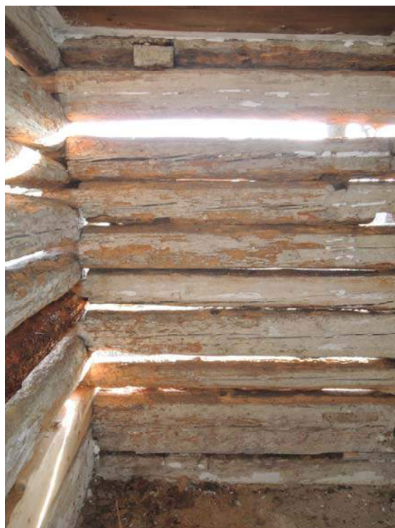
Obr. 33 Vnitřní pohled na jižní stěnu, pozice měření č. 5
