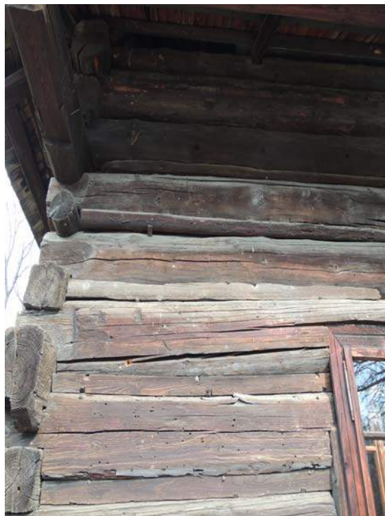
Obr. 59 Venkovní pohled na jižní stěnu, pozice měření č. 1
