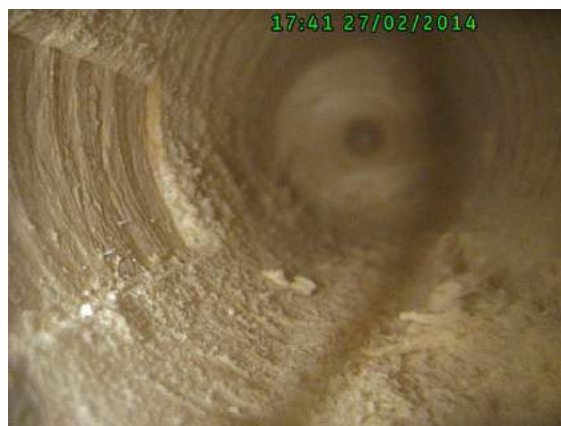
Obr. 110 Detail vrtu v trámu č. 6, západní stěna, pozice měření č. 14
