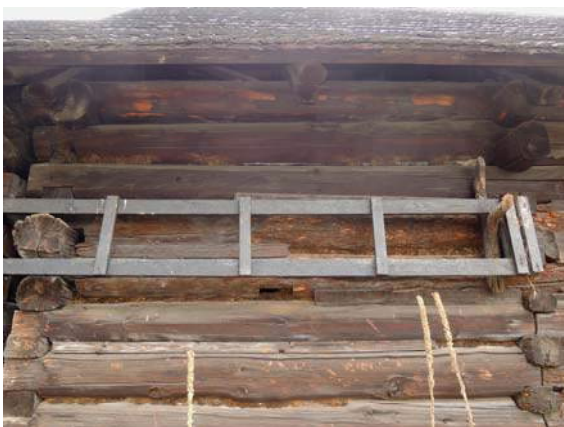
Obr. 74 Venkovní pohled na západní stěnu, pozice měření č. 12
