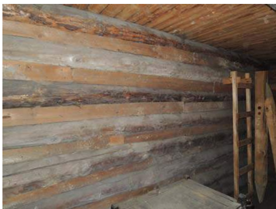
Obr. 82 Vnitřní pohled na jižní stěnu, pozice měření č. 15
