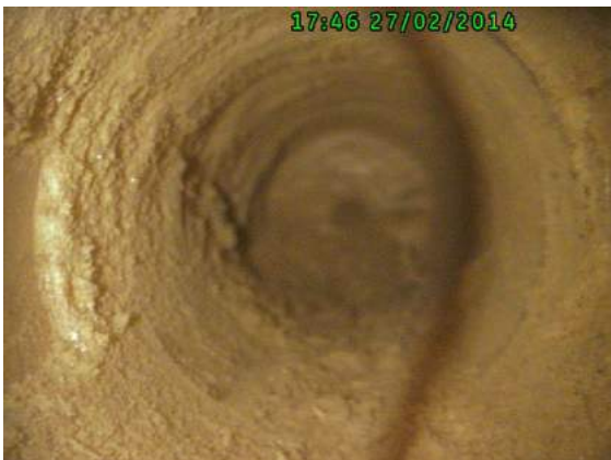
Obr. 105 Detail vrtu v trámu č. 2, jižní stěna, pozice měření č. 4
