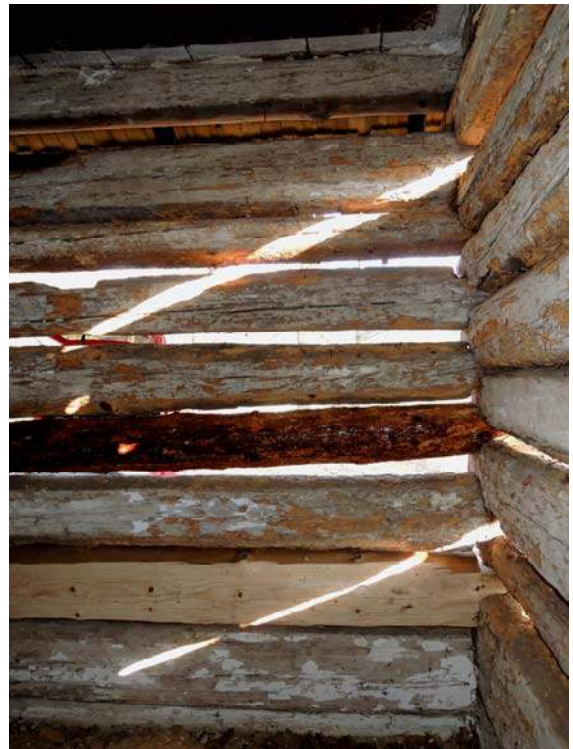
Obr. 31 Vnitřní pohled na východní stěnu, pozice měření č. 4
