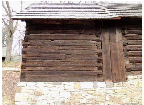
Obr. 7 Jižní stěna chléva
