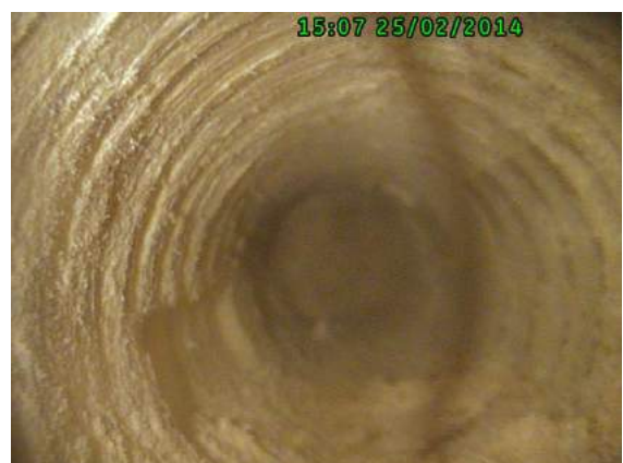
Obr. 97 Detail vrtu v trámu č. 8, jižní stěna, pozice měření č. 5
