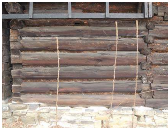
Obr. 75 Venkovní pohled na západní stěnu, pozice měření č. 12
