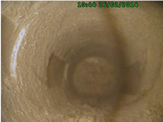
Obr. 101 Detail vrtu v trámu č. 3, jižní stěna, pozice měření č. 17
