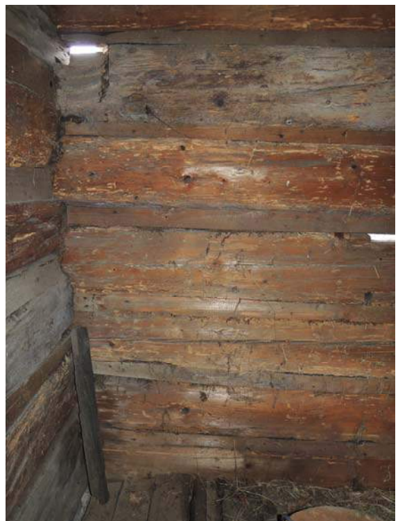
Obr. 53 Vnitřní pohled na jižní stěnu, pozice měření č. 17
