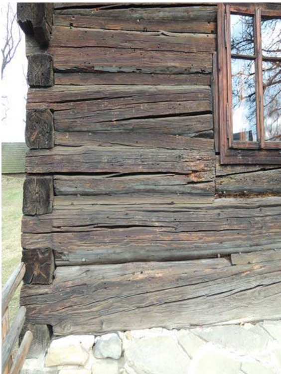
Obr. 58 Venkovní pohled na jižní stěnu, pozice měření č. 1
