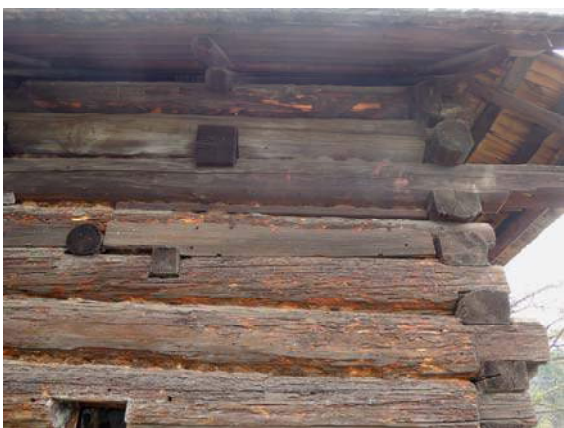
Obr. 78 Venkovní pohled na západní stěnu, pozice měření č. 14
