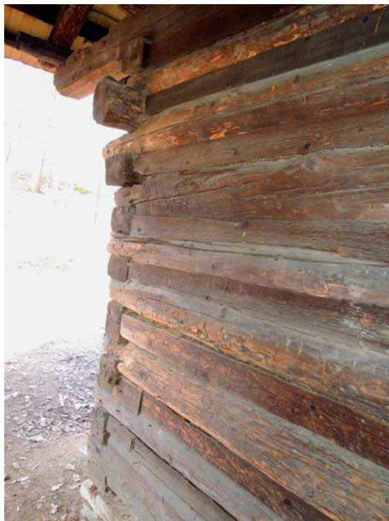
Obr. 39 Venkovní pohled na západní stěnu, pozice měření č. 9
