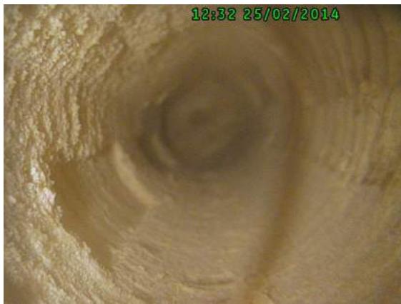
Obr. 92 Detail vrtu v trámu č. 4, východní stěna, pozice měření č. 3
