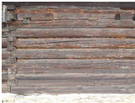
Obr. 77 Venkovní pohled na západní stěnu, pozice měření č. 13
